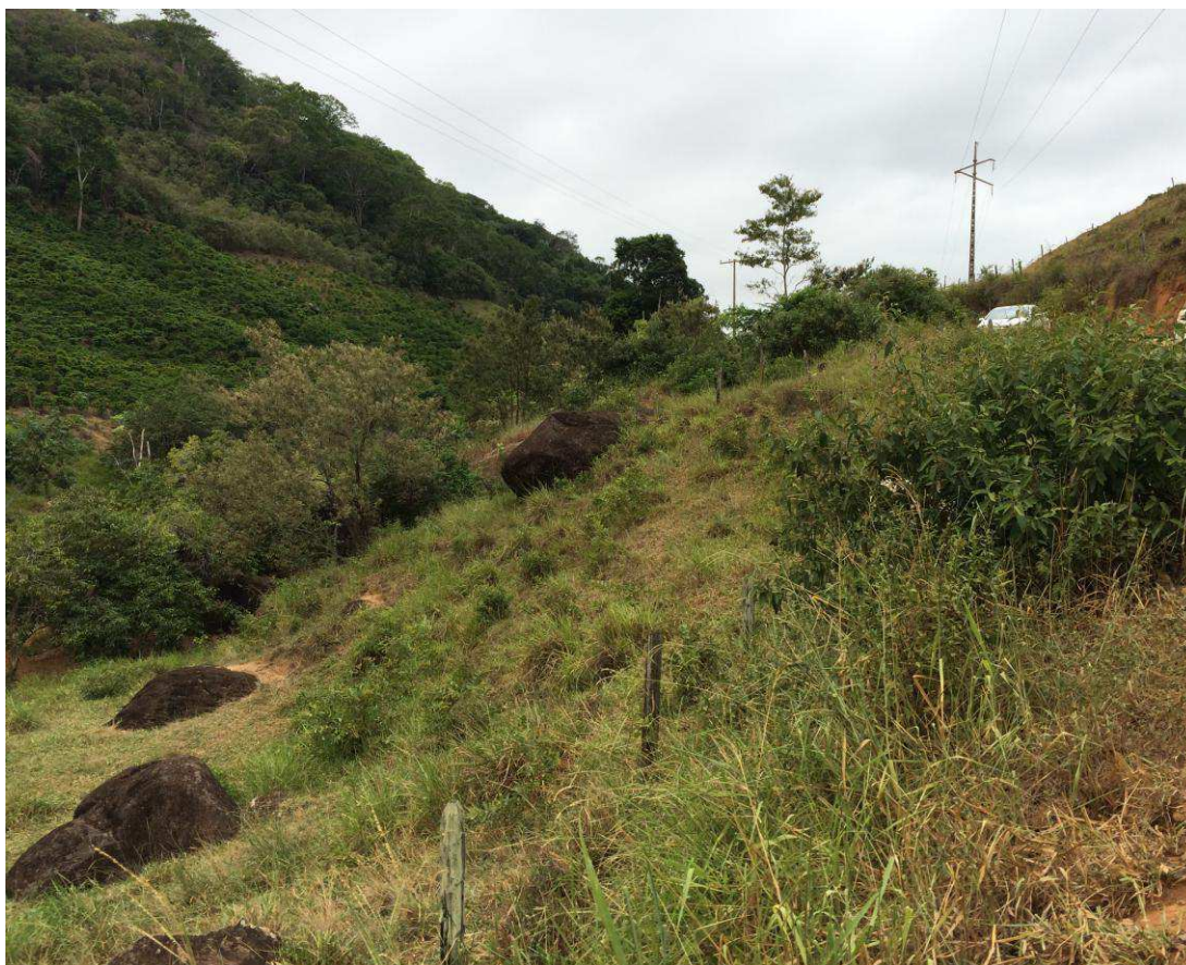
Figura 3 – Vista Geral localização da ETA.
