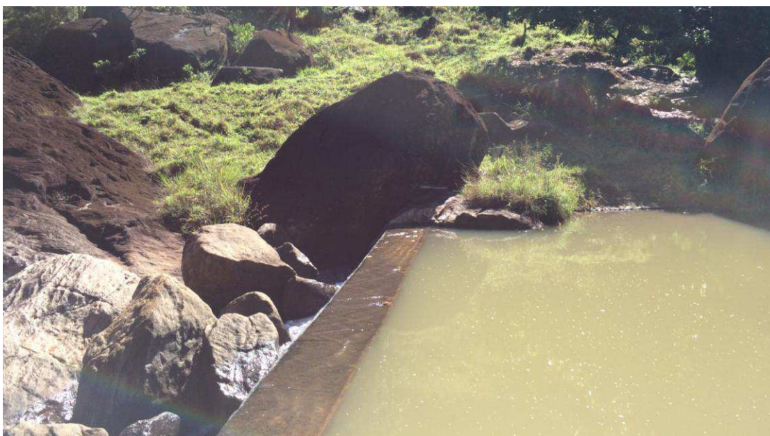
Figura 2 – Vista Geral Barragem (Captação).
