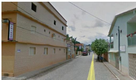
Figura 3-12 - Hotel na Rua Manoel F. Souza.
