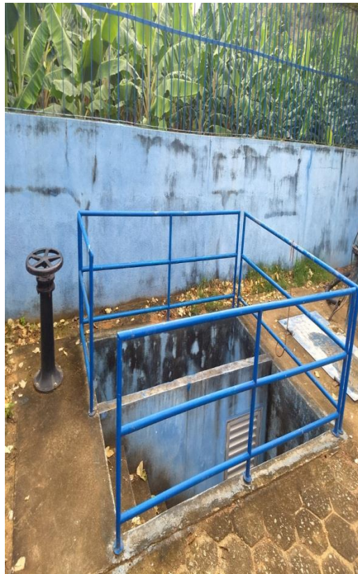
Figura 34.1 – Área Interna EEEB.
