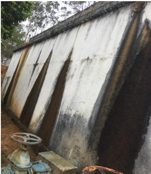
Figura 43 – Vazamento no Reservatório. Figura 44 – Fissura no Reservatório.
