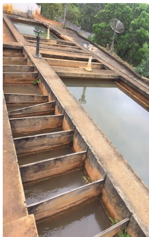
Figura 16 – Decantadores.
