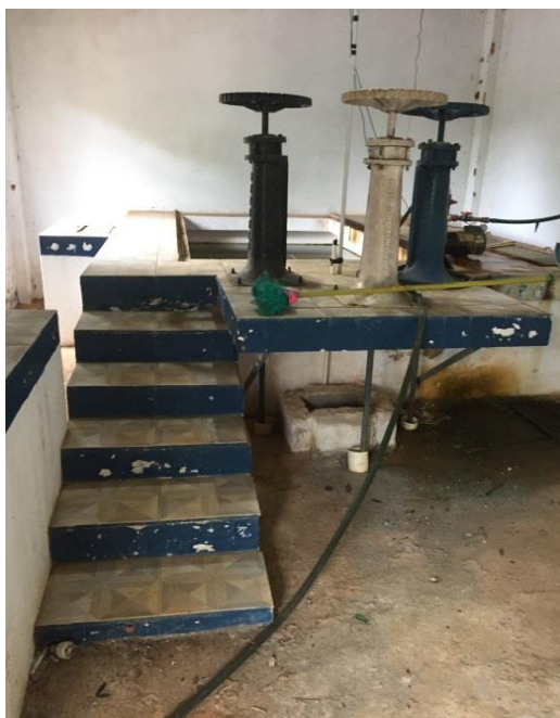
Figura 19 – Escadas de acesso aos filtros.
