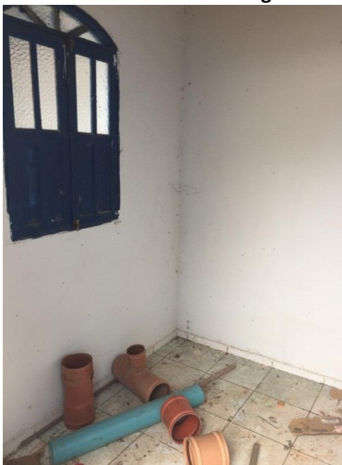
Figura 28 – Sala de apoio operacional.
