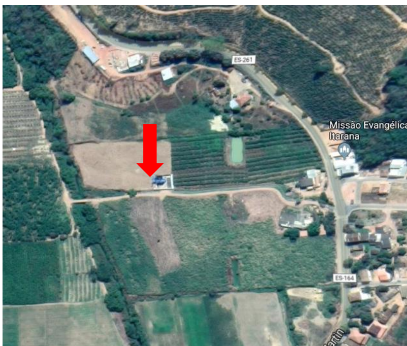
Figura 26 – ETE de Itarana.
