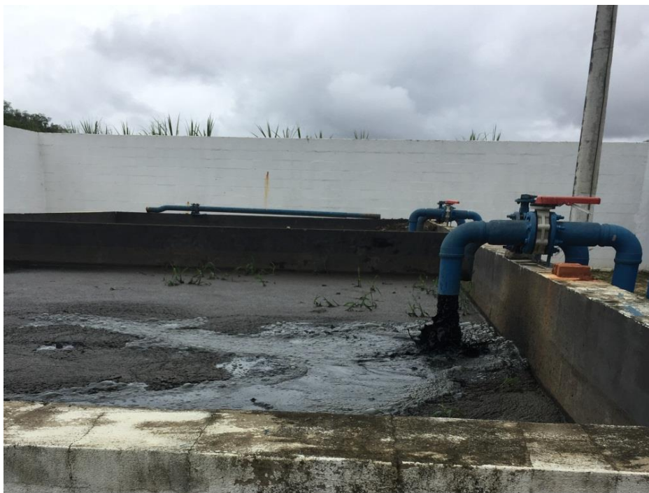
Figura 34 –Leito de Secagem
