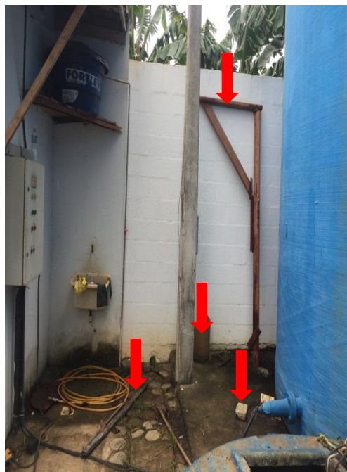
Figura 29 – Área externa ETE.
