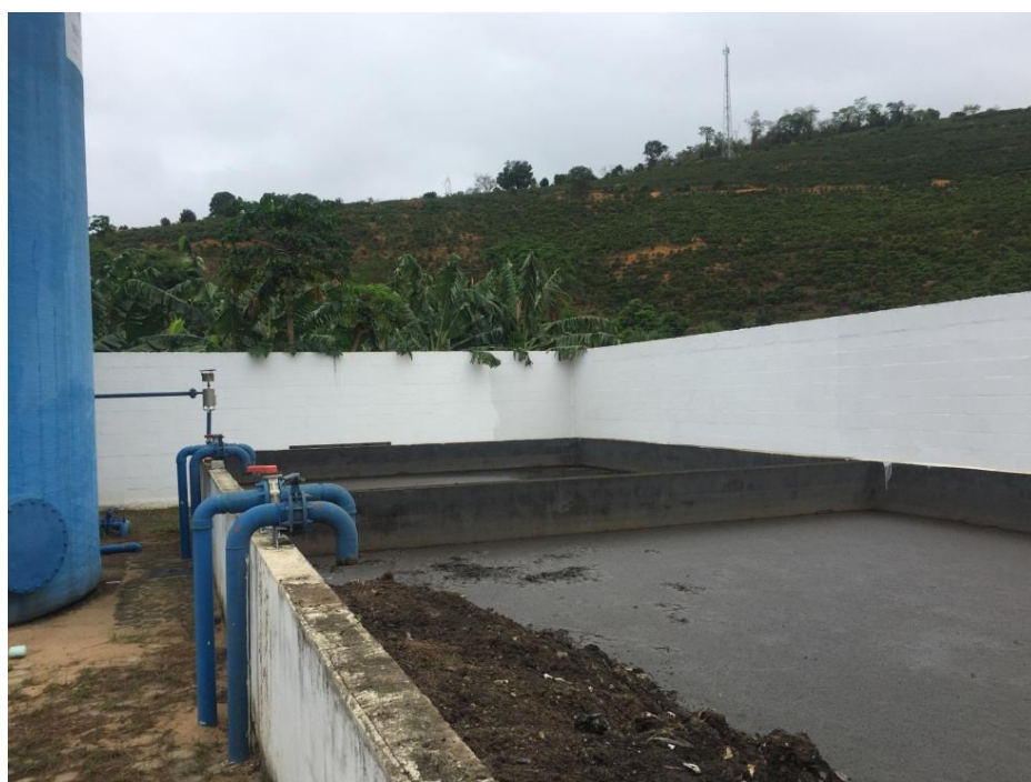
Figura 35 –Leito de Secagem
