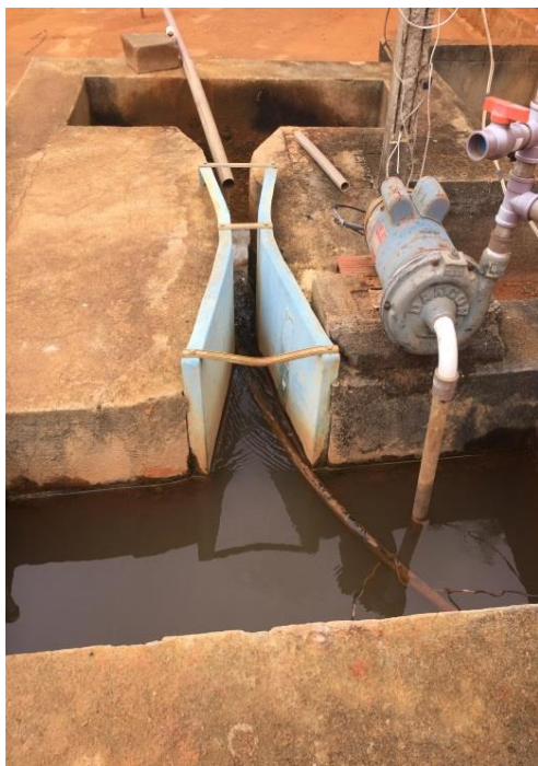
Figura 12 – Dosagem na calha pascal
