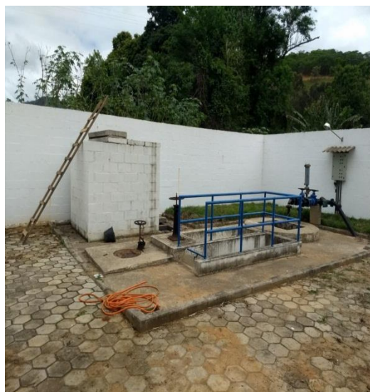
Figura 28.1 – Área Interna EEEB.
