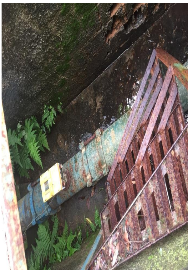
Figura 42 – Macromedicação sem funcionar.
