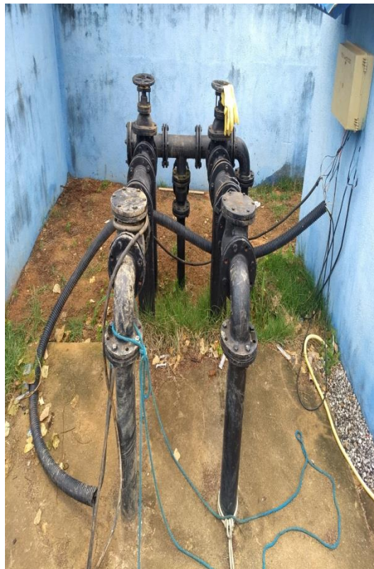
Figura 36.1 – Tubulação EEEB.
