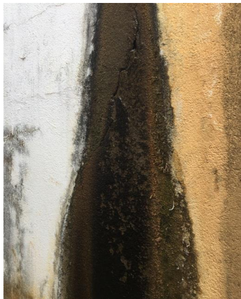
Figura 43 – Vazamento no Reservatório. Figura 44 – Fissura no Reservatório.
