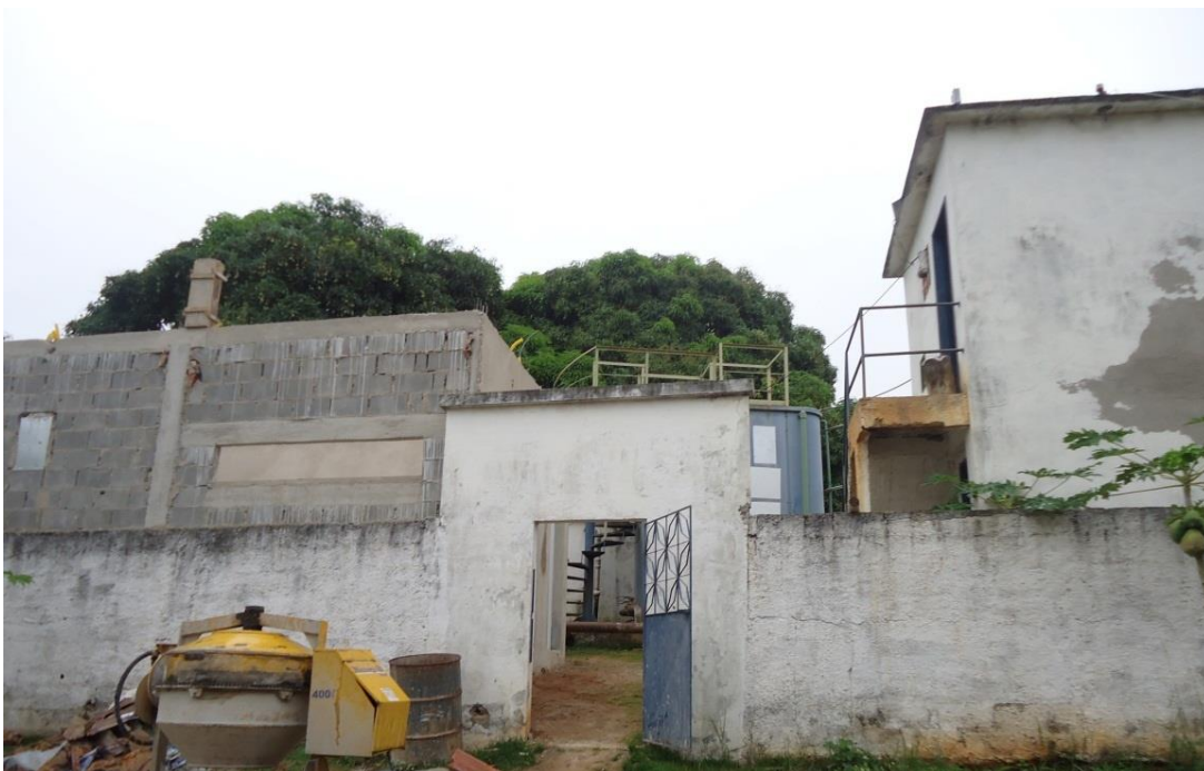
Figura 58 – Entrada da ETA do Distrito Itaimbé.
