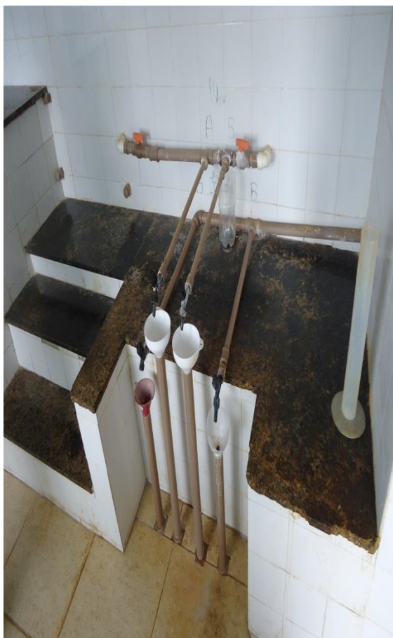
Figura 9– Dosador de cloro e flúor.
