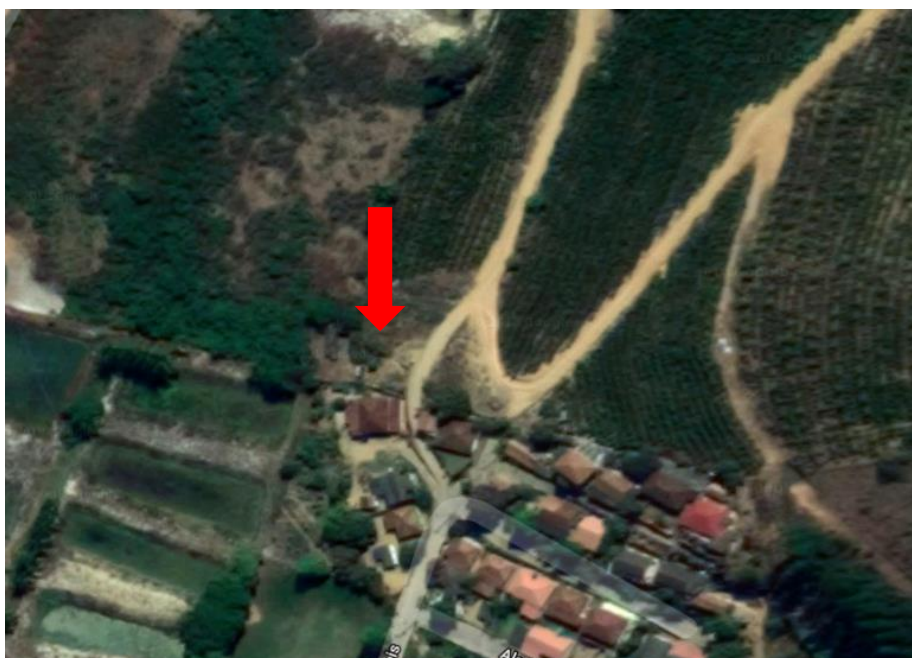
Figura 140 – ETE Fossa Filtro do Distrito de Itaçu.
