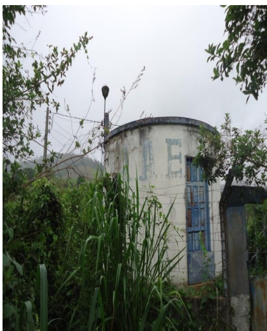
Figura 54 – EEAB de Itaimbé.
