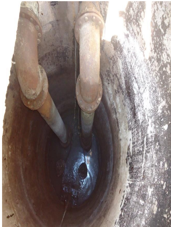
Figura 117 – Poço de Sucção.
