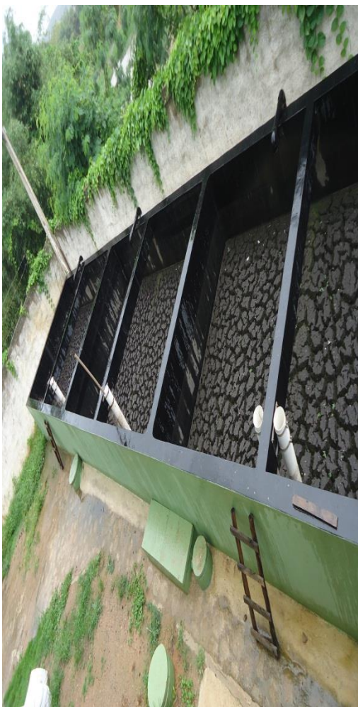
Figura 121 – Leito de Secagem.
