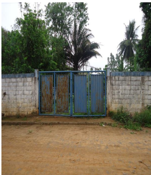
Figura 131 – Acesso ETE Fossa Filtro Distrito de Itaimbé.
