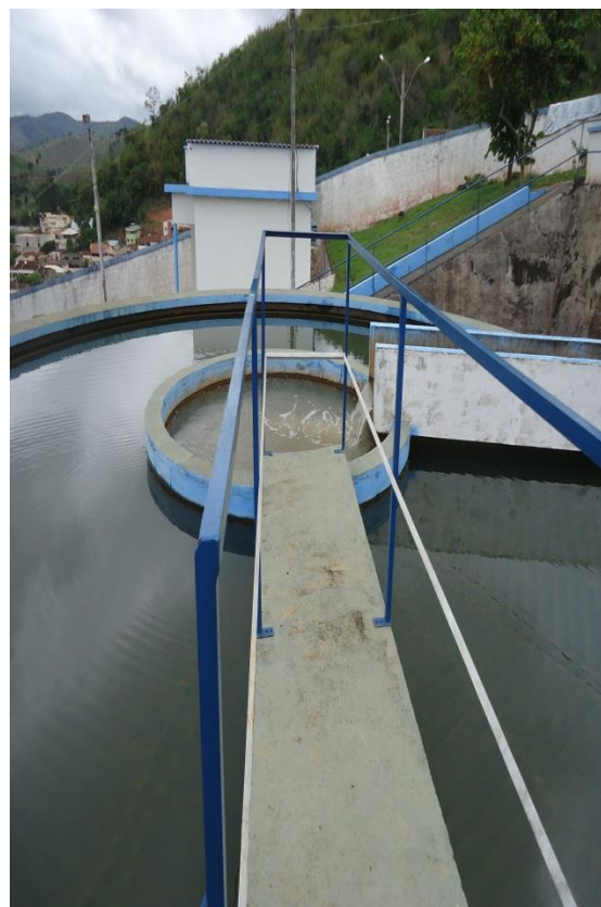
Figura 13 – Decantador 1.
