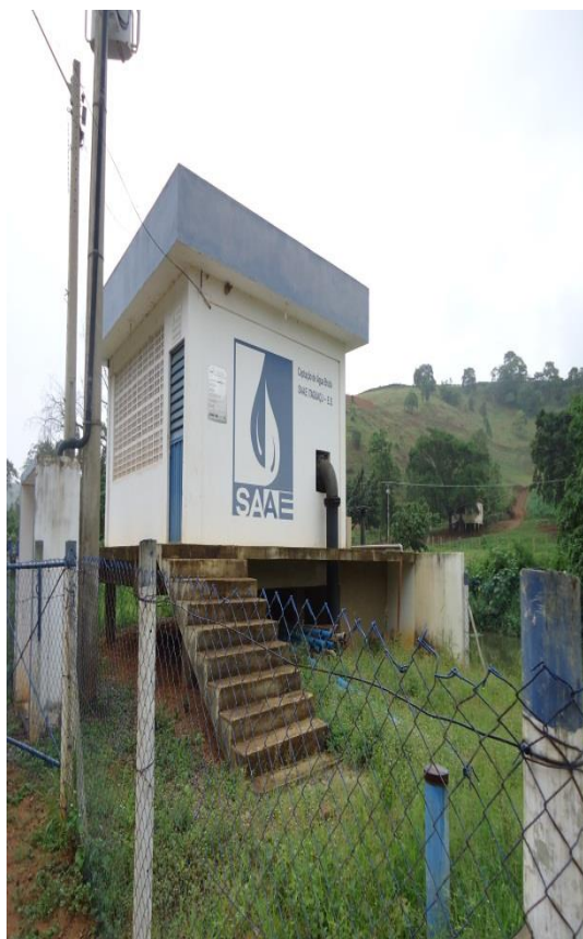
Figura 1 – Local de Captação.
