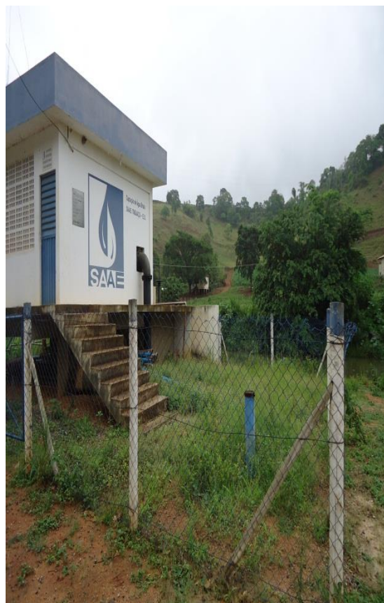
Figura 2 – Acesso EEAB da Sede de Itaguaçu.
