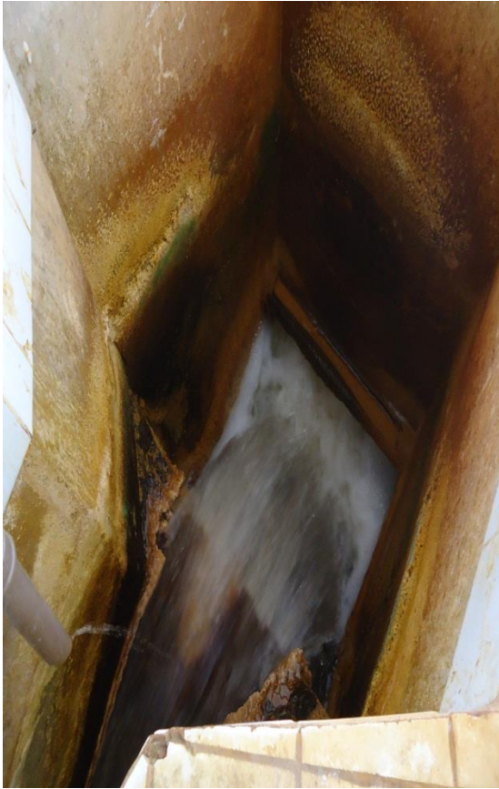
Figura 10 – Calha parshall.
