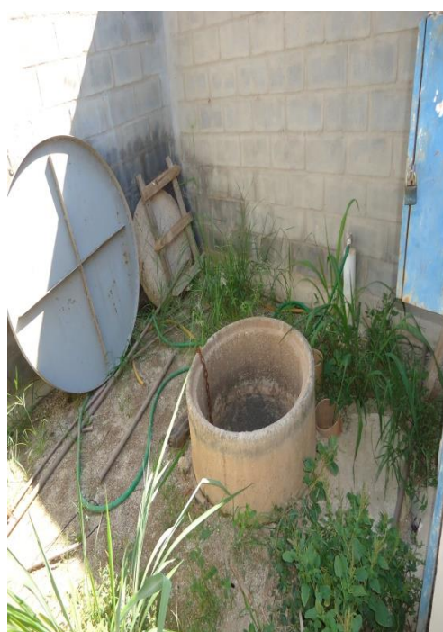
Figura 163- Poço de sucção.
