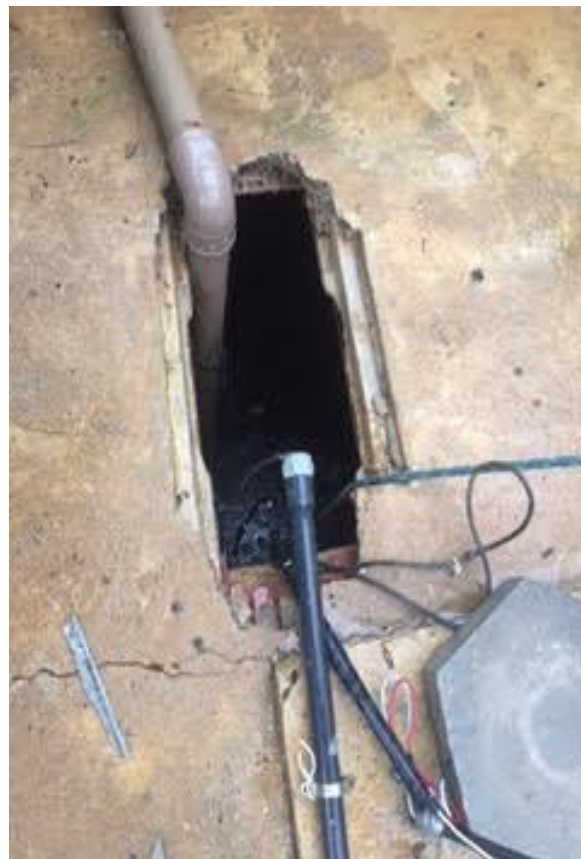
Figura 160- Poço de Sucção.
