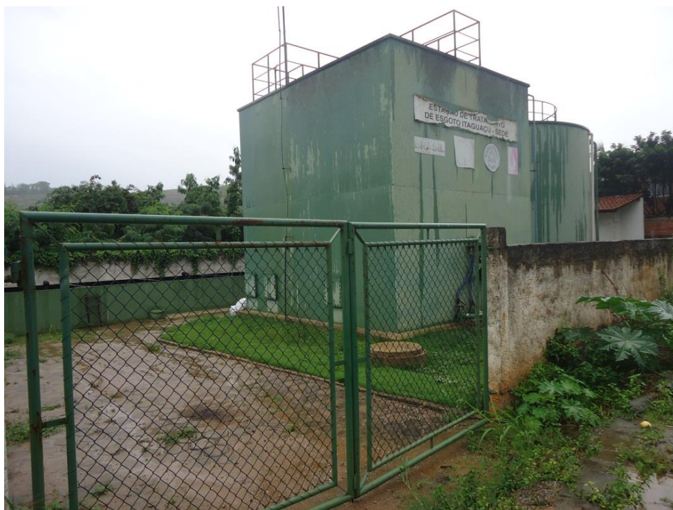
Figura 118 – ETE da Sede de Itaguaçu.
