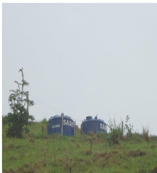
Figura 46 – Reservatório da EEAT.
