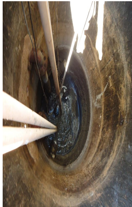
Figura 105 – Poço de Sucção.
