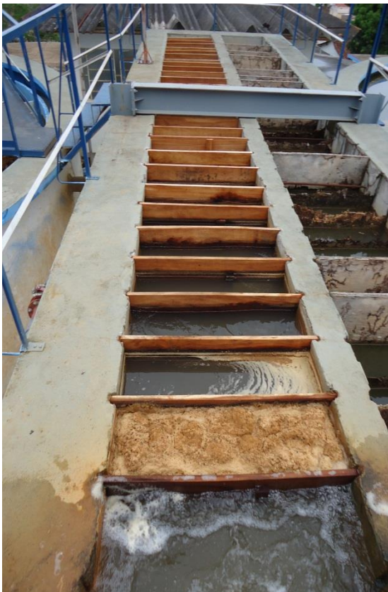
Figura 12 – Floculador Danificado
