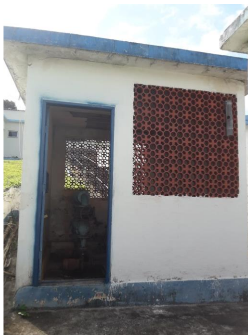
Figura 33 – Acesso a EEAT.
