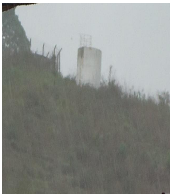
Figura 43 – Reservatório da EEAT.
