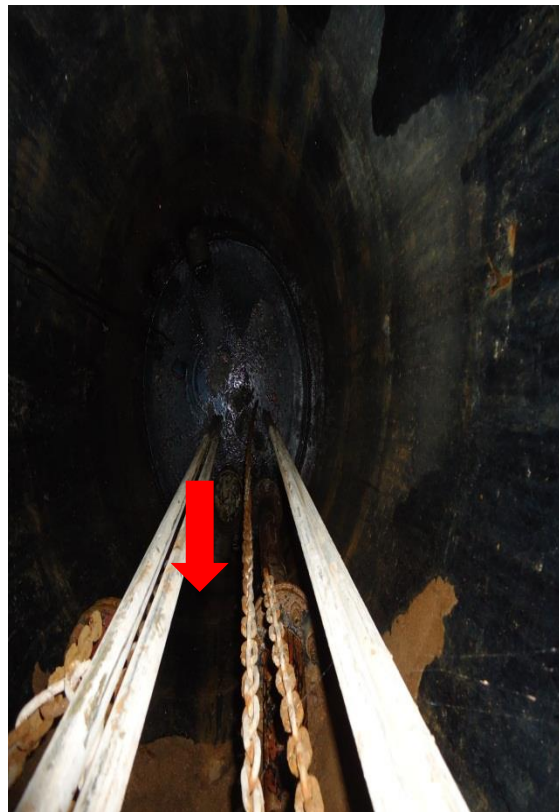
Figura 109 – Poço de Sucção.
