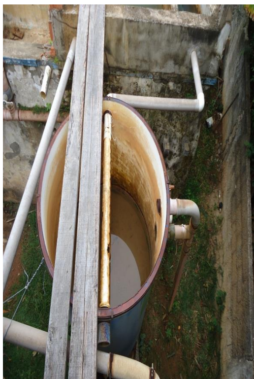
Figura 80 – Excesso corrosão.
