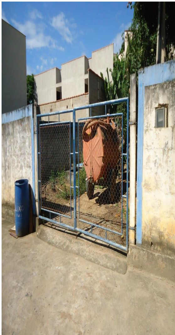
Figura 113 – EEEB do Centro.
