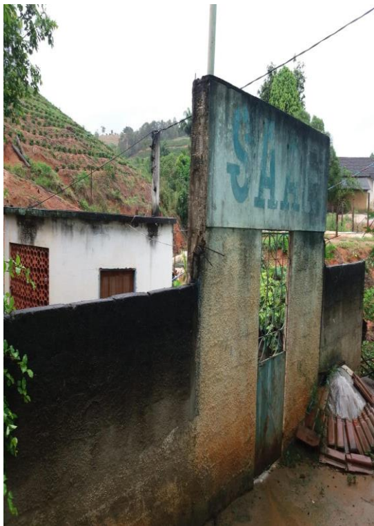
Figura 88 – EEAB de Itaçu.
