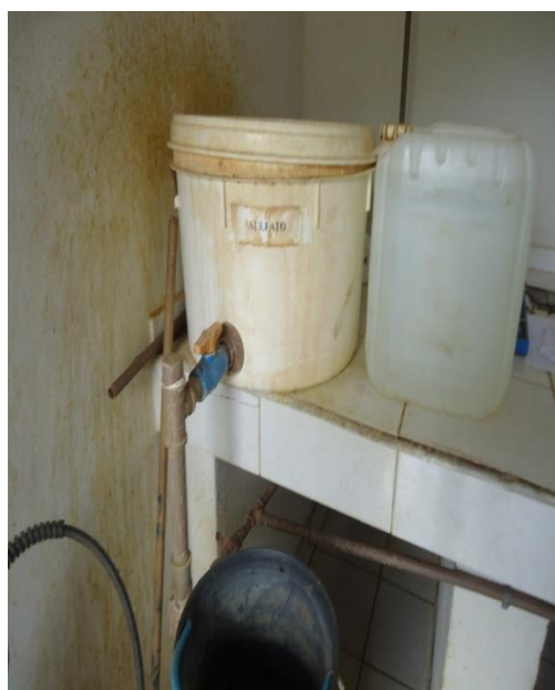
Figura 74 – Dosagem do sulfato.
