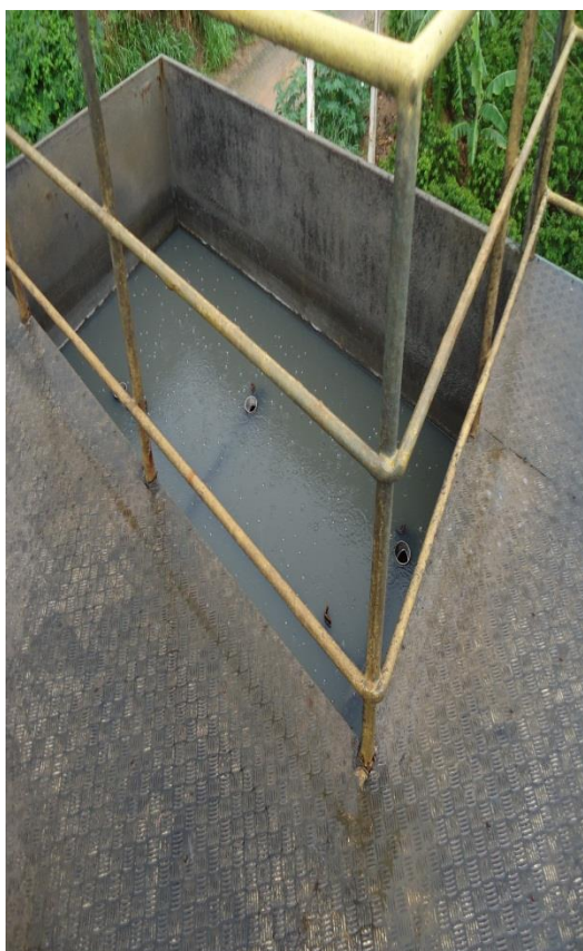
Figura 127 – Passarela de Acesso.
