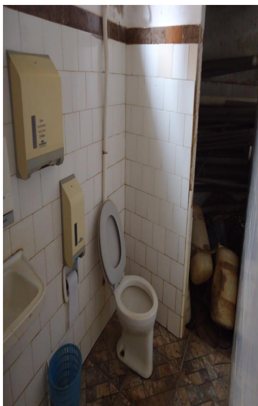
Figura 147 - Banheiros disponíveis para funcionários.
