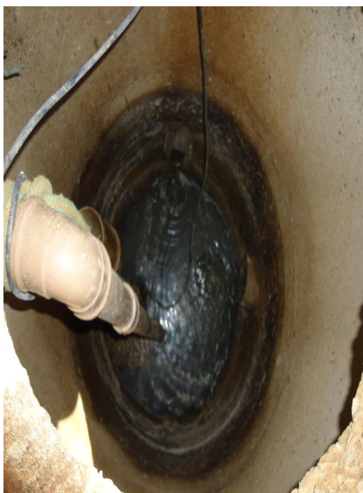
Figura 111 – Poço de Sucção.
