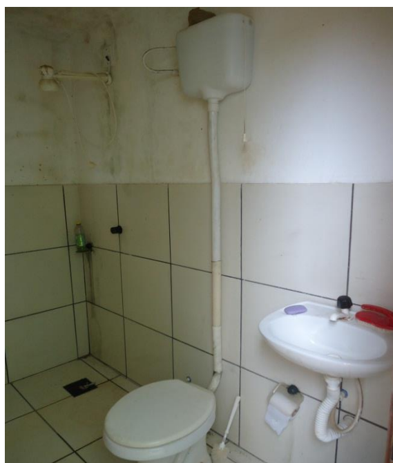
Figura 119 – Banheiro da ETE da Sede Itaguaçu.
