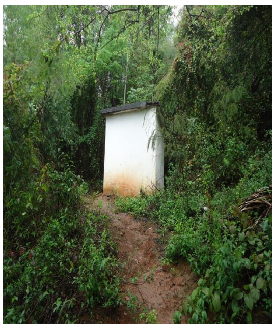
Figura 51 – EEAT Lírio Campo.
