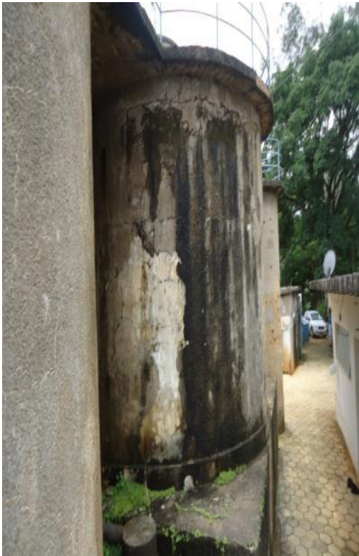
Figura 15 – Decantador com fissura.
