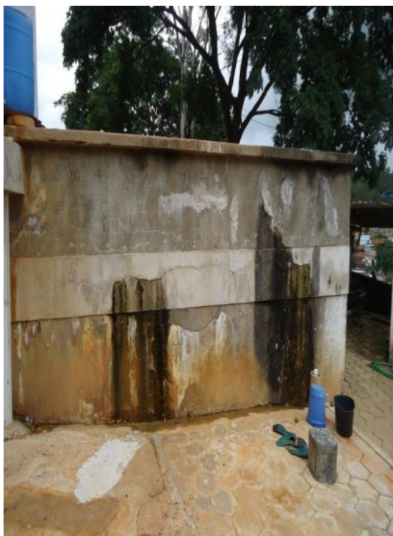
Figura 28– Reservatório 1 com fissura estrutural.
