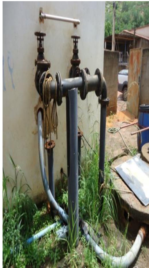
Figura 106 – Excesso de Vegetação.
