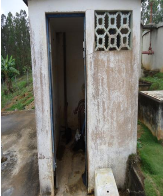
Figura 90 – EEAT na ETA Novo Brasil.
