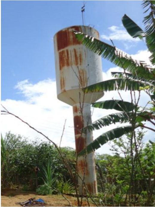
Figura 56 – Reservatório de lavagem dos filtros.
