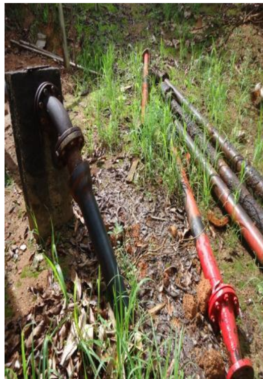
Figura 69 – Excesso de Vegetação.
