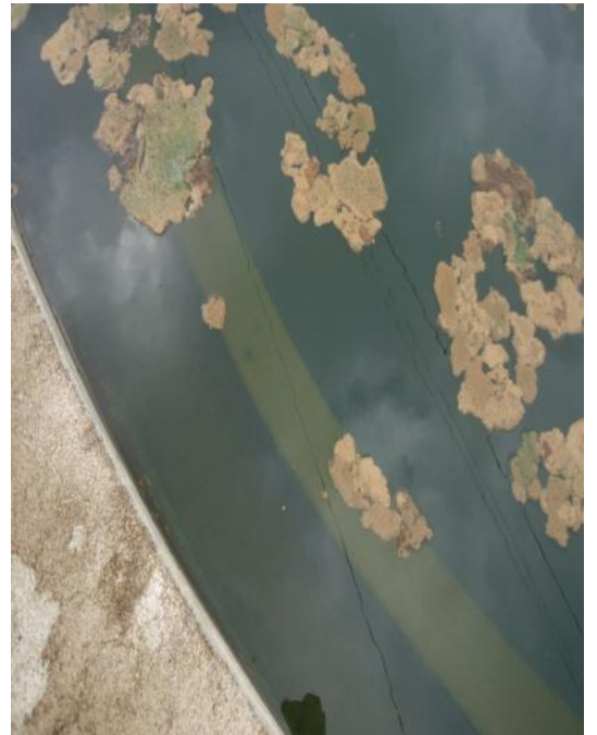
Figura 78 – Decantadores com lodo.
