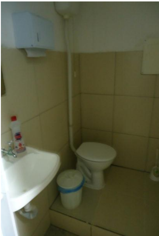
Figura 127 - Banheiros disponíveis para funcionários.
