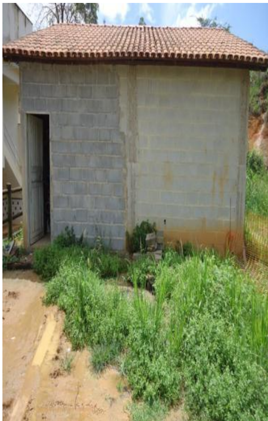
Figura 36 – Casa de bomba EEAT Morada do sol.
