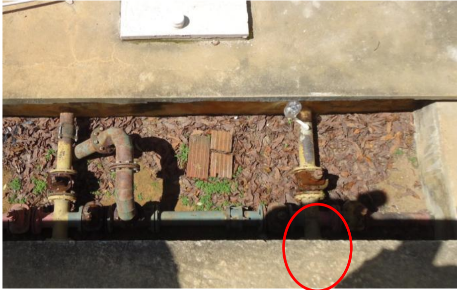
Figura 54 – Vazamento na Tubulação.
