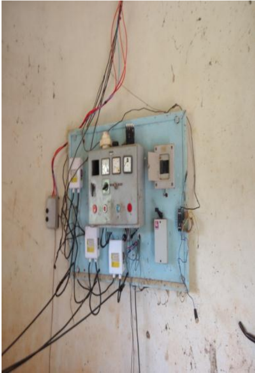
Figura 3 – Painel de Comando.
