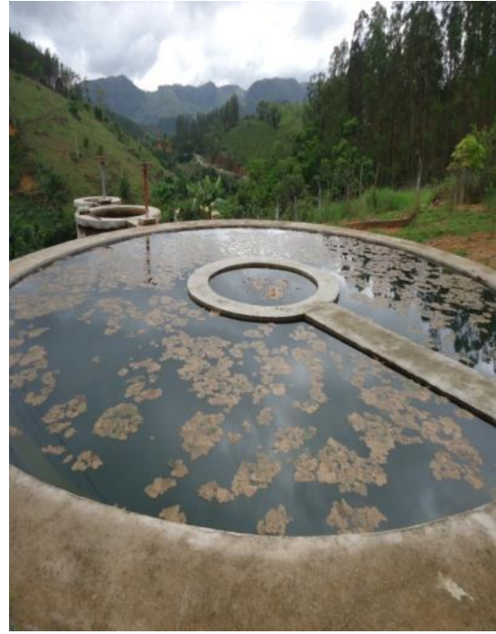
Figura 75 – Unidade de Floculação adequada. Figura 76 – Decantador 1.
