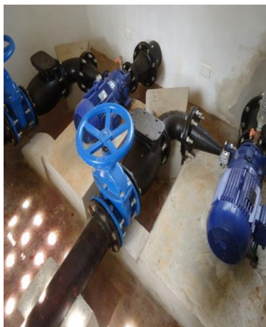
Figura 65 – Conjunto Moto-bomba EEAB.
