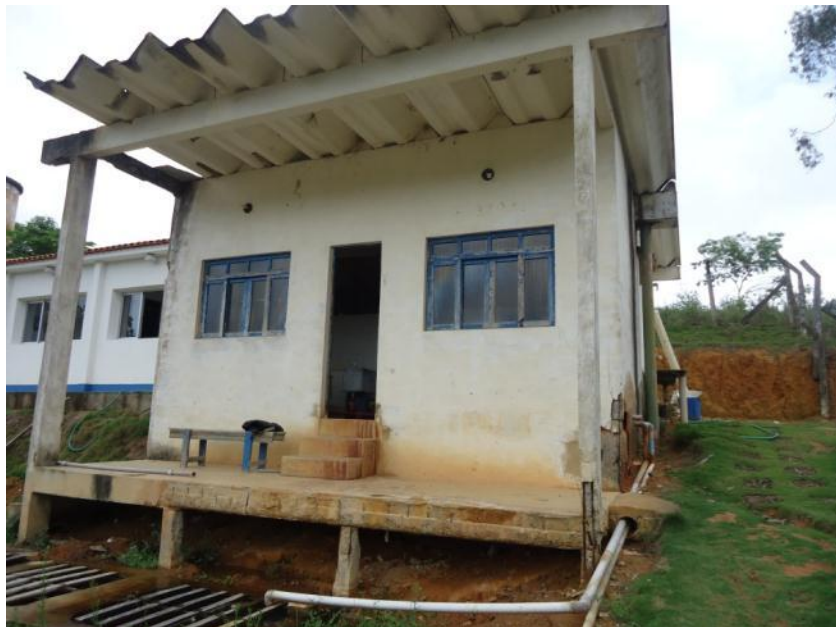
Figura 89 – Casa Química da ETA Novo Brasil.
