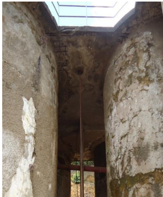
Figura 17 – Laje com ferragem exposta.
