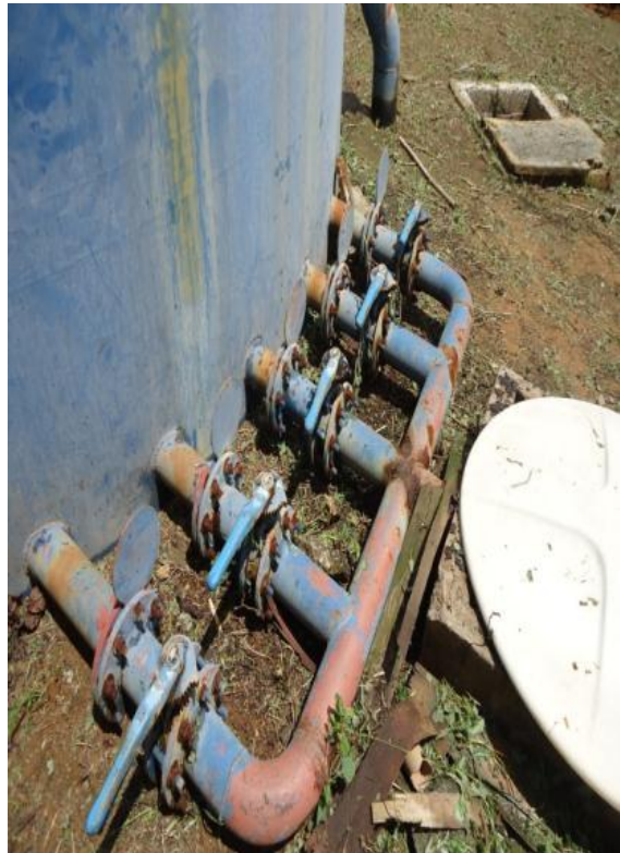
Figura 115 – Excesso de Corrosão.
