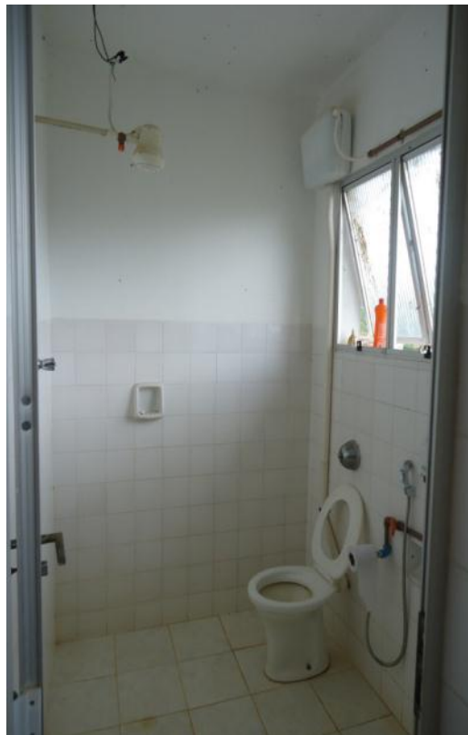
Figura 22 – Banheiro ETA da Sede.
