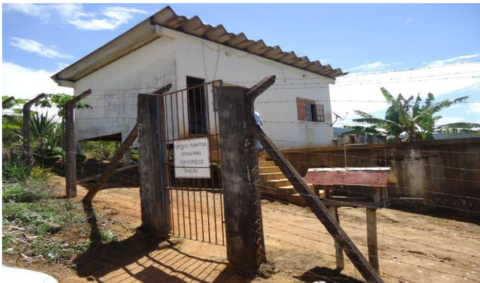
Figura 46 – Entrada da ETA do Distrito de Moacyr Ávidos.
