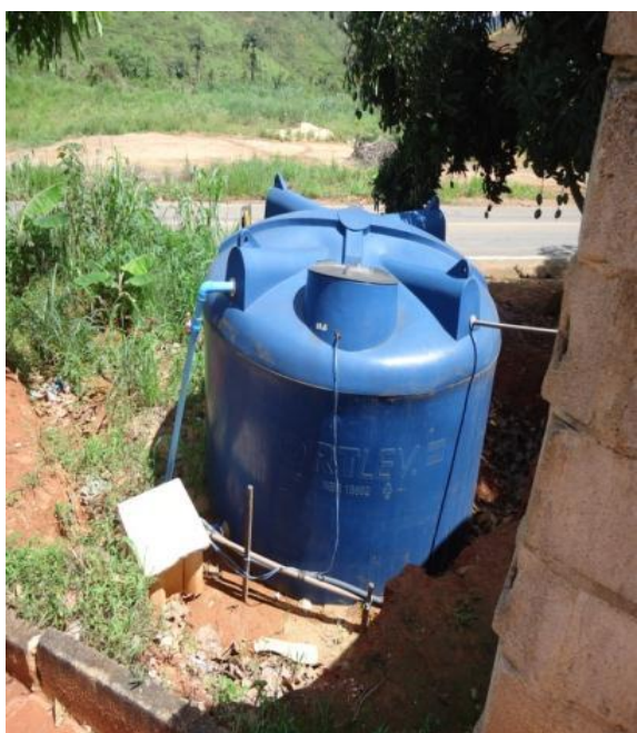
Figura 62 – EEAT sem cerca ou parede.
