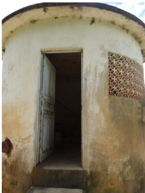
Figura 1 – Local de Captação.
