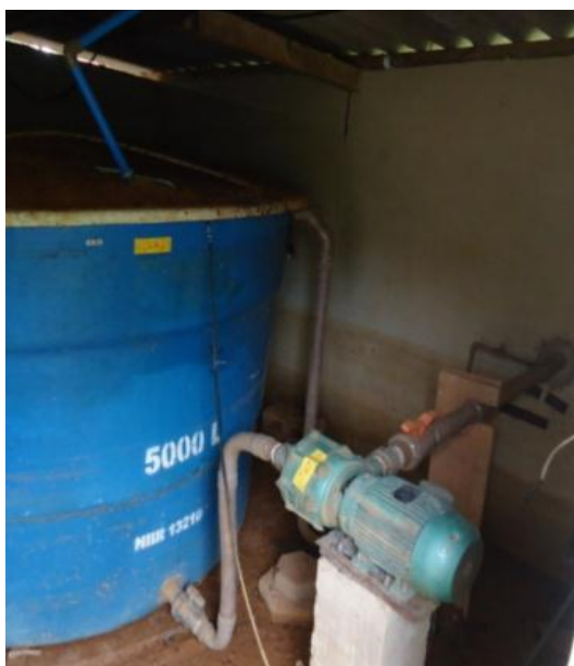
Figura 34 – Conjunto Moto-Bomba da EEAT. Figura 35 – Acesso ao Reservatório da EEAT.
