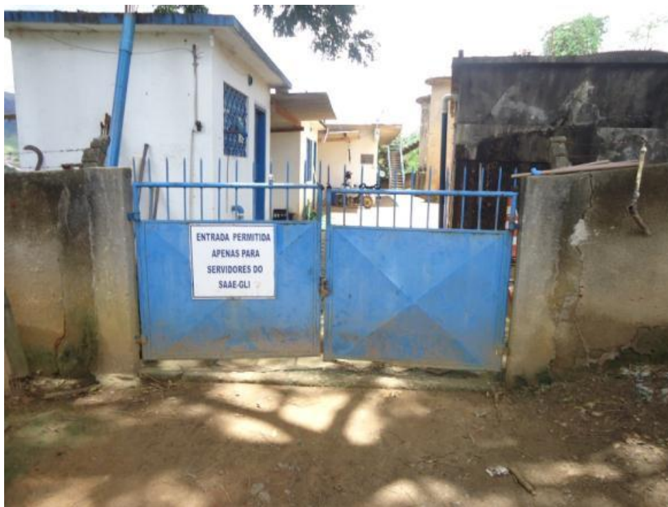
Figura 6 – Entrada da ETA Sede de Governador Lindenberg.
