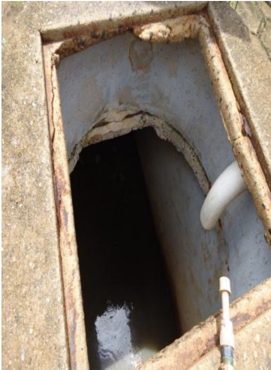
Figura 107 – Entrada do Efluente.
