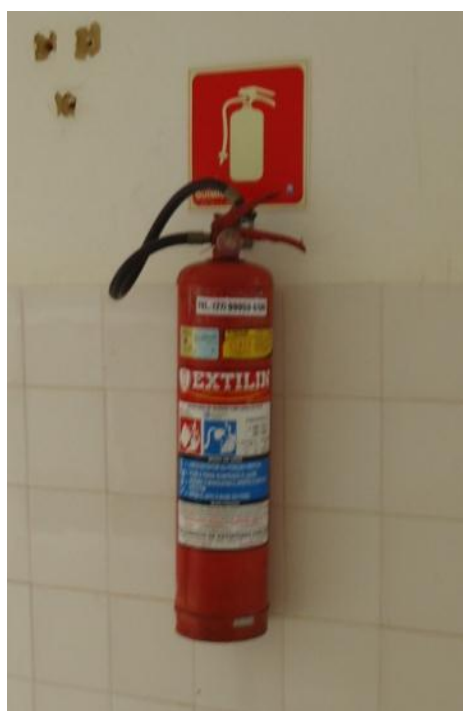
Figura 23 – Extintor de incêndio.
