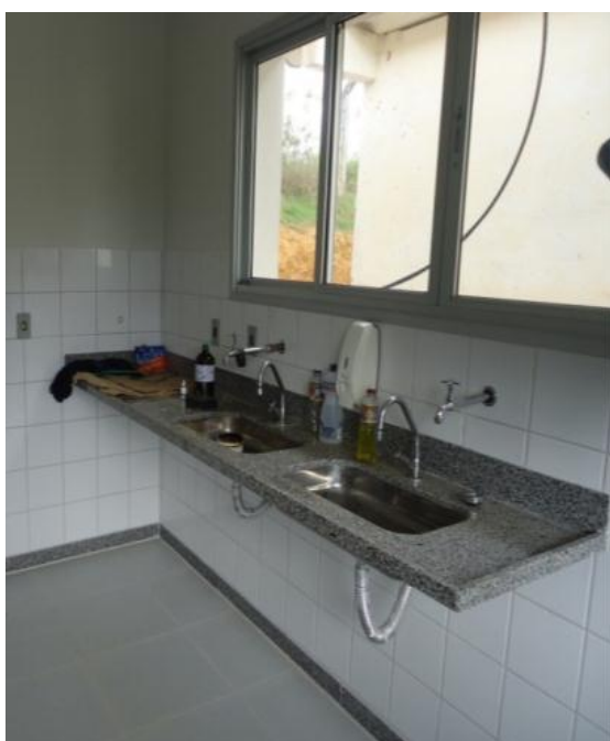
Figura 82 – Laboratório ETA Novo Brasil.
