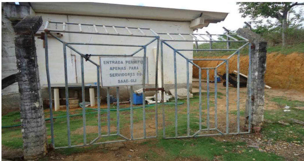
Figura 70 – Entrada da ETA do Distrito de Novo Brasil.
