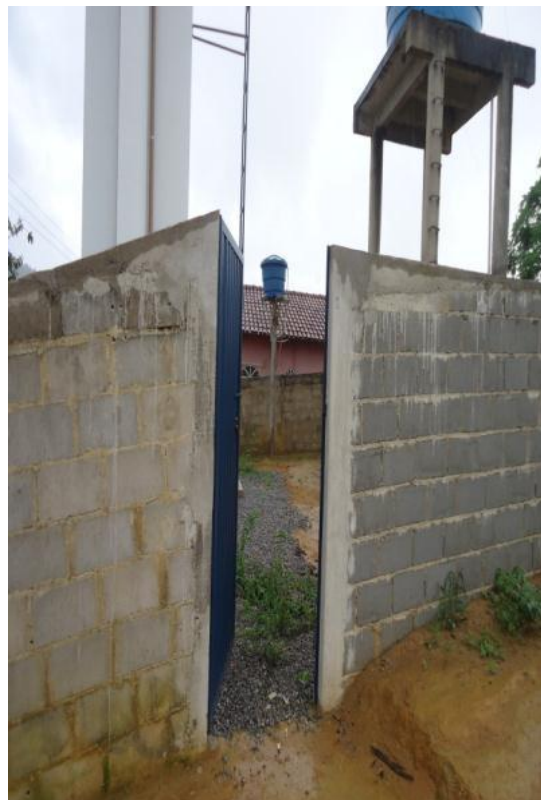
Figura 97– Acesso ao Reservatório 4.
