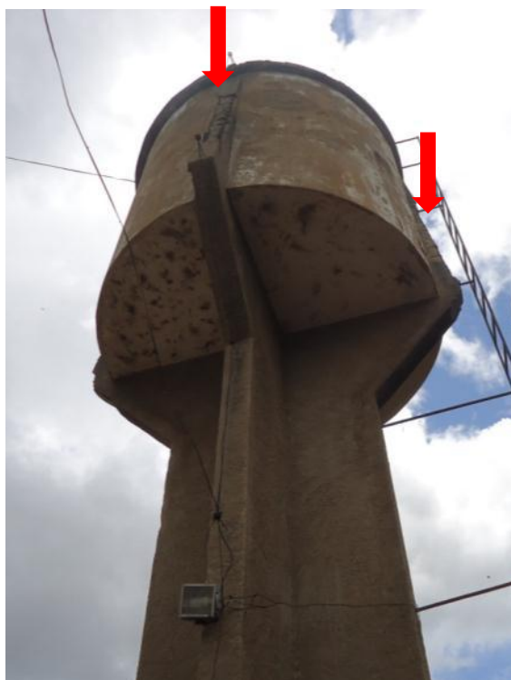
Figura 30– Reservatório 2 ferro estrutural exposto.
