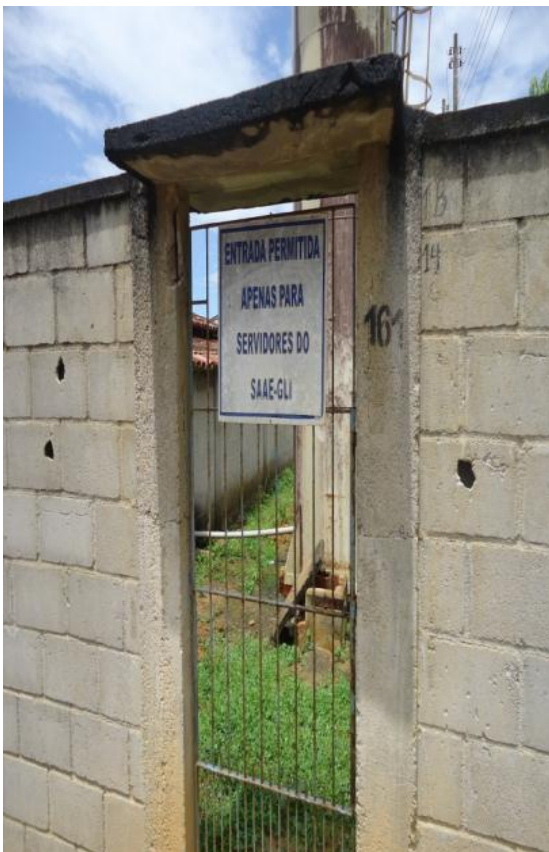
Figura 40 – Acesso ao Reservatório da EEAT.
