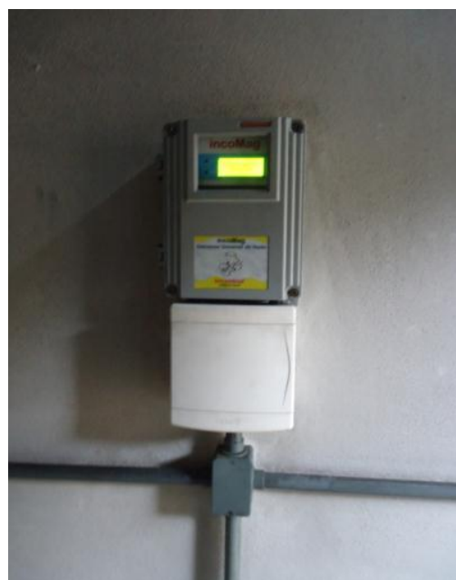
Figura 27 – Conversor do Macromedidor.
