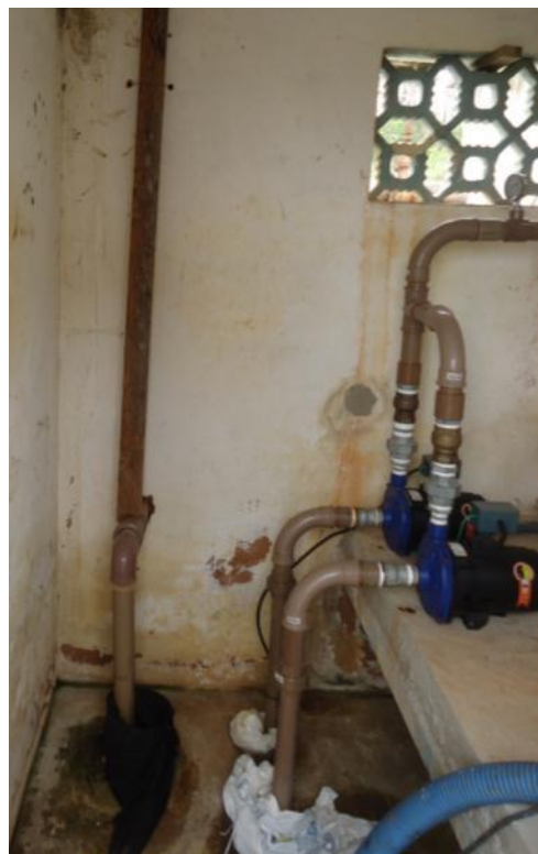
Figura 92 – Conjunto Moto-Bomba EEAT.
