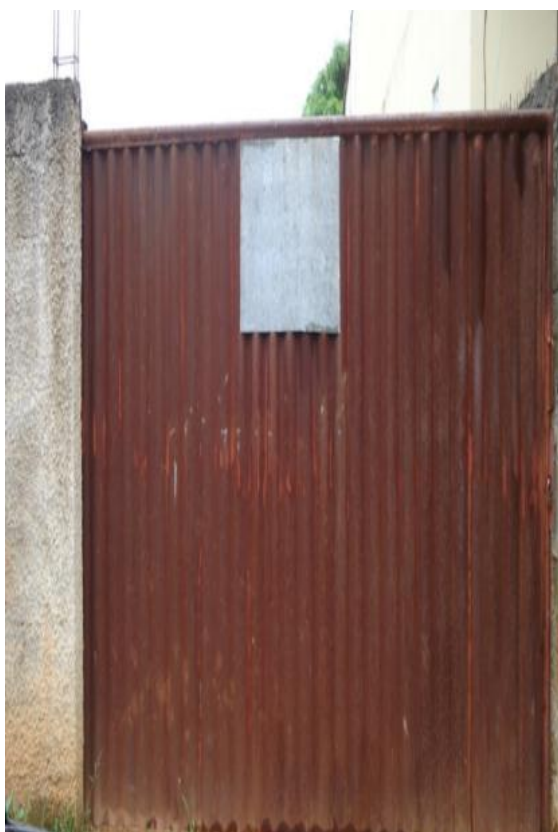
Figura 99– EEEB de Nova Brasília.
