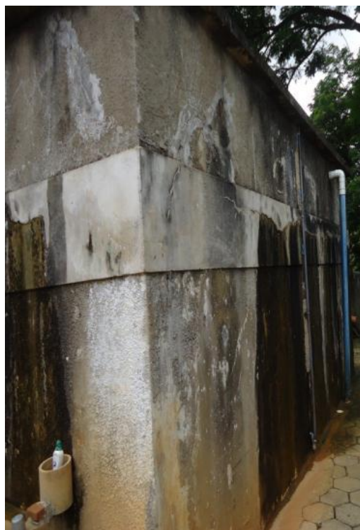
Figura 29– Reservatório 1 com Vazamento.
