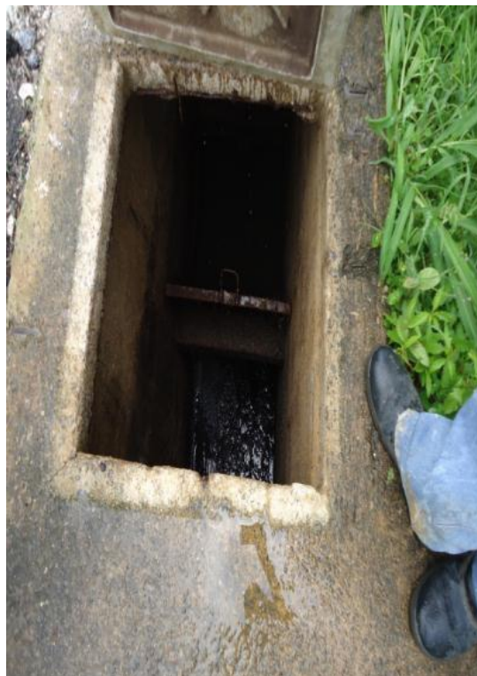
Figura 102 – Entrada do Efluente.
