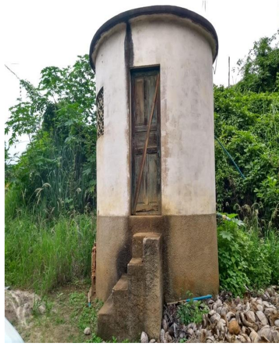
Figura 45 – Excesso de Vegetação.
