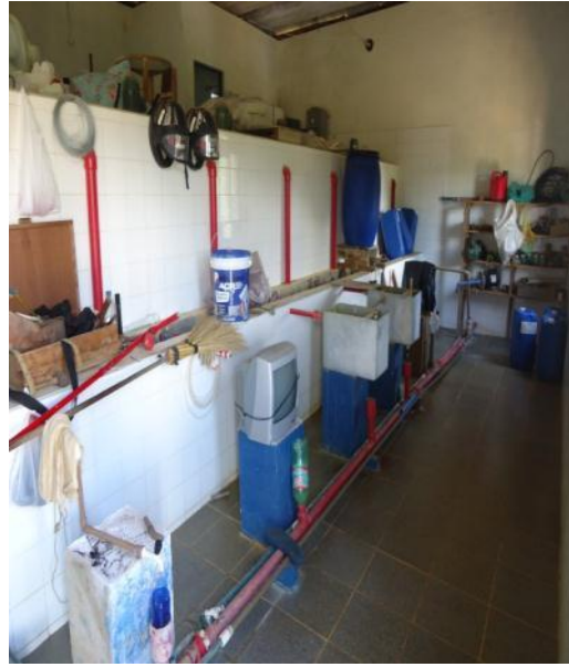
Figura 47 – Escada de Acesso casa química. Figura 48 – Dosadores de Cloro, Sulfato e Flúor.
