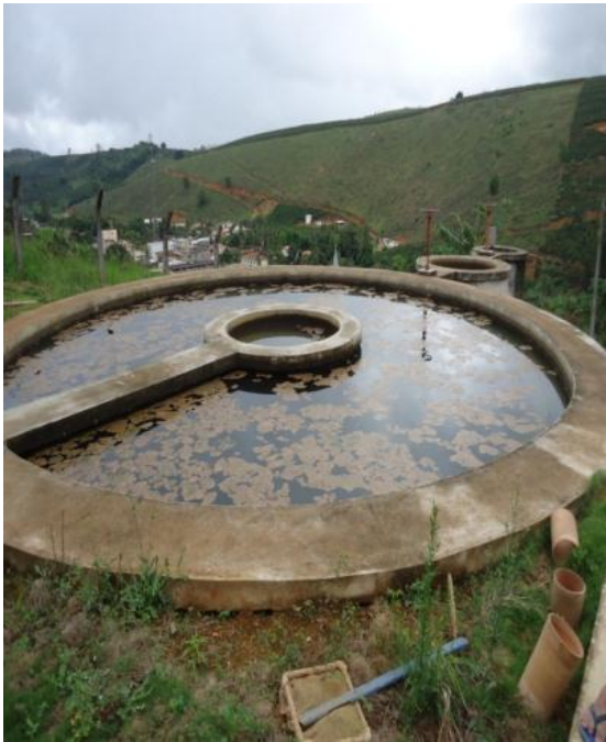
Figura 77 – Decantador 2.
