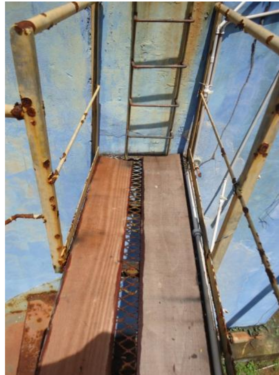
Figura 119 – Passarela de Acesso.
