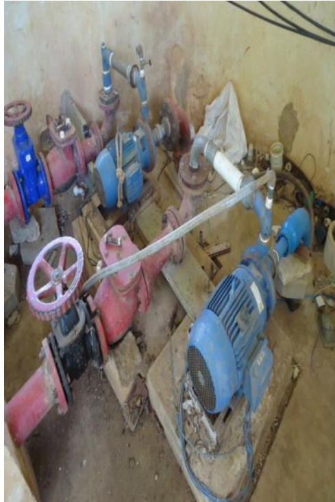
Figura 4 – Conjunto Motor-Bomba da EEAB.
