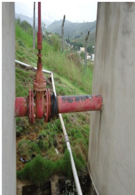
Figura 81 – Tubulação com vazamento.
