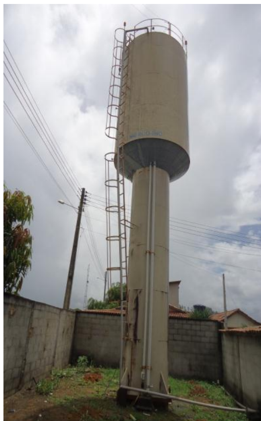
Figura 41 – Reservatório da EEAT.
