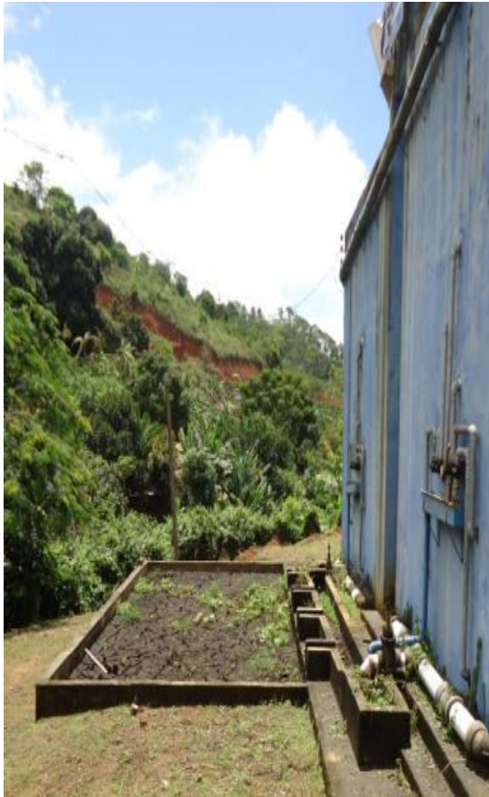
Figura 112 – Leito de Secagem.
