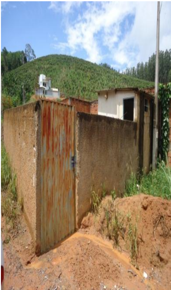
Figura 105 – EEEB do Centro.
