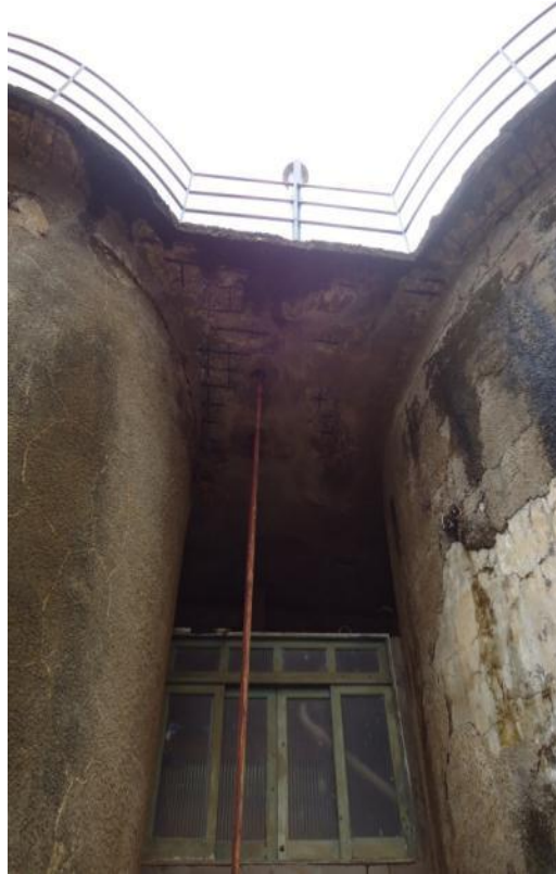
Figura 16 – Laje com ferragem exposta.
