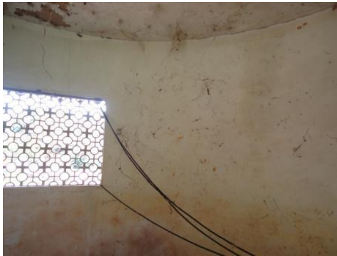
Figura 5 - Paredes da EEAB da Sede de Governador Lindenberg necessitando de limpeza.
