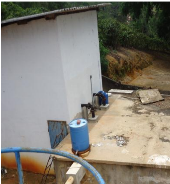
Figura 24 – Casa de Bomba EEAT da ETA.
