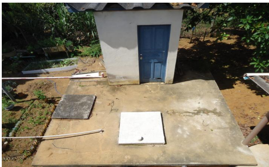
Figura 55 – Reservatório da ETA Distrito Moacyr Avidos.
