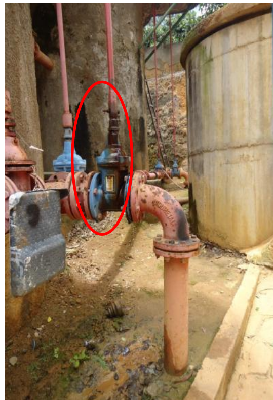
Figura 14 – Tubulação com vazamento.
