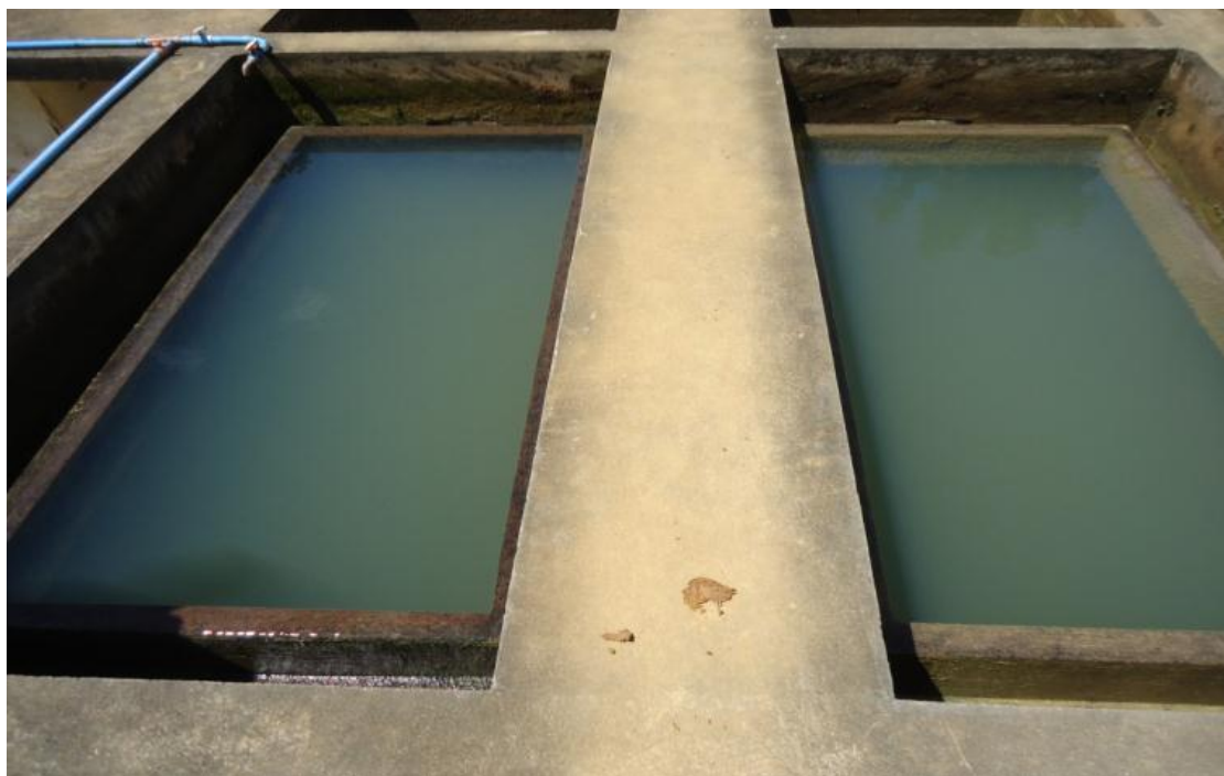
Figura 51 – Decantadores da ETA Moacyr Ávidos.
