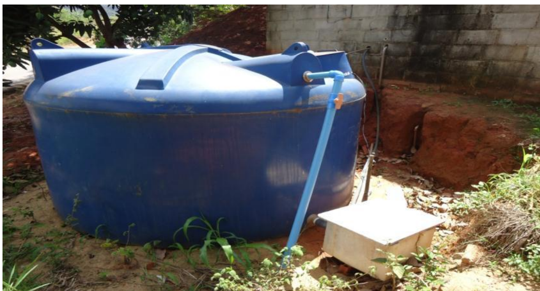
Figura 61 – EEAT do Bairro São Francisco.
