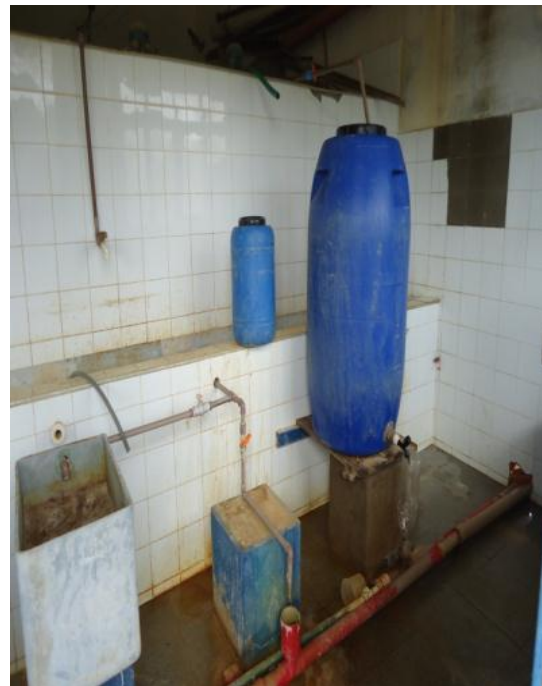
Figura 72 – Dosagem do Sulfato e Cloro.
