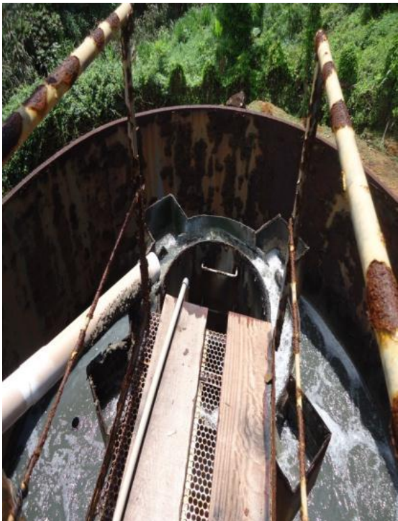
Figura 118 – Passarela de Acesso.
