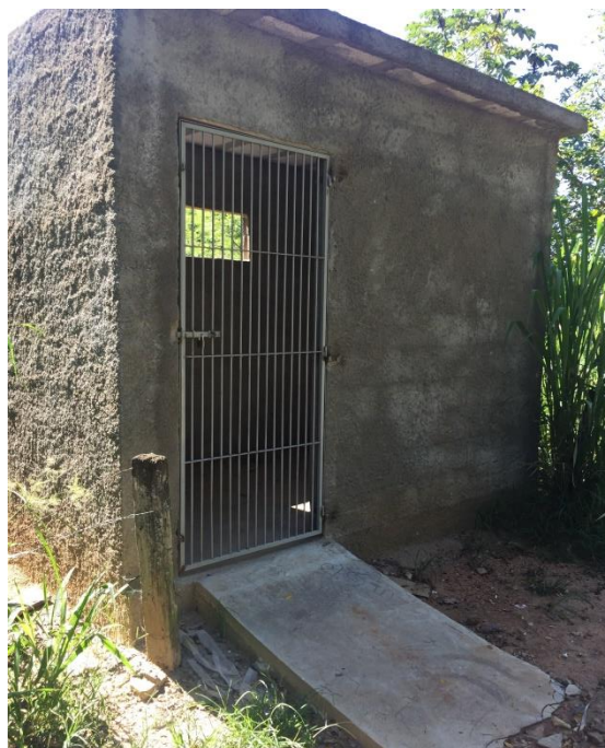
Figura 74- Nova casa de bomba da EEAB.
