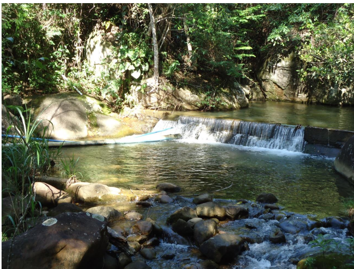
Figura 87 – Captação do Distrito de São José das Torres realizada por gravidade.
