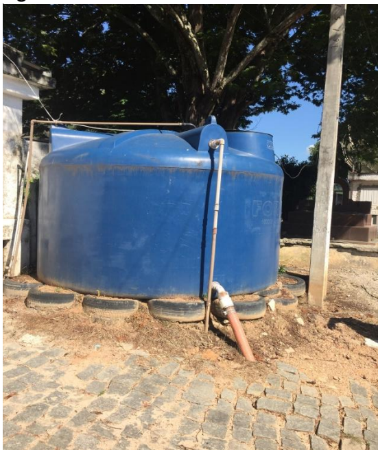
Figura 77– Reservatório da EEAT.
