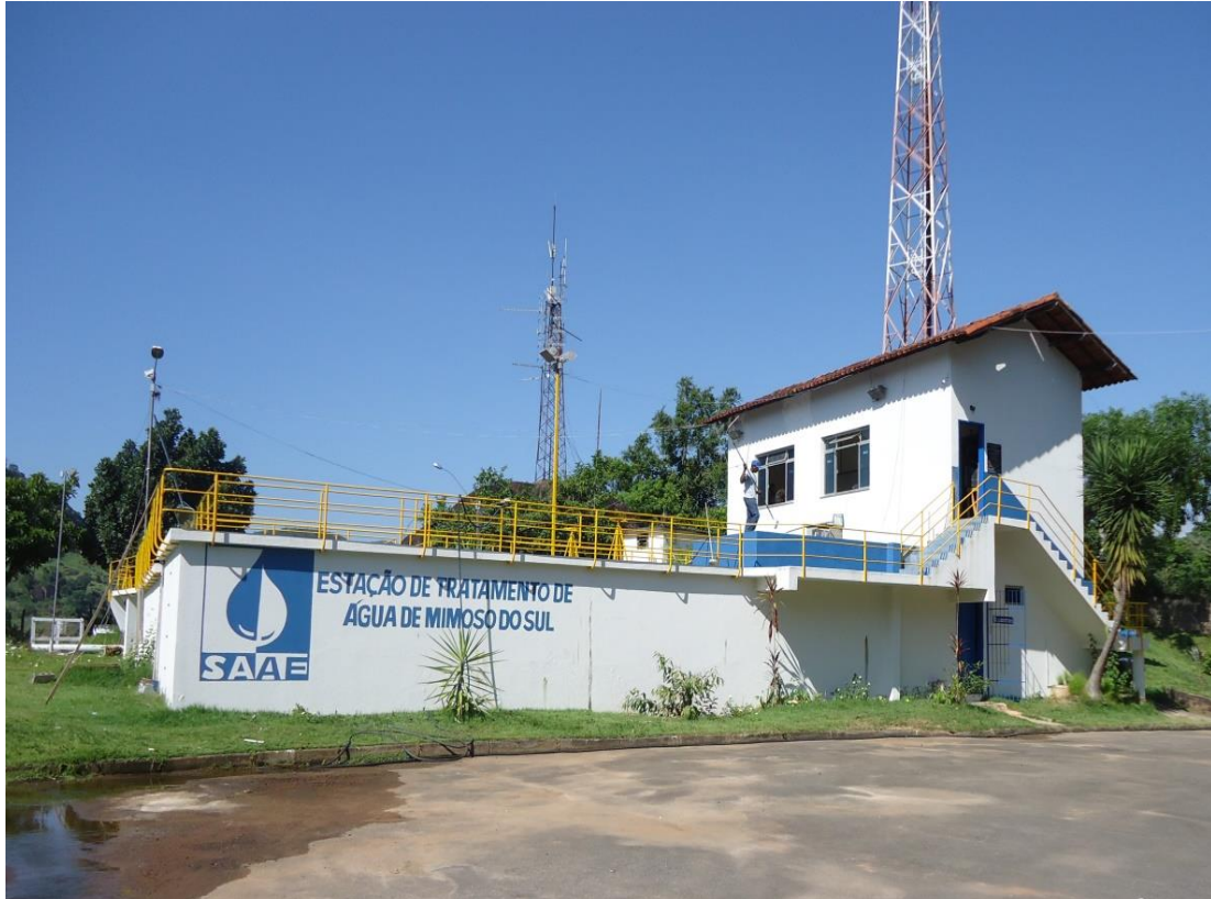
Figura 4 –ETA de Mimoso do Sul.
