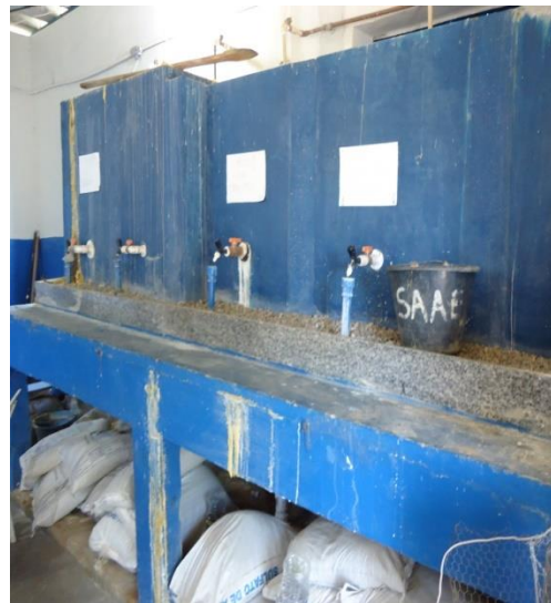
Figura 110- Dosadores de cloro e sulfato.
