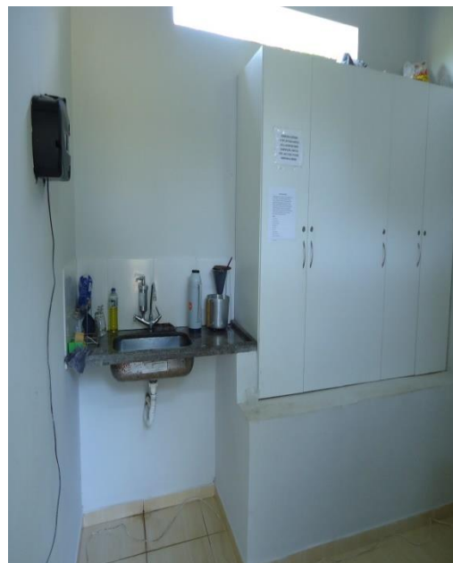
Figura 39 – Área de Apoio ETA.
