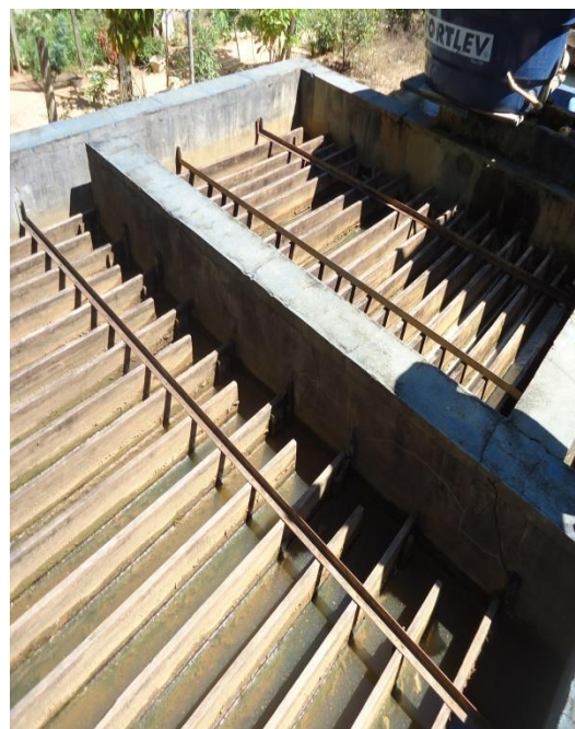
Figura 112 – Unidade de Floculação.
