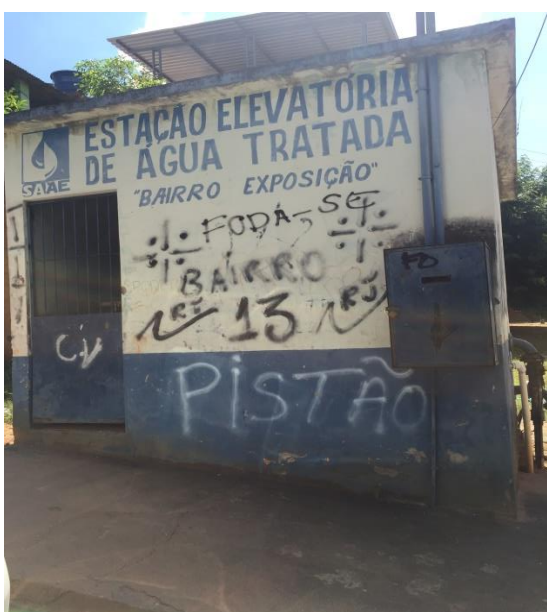
Figura 55 – Casa de bomba EEAT Exposição.
