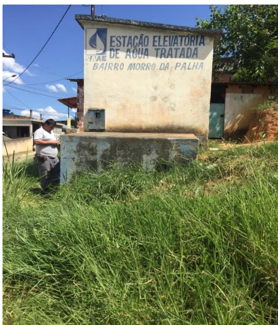
Figura 50 – Casa de bomba EEAT Morro da Palha.
