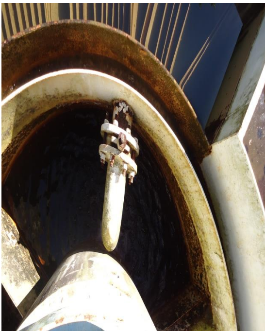
Figura 95 – Filtro da ETA.
