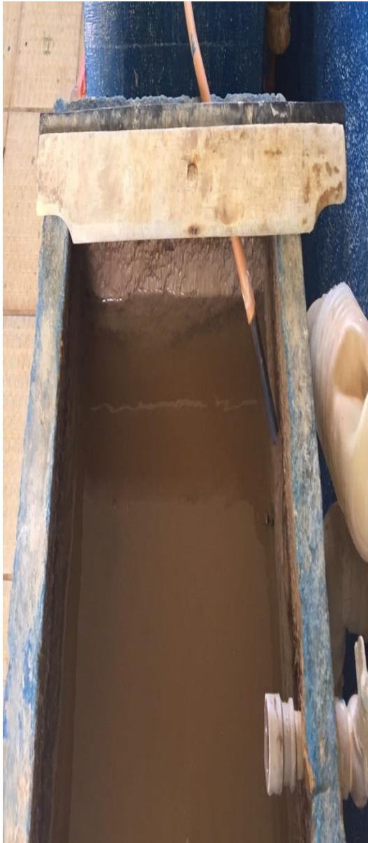
Figura 146- Dosadores de Sulfato.
