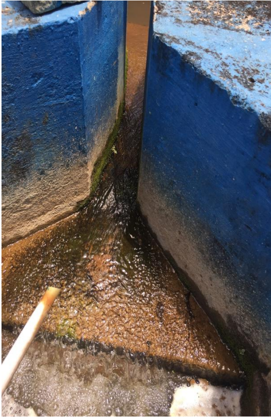
Figura 148 – Calha Parshall
