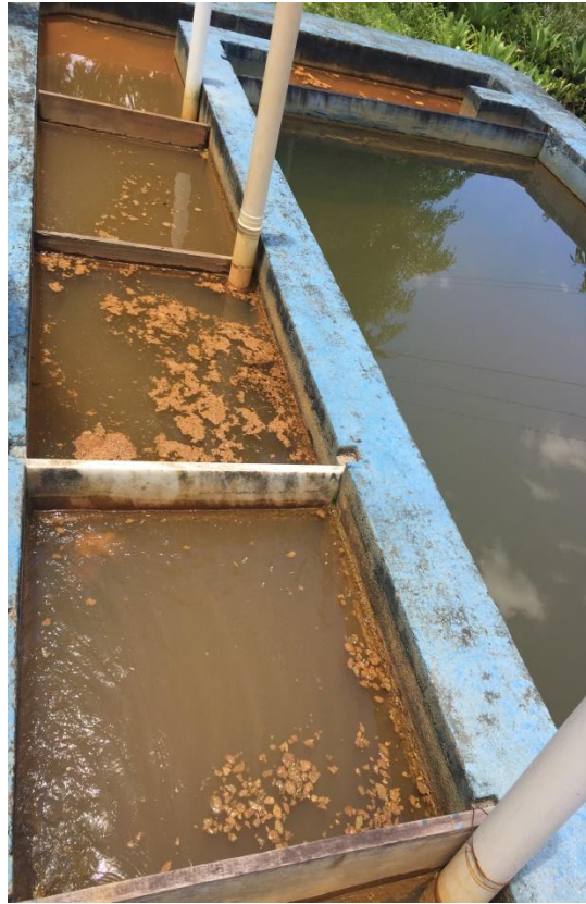
Figura 149 – Unidade de Flocação.
