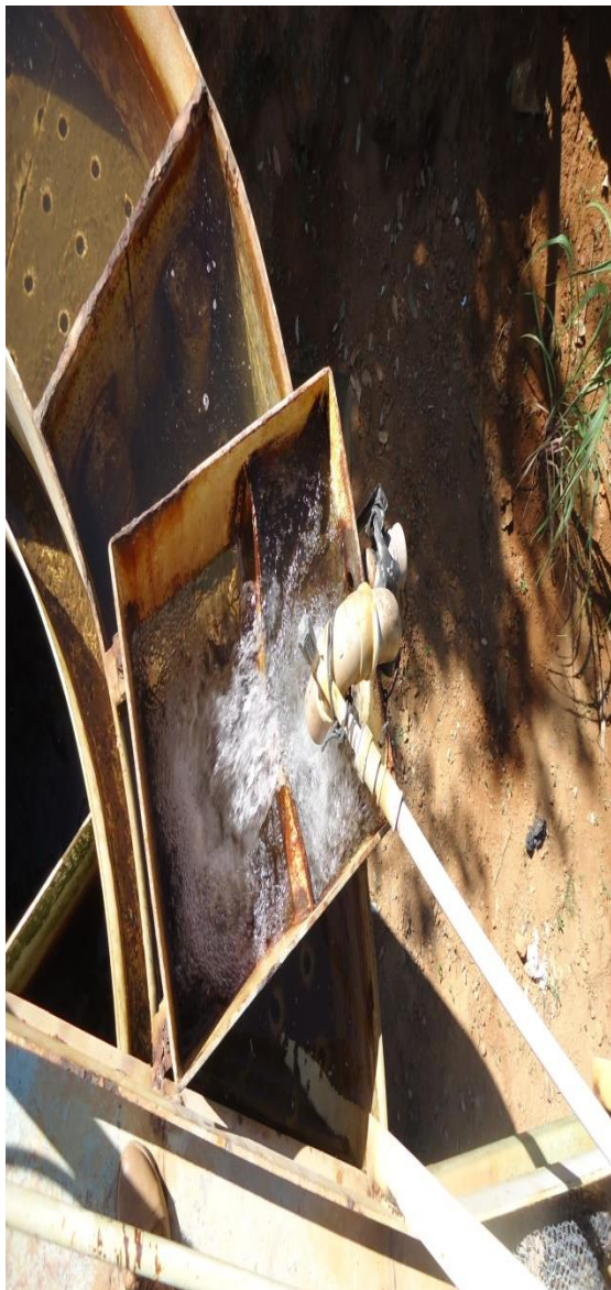
Figura 92 – Entrada da Água Bruta na ETA.
