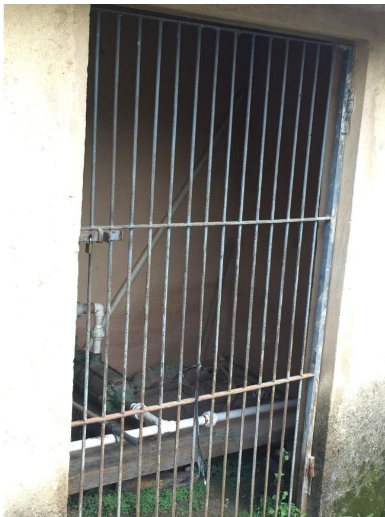
Figura 142.2 – Conjunto moto-bomba EEAB.
