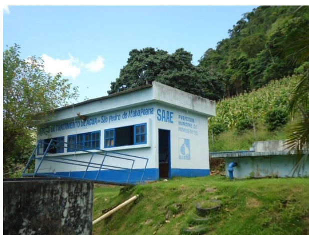
Figura 128 – Entrada da ETA do Distrito de Ponte do Itabapoana.
