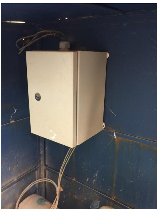
Figura 66 – Painel de Controle da EEAT.
