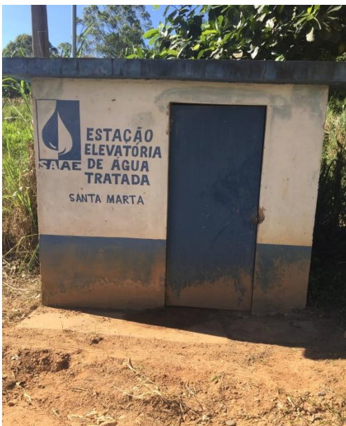
Figura 79– Casa de Bomba da EEAT.
