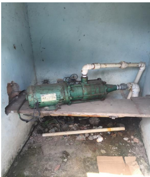
Figura 48 – Conjunto Moto-Bomba da EEAT.
