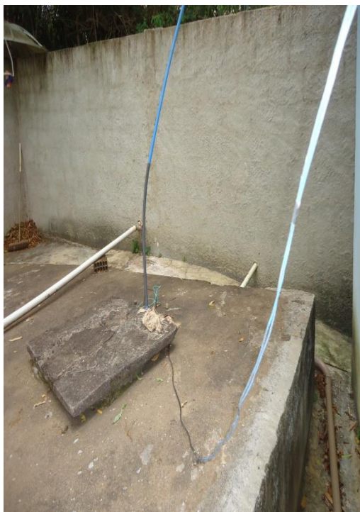
Figura 131.1 – Fiação exposta na ETA.
