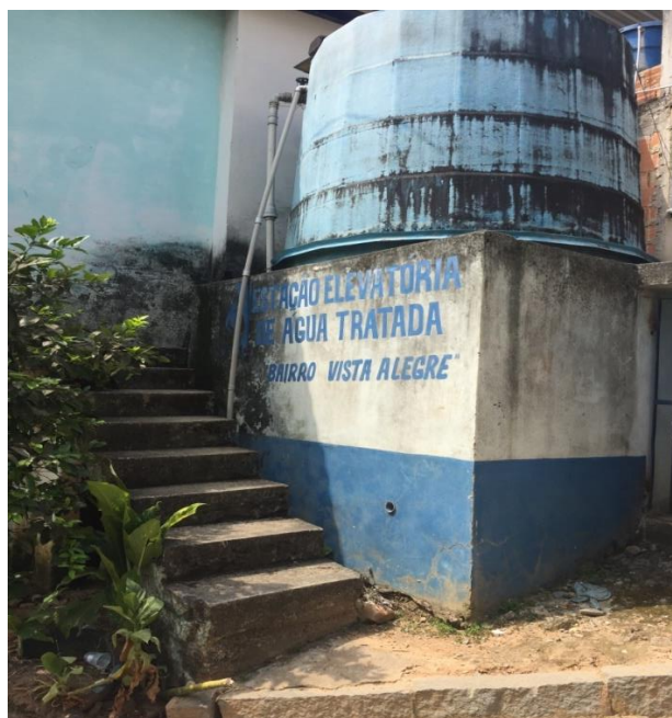
Figura 47 – Casa de bomba EEAT Vista Alegre.
