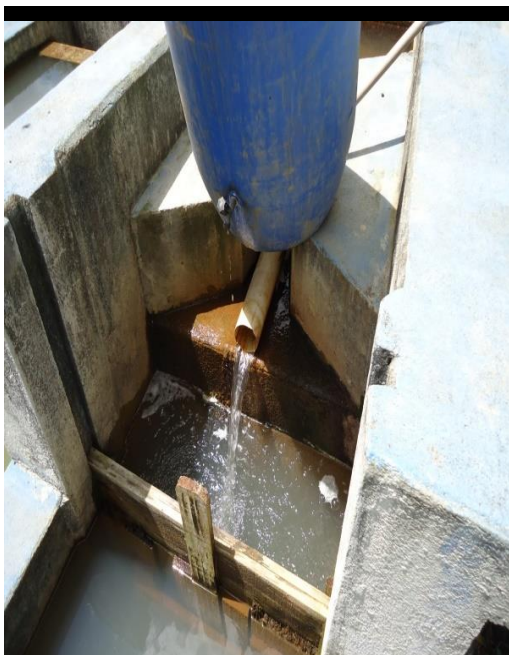
Figura 131 –Calha parshall
