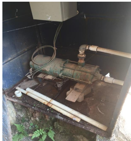
Figura 65 – Conjunto Moto-Bomba EEAT.
