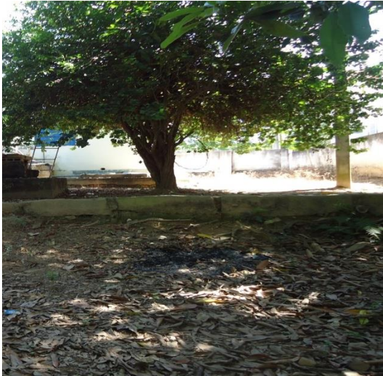
Figura 109–Funda da ETA sem fechamento.
