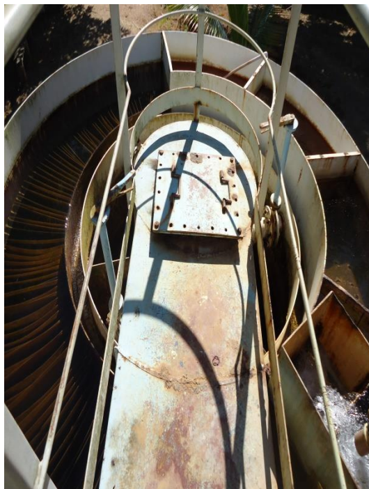
Figura 89 – ETA São José das Torres.
