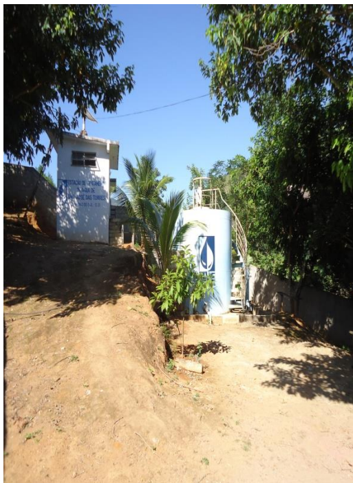
Figura 88 – Entrada da ETA.
