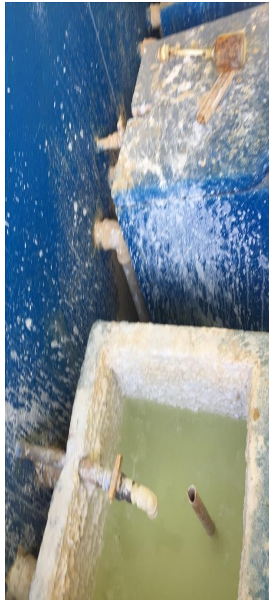
Figura 147- Dosadores de Cloro.
