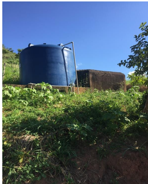
Figura 82- Reservatório de Santa Marta.
