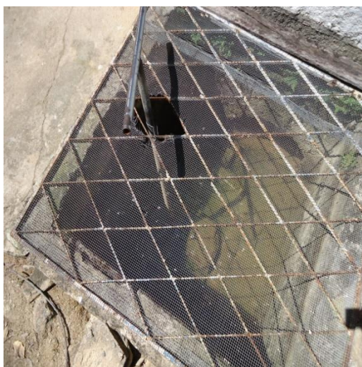
Figura 123 – Caixa de Registro.
