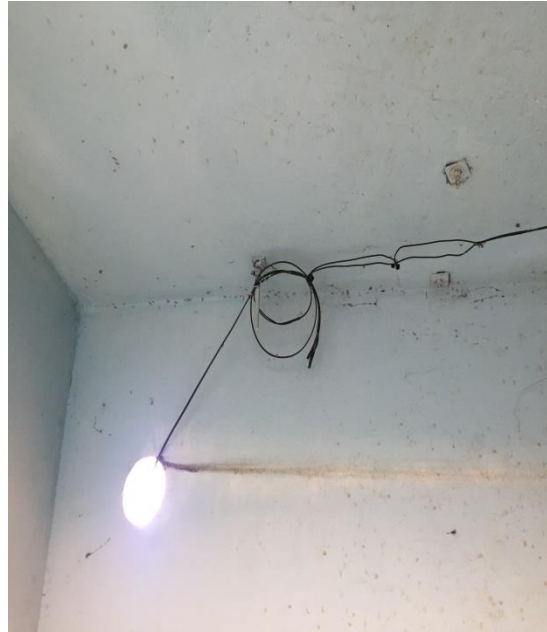
Figura 58 – Parede da EEAT necessitando de Limpeza.
