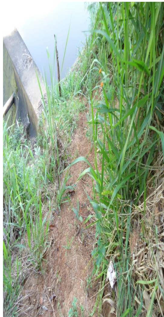
Figura 2 – Acesso a captação.
