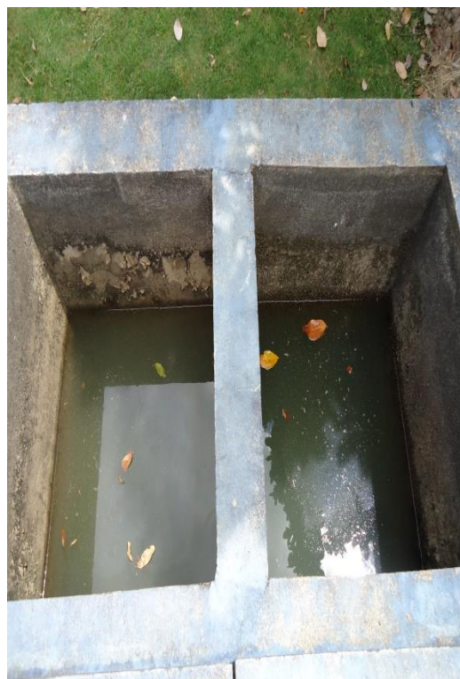
Figura 138 – Filtros do Lado esquerdo.
