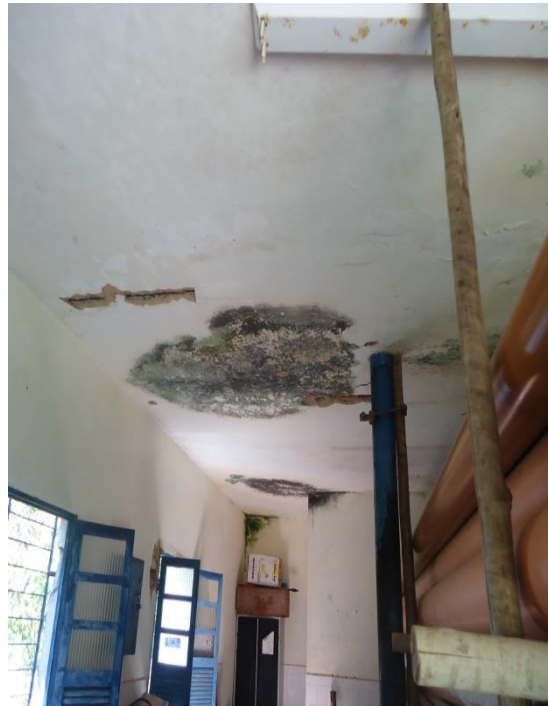
Figura 45 – Laje com ferragem exposta no Deposito de Tubos e conexões.
