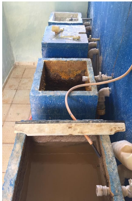
Figura 145- Dosadores de Sulfato e cloro.
