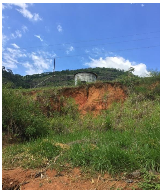
Figura 49 – Acesso ao Reservatório da EEAT.
