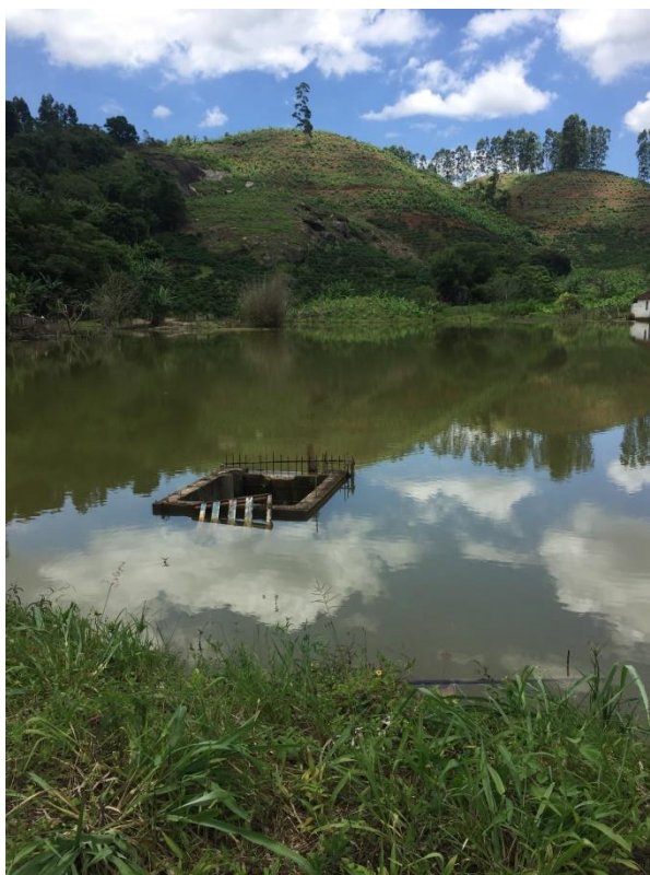
Figura 126 – Captação em Represa por gravidade do distrito de Conceição de Muqui.
