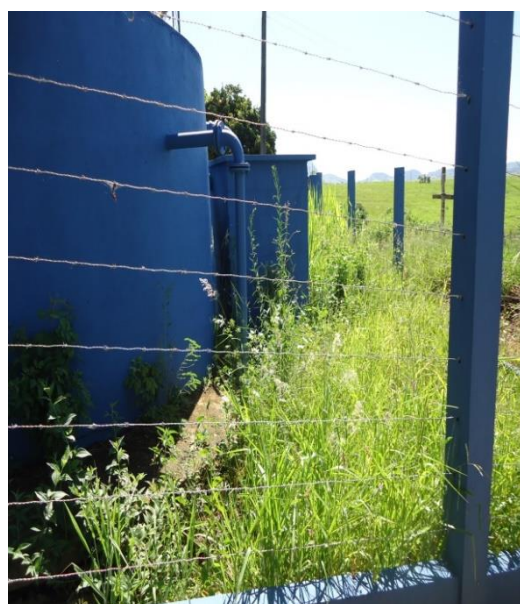
Figura 127 – Excesso de Vegetação.
