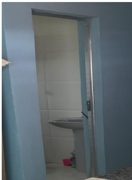
Figura 136- Banheiro da ETA.
