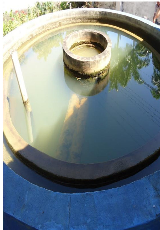
Figura 113 - Vegetação presente na unidade de flocação. Figura 114 – Decantador 1.
