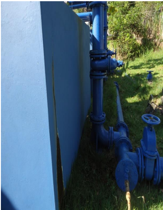
Figura 11 – Infiltração na estrutura de chegada de água bruta no SAAE.
