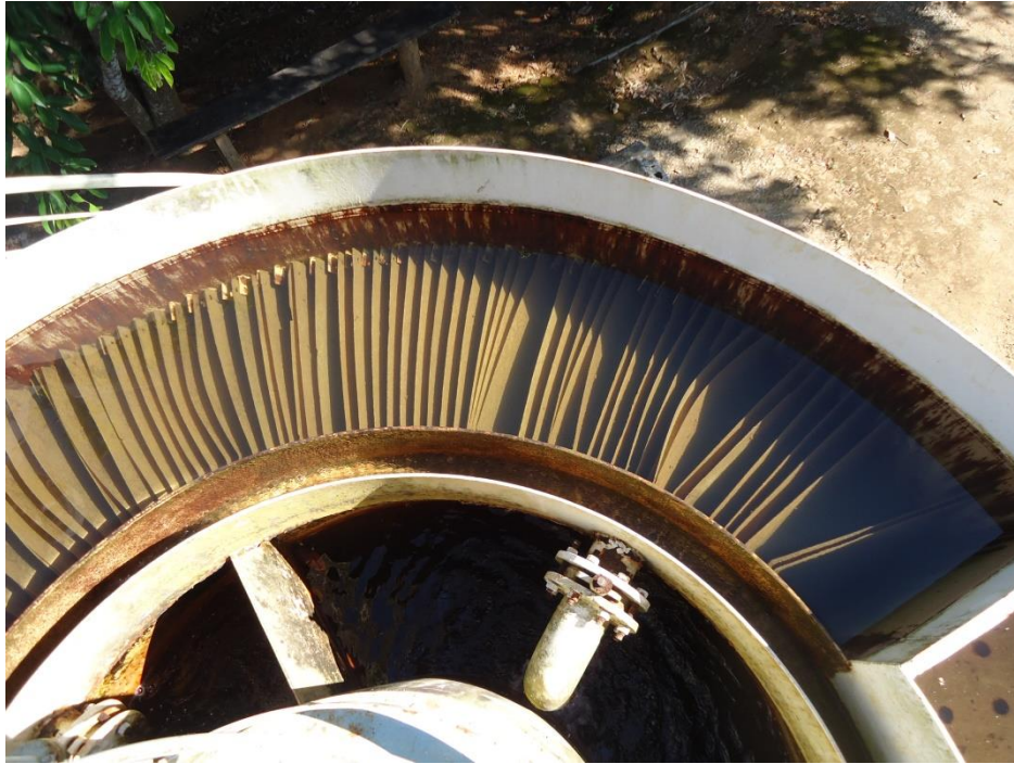
Figura 94 – Decantadores da ETA São José das Torres.
