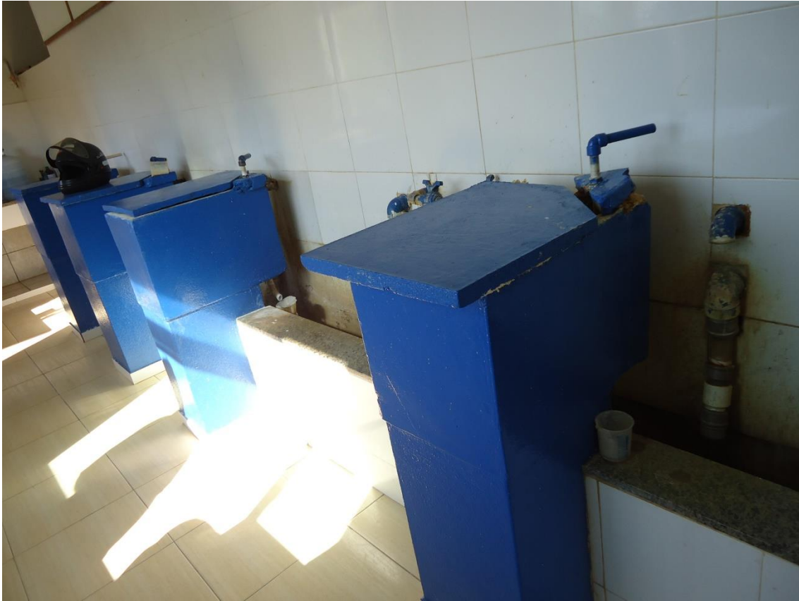
Figura 10 – Dosador do Sulfato, Cloro, Cloro e Flúor.
