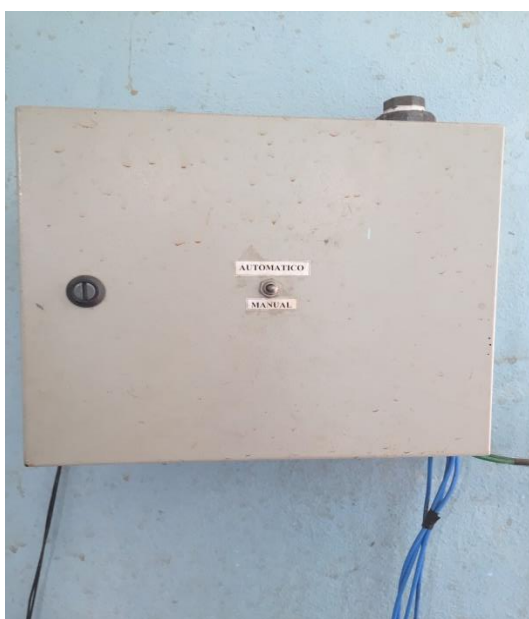
Figura 56- Painel de Controle da EEAT.
