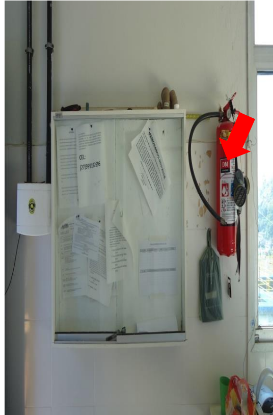
Figura 41 – Extintor de incêndio e quadro de aviso.
