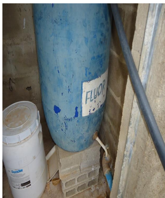
Figura 128– Pátio ETA de Conceição de Muqui. Figura 129 Dosadores de fluor.
