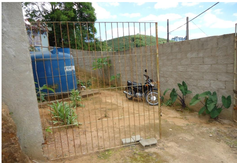
Figura 127 – Entrada da ETA do Distrito de Conceição de Muqui.
