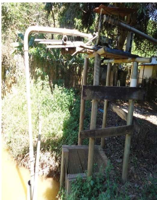
Figura 104 – Entrada EEAB de Ponte do Itabapoana.
