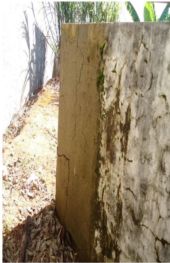
Figura 99 - Fissura no reservatório da ETA.
