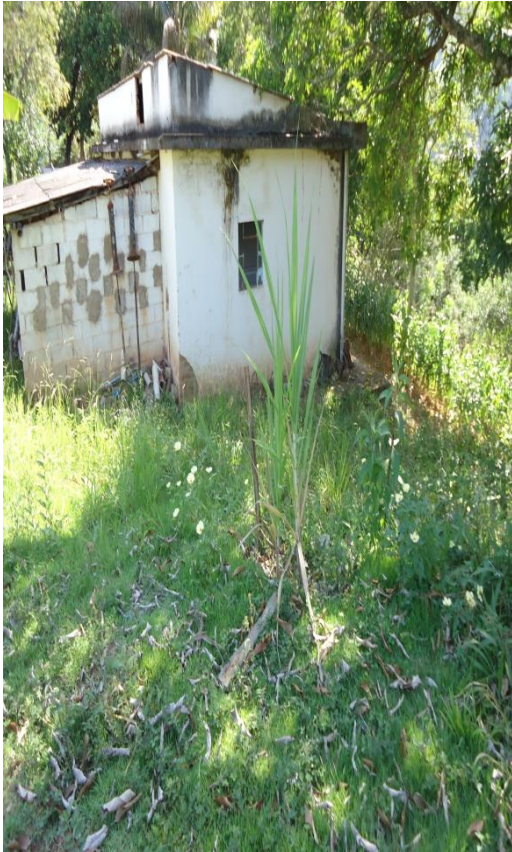
Figura 6 – Excesso de Vegetação no pátio da ETA.
