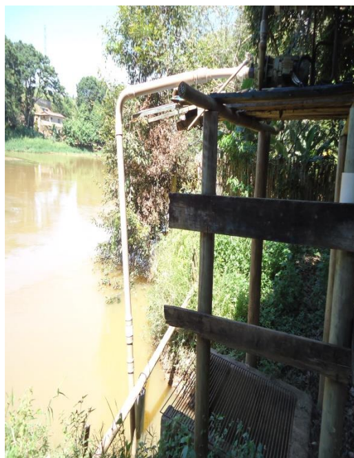
Figura 105 – Conjunto Moto-bomba EEAB.
