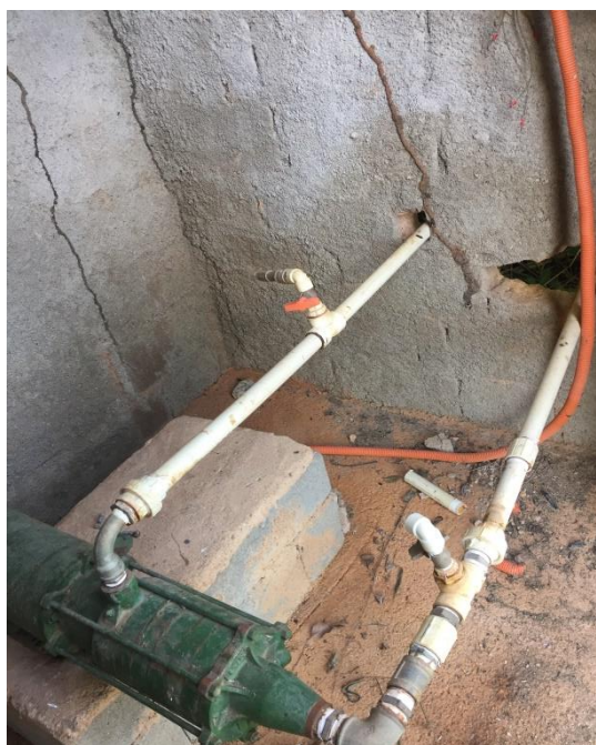
Figura 69 – Conjunto Moto-Bomba EEAT.
