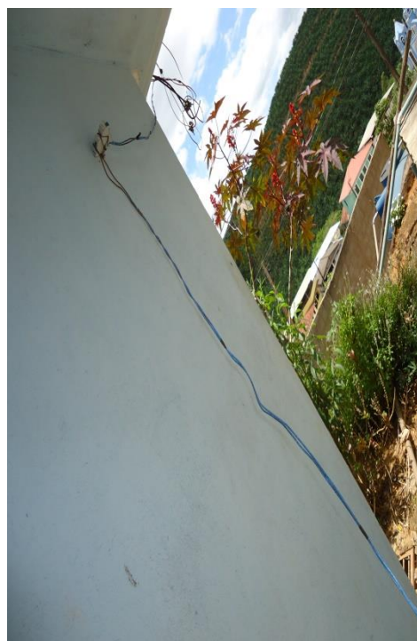
Figura 131.2- fiação exposta.
