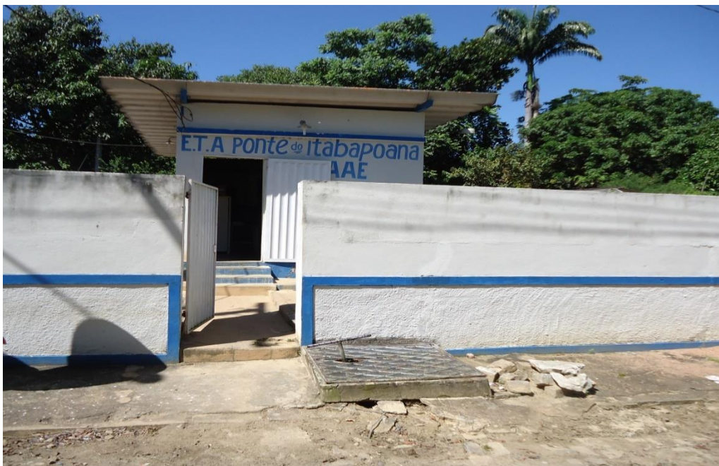
Figura 108 – Entrada da ETA do Distrito de Ponte do Itabapoana.
