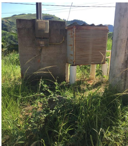
Figura 86- Excesso de Vegetação na EEAT.
