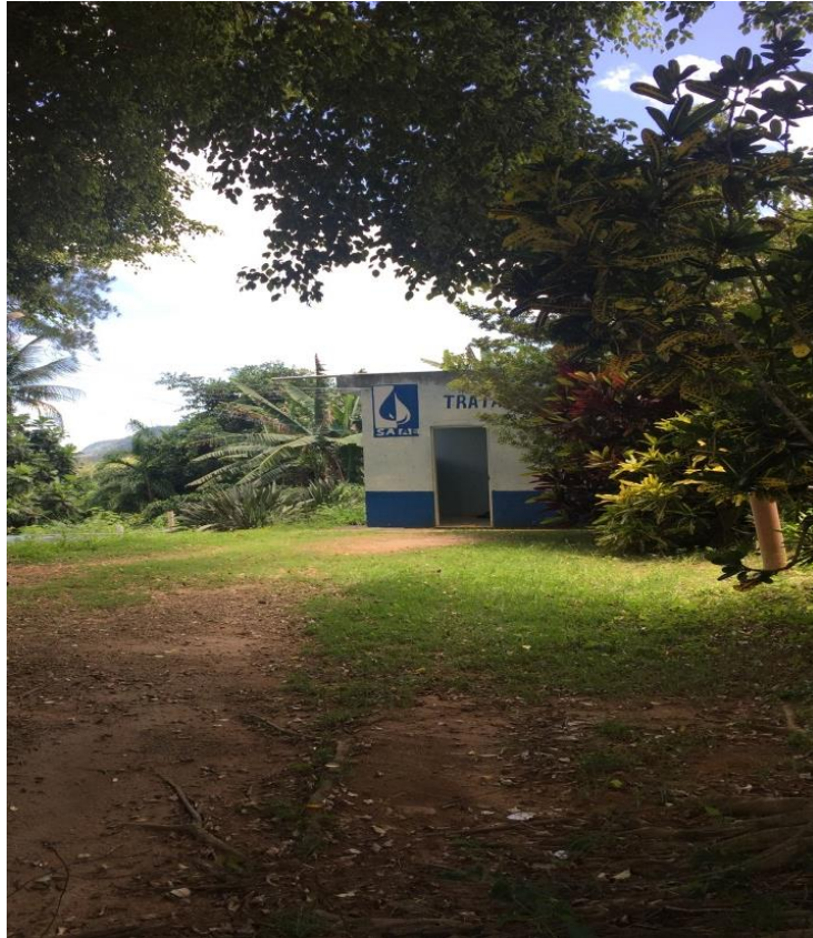
Figura 143 – Entrada da ETA do Distrito de Ponte do Itabapoana.
