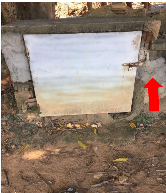
Figura 75– Casa de Bomba da EEAT.
