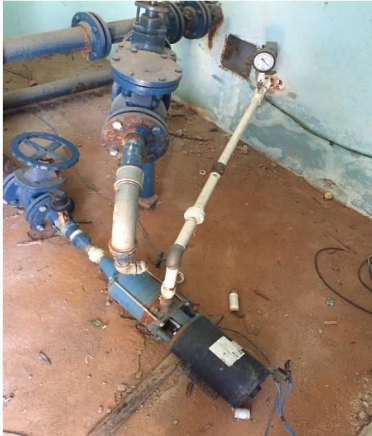
Figura 57 – Conjunto Moto-Bomba da EEAT.
