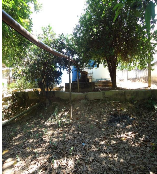
Figura 107 – Necessitando de Manutenção.
