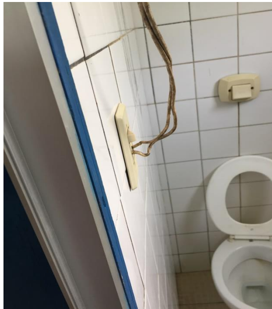
Figura 160- Banheiro da ETA.
