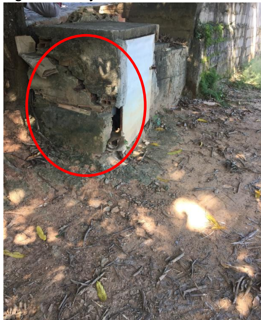
Figura 78- Casa de Bomba com estrutura danificada.
