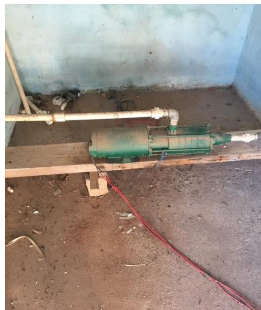
Figura 60 – Conjunto Moto-Bomba EEAT.
