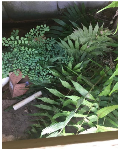
Figura 141 – Excesso de Vegetação.
