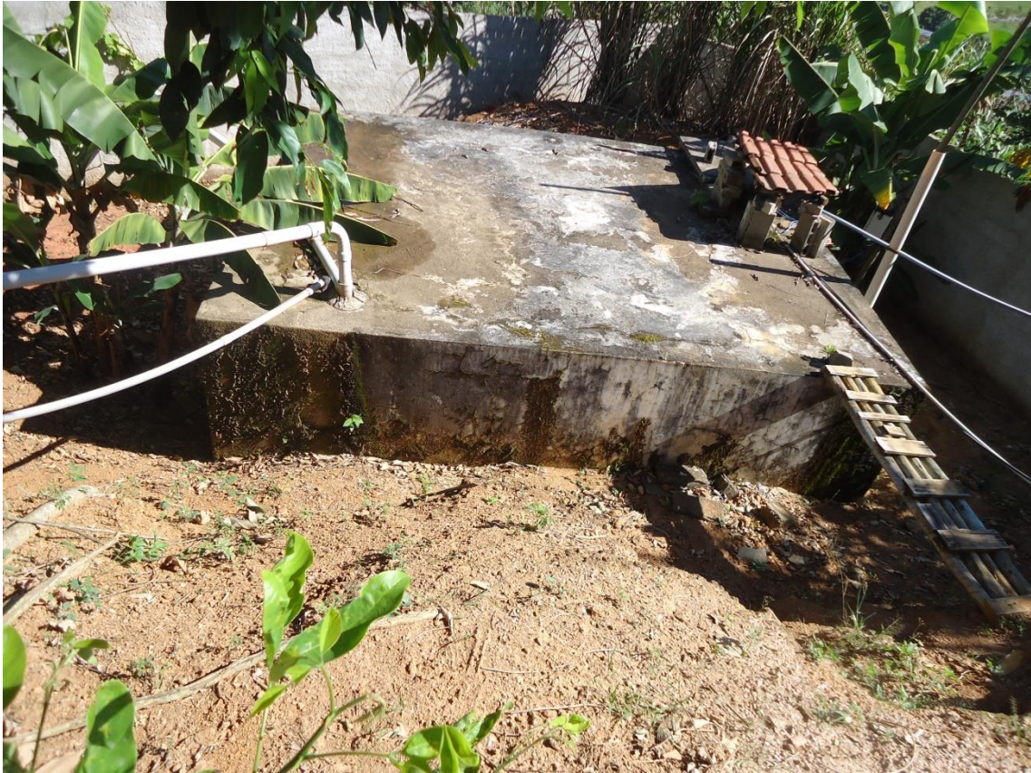
Figura 97 – Reservatório da ETA Distrito São José das Torres.
