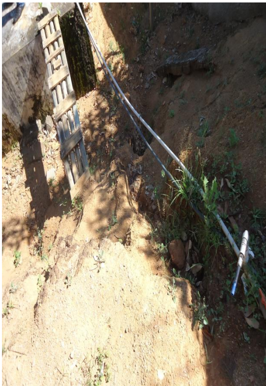
Figura 98 – Acesso ao Reservatório da ETA.
