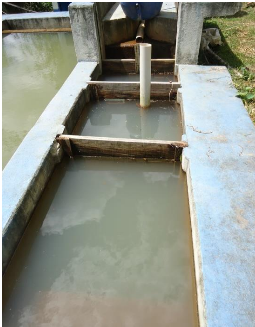
Figura 132 – Unidade de Floculação.
