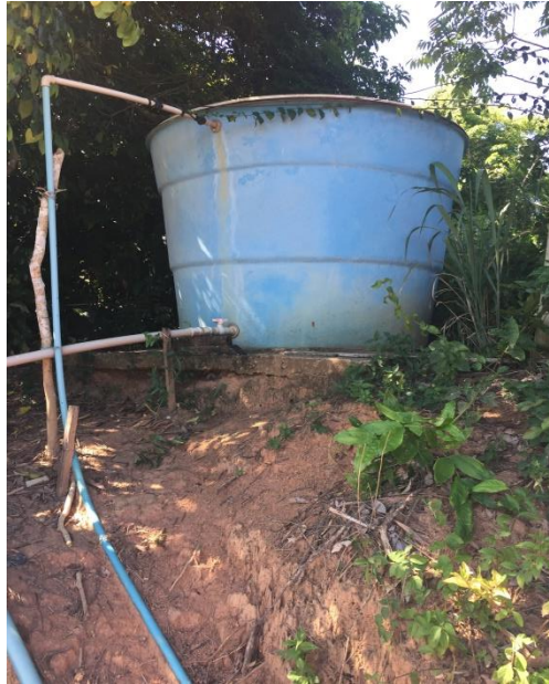
Figura 72– Reservatório EEAT Bairro Lia Leite.
