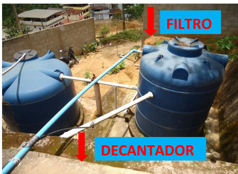
Figura 131 –Unidade de Tratamento de Água no distrito de Conceição de Muqui.
