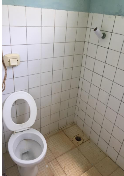
Figura 159- Banheiro da ETA.
