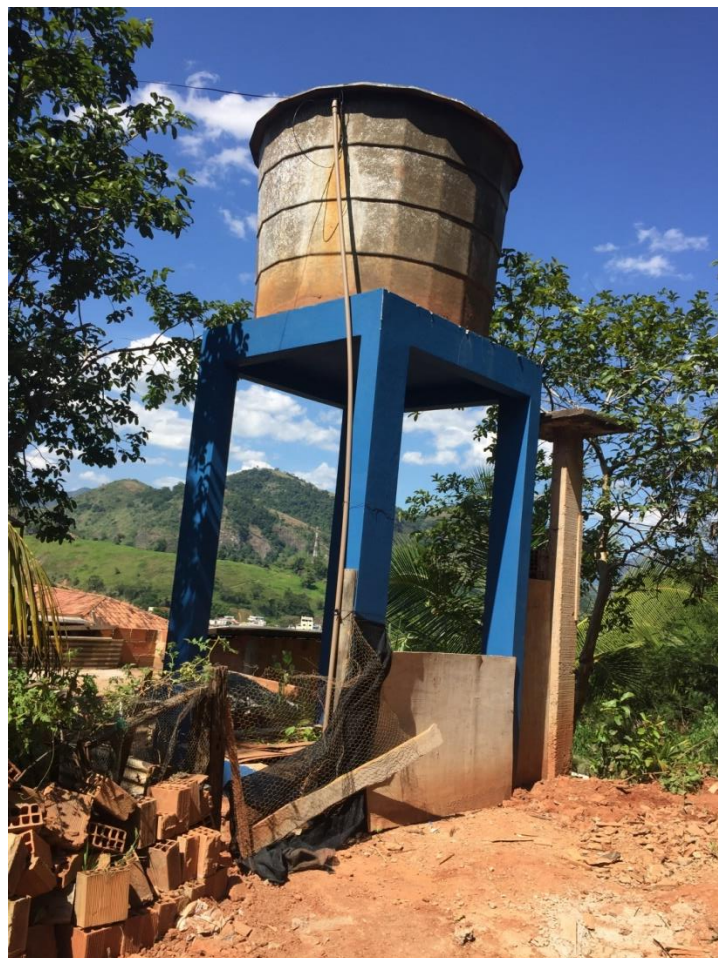
Figura 63– Reservatório da EEAT do Bairro Itapuã II.
