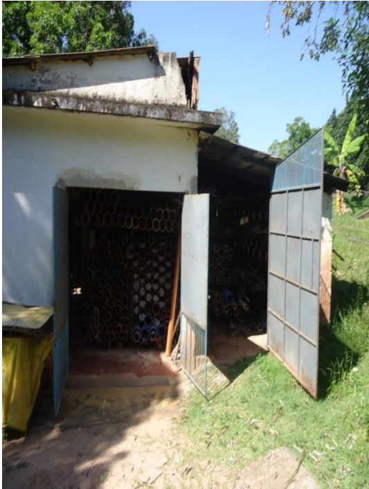
Figura 44 – Deposito de Tubos e conexões.
