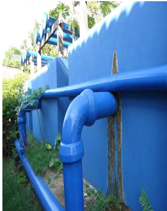
Figura 12 – Infiltração na estrutura de chegada de água bruta no SAAE.
