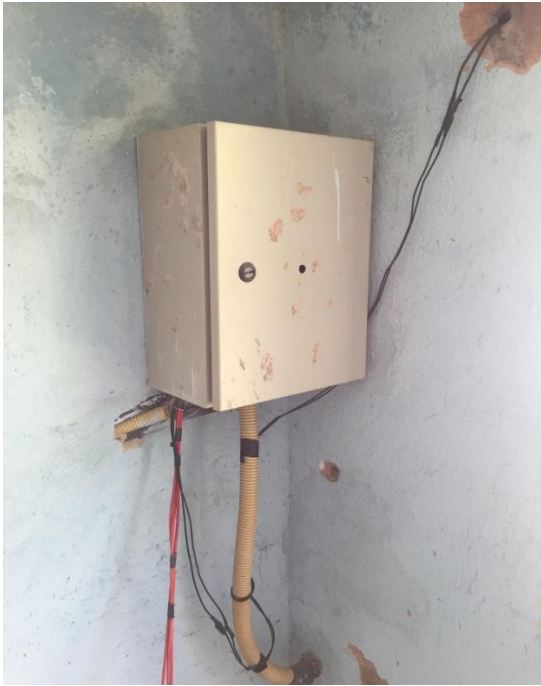
Figura 61 – Painel de Controle da EEAT.
