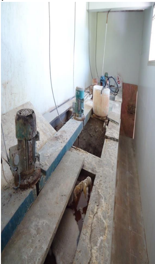
Figura 8 – Tanques de dosagem de Sulfato, Cloro, Cloro e Flúor.
