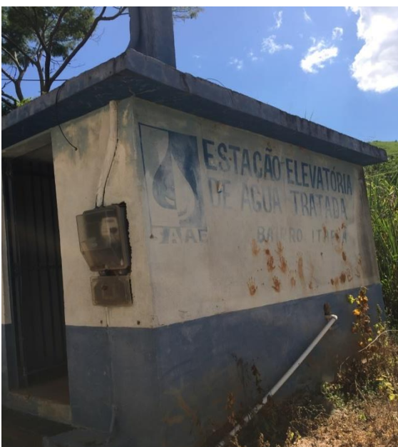
Figura 59 – Casa de bomba EEAT Itapuã II.
