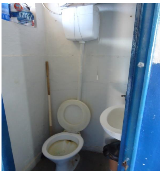
Figura 122- Banheiro da ETA.
