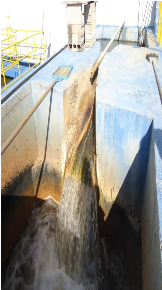
Figura 13 – Calha parshall
