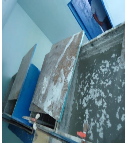
Figura 130 - Dosadores de cloro.
