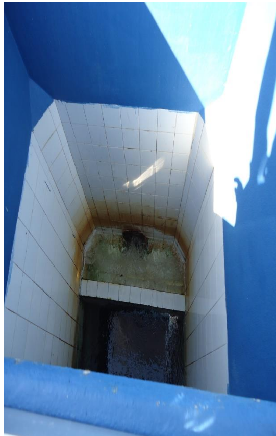
Figura 22 – Descarga dos filtros
