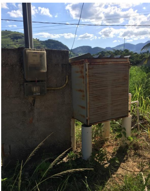
Figura 83– Casa de Bomba da EEAT.
