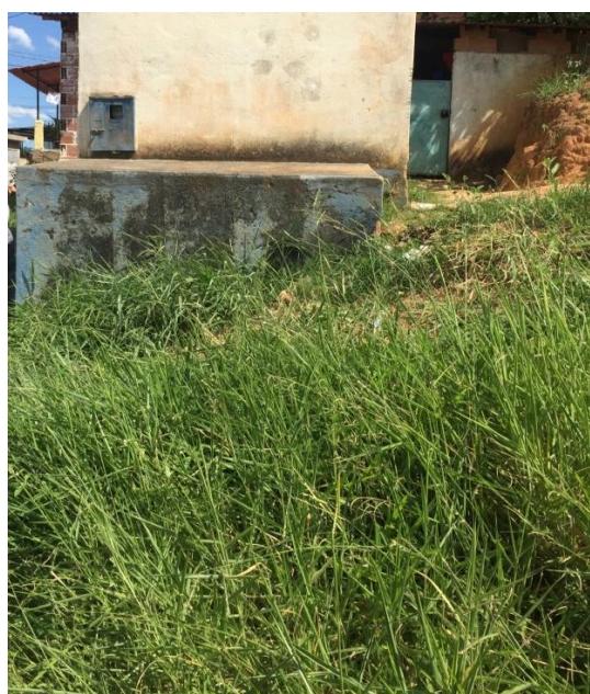
Figura 52 – Excesso de vegetação EEAT.
