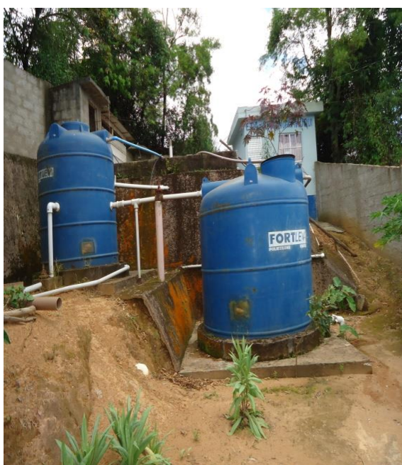
Figura 128– Pátio ETA de Conceição de Muqui. Figura 129 Dosadores de fluor.
