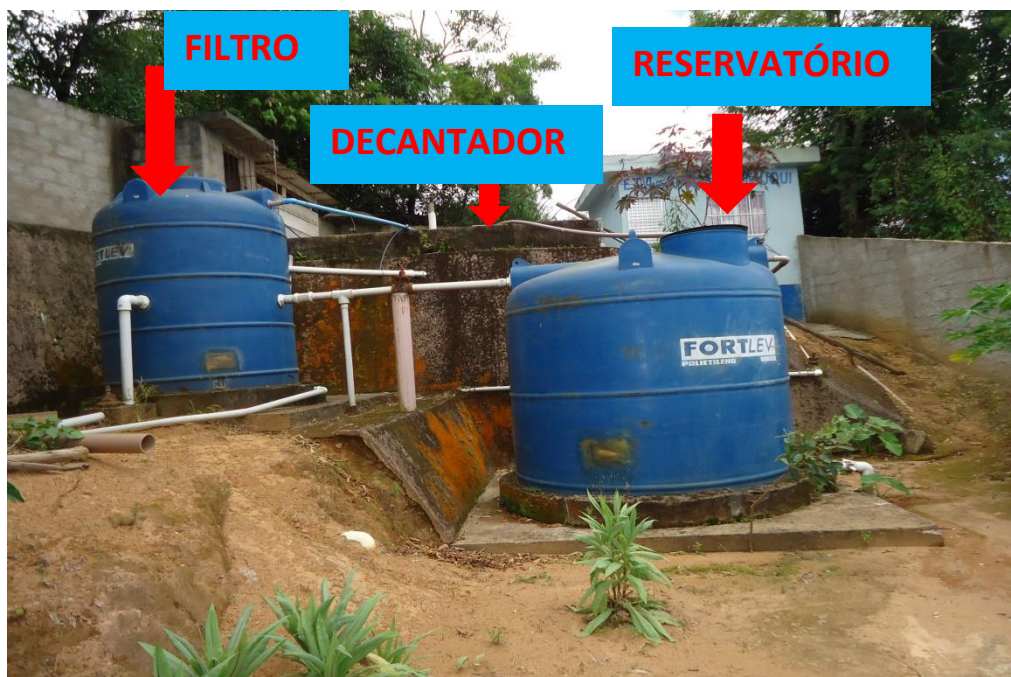
Figura 132 – Filtro, decantador e reservatório da ETA de Conceição de Muqui.
