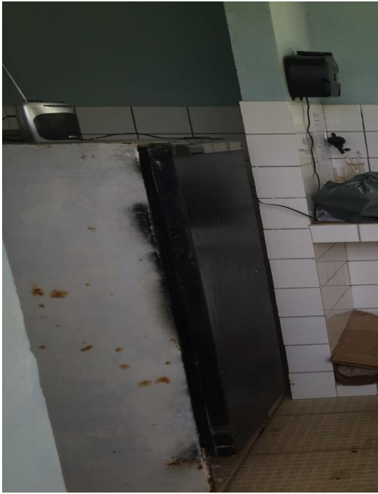
Figura 158- Área de Apoio ETA.
