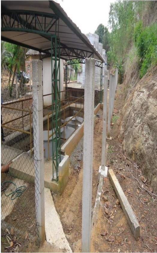
Figura 156 – Entrada 1 da ETE.
