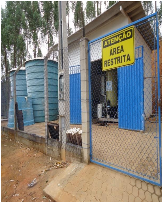
Figura 117 – Entrada da ETA.
