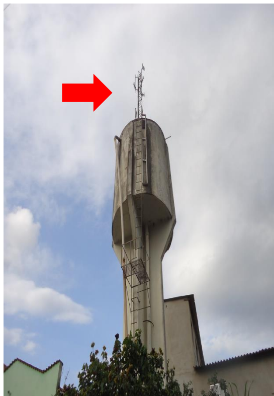
Figura 103 – Antena em local Indesejável.
