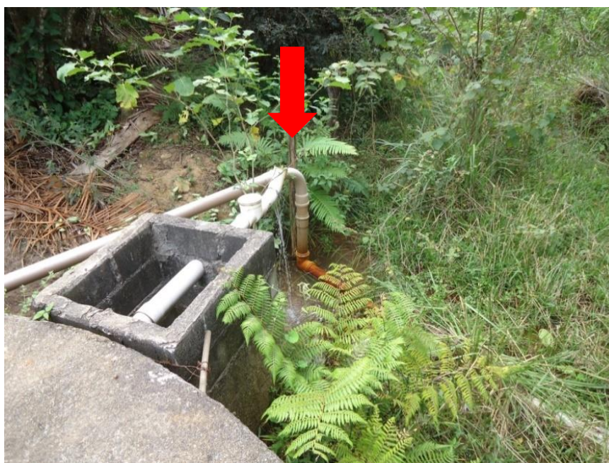
Figura 137 – Vazamento Visível.
