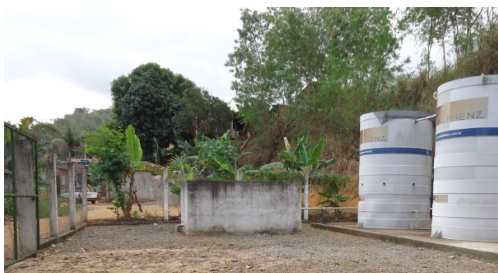
Figura 168 – Leito de Secagem.
