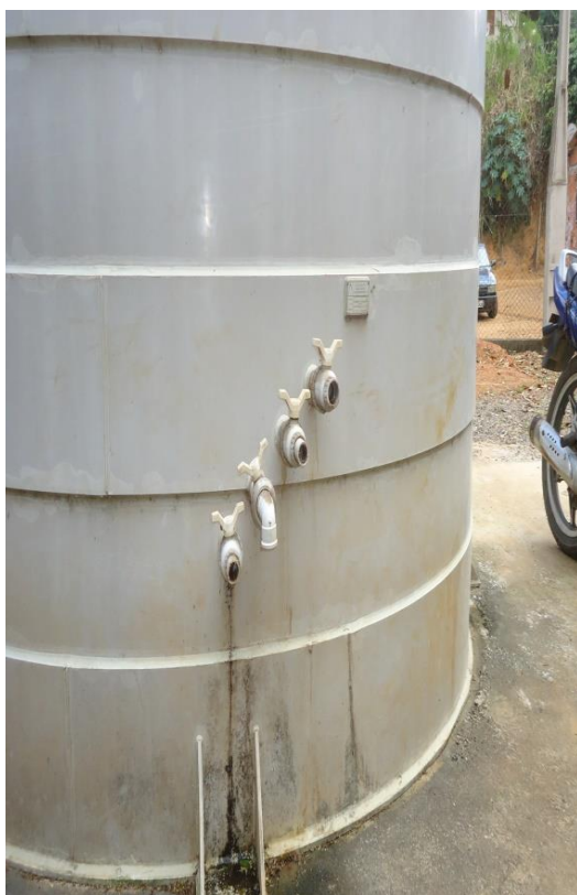
Figura 172 – Retirada de Amostra ETE.
