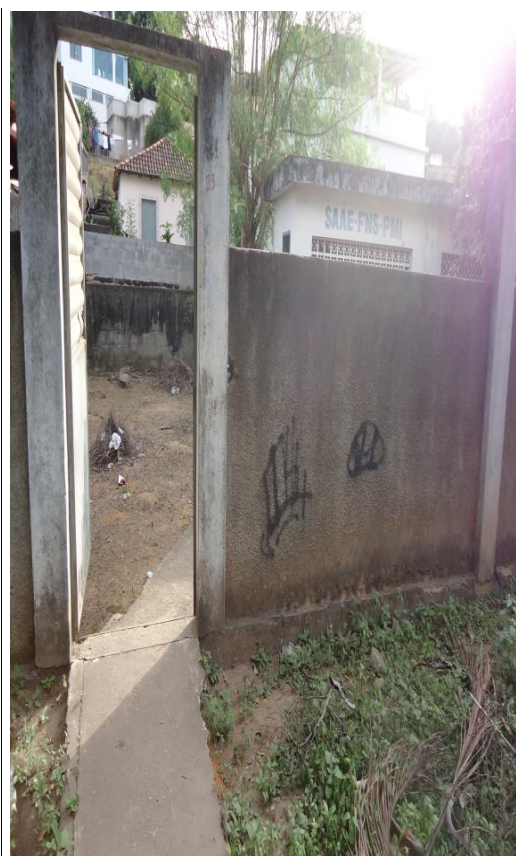
Figura 88 – Entrada da EEAT Mutirão
