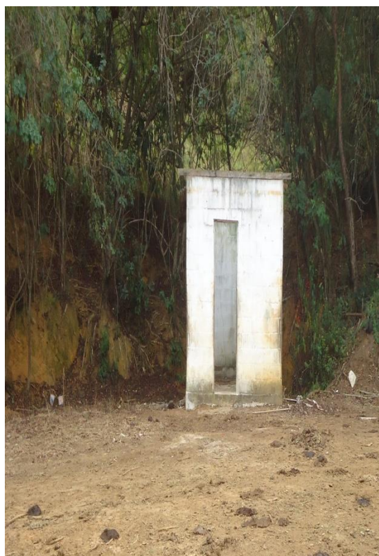
Figura 148 - Edificação de Apoio.
