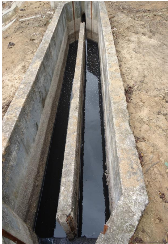
Figura 152 - Caixa desarenadora.
