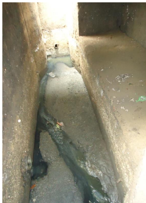
Figura 142 – Caixa desarenadora.
