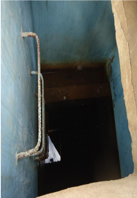
Figura 40– Estrutura de passagem
