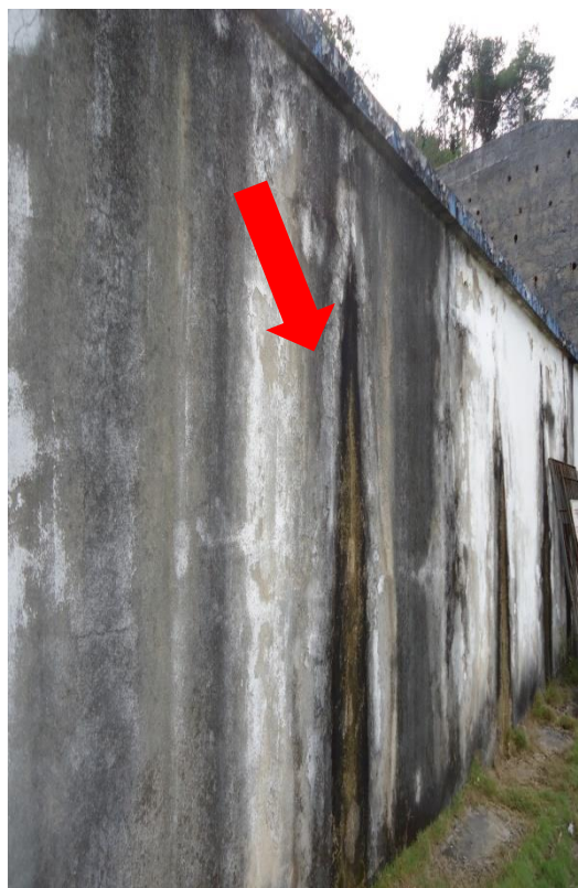
Figura 79 – Cobertura do Reservatório 2
