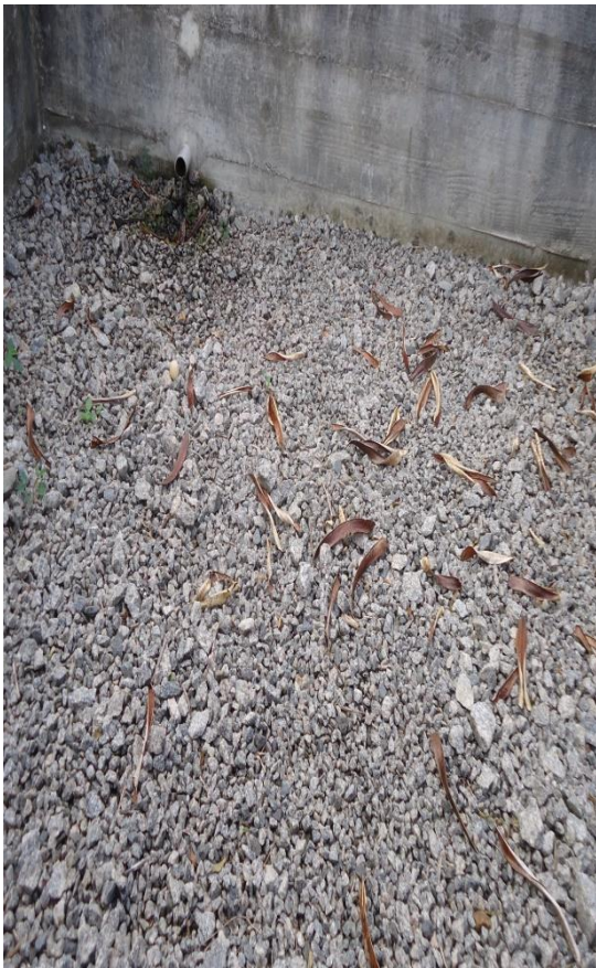
Figura 169 – Leito de Secagem.
