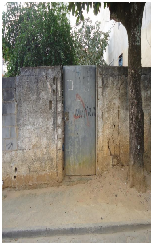
Figura 99 – Entrada do Reservatório.
