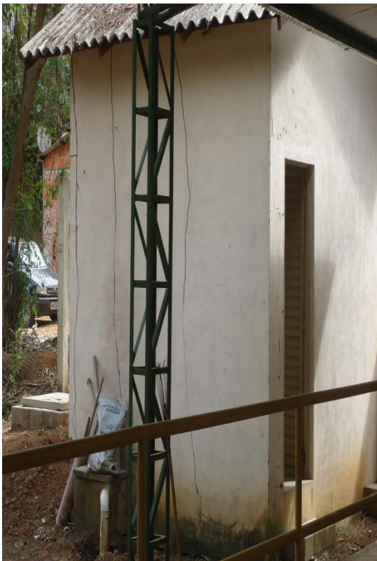
Figura 160 – Edificação de Apoio.
