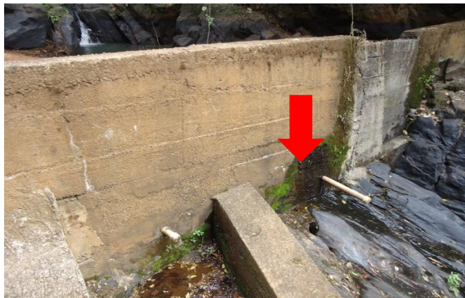
Figura 1 – Captação da Sede de Ibiraçu.
