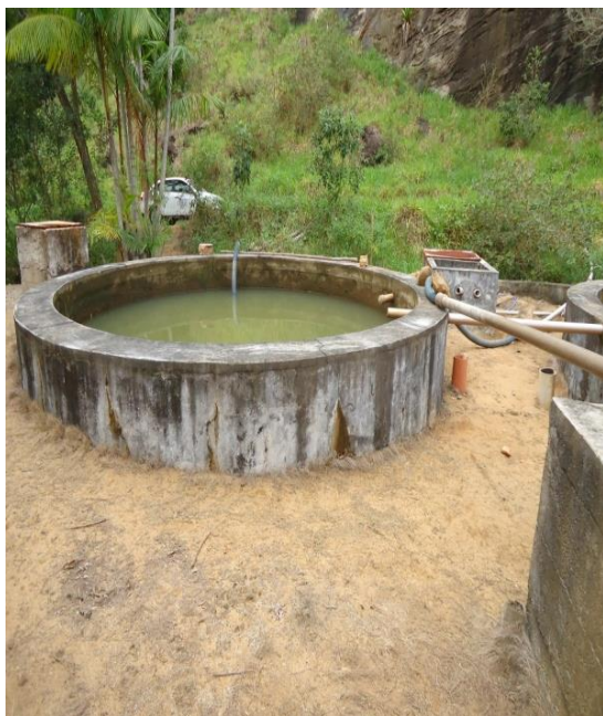
Figura 135 – ETA Guatemala Desativada.
