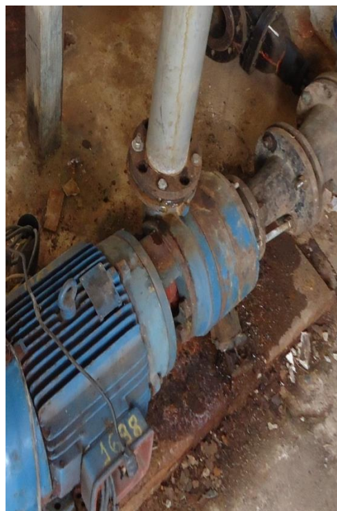
Figura 82- Conjunto moto-Bomba com vazamento
