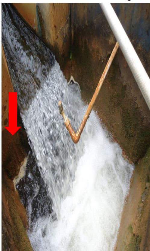
Figura 20 – Calha parshall.
