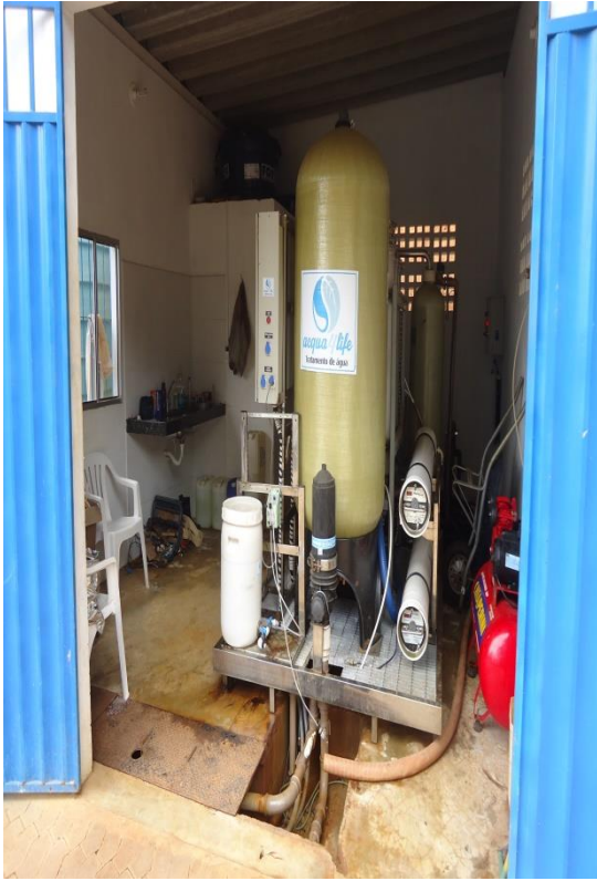
Figura 119 –Casa da ETA.
