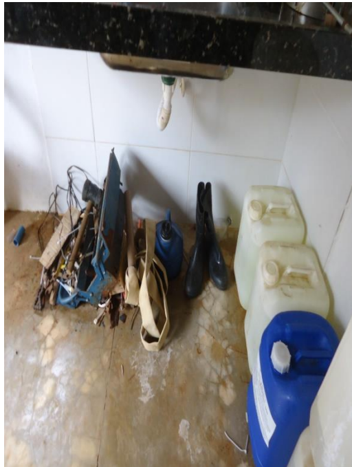
Figura 121 – Equipamento espalhado na ETA.
