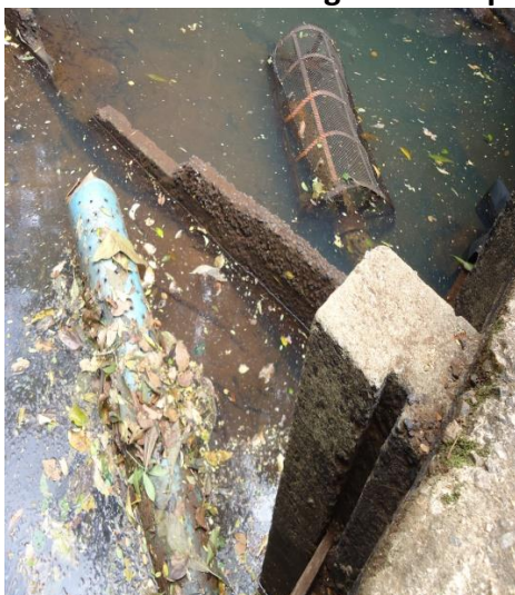
Figura 2 – Local de Captação.
