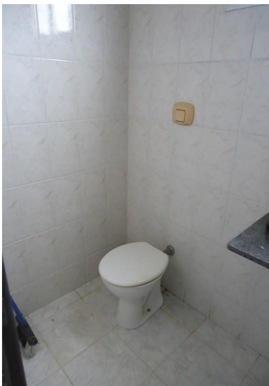
Figura 71 – Banheiro ETA da Sede 1.
