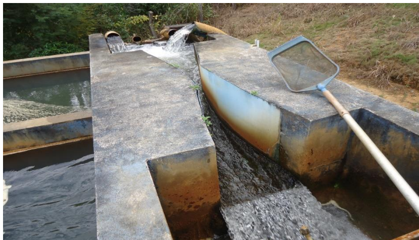
Figura 19 – Calha Parshall.
