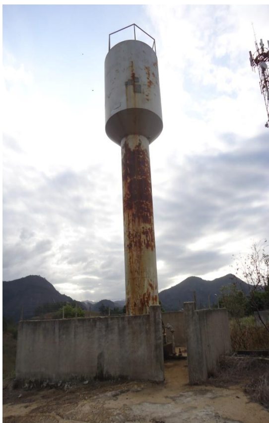
Figura 87.1- Entrada do Reservatório.
