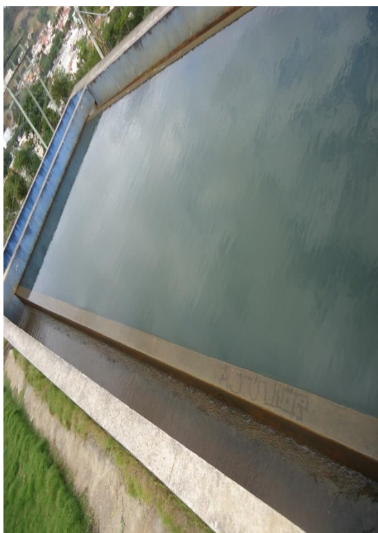
Figura 27 – Decantador.
