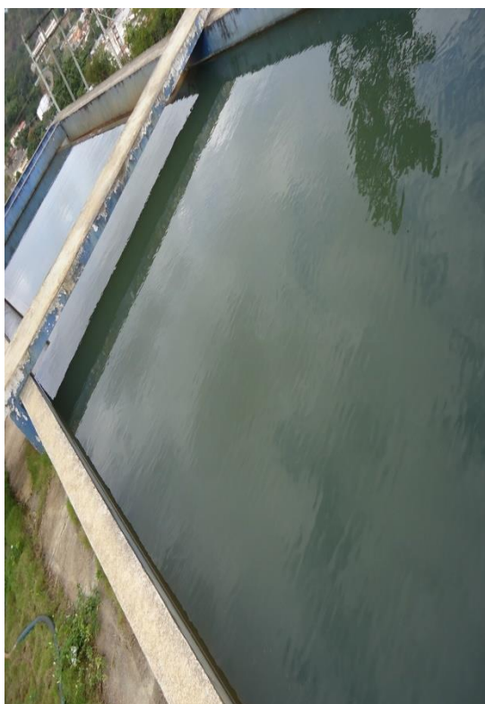
Figura 26 –Decantador
