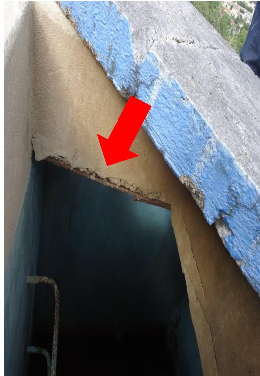
Figura 41 – Ferragem exposta.
