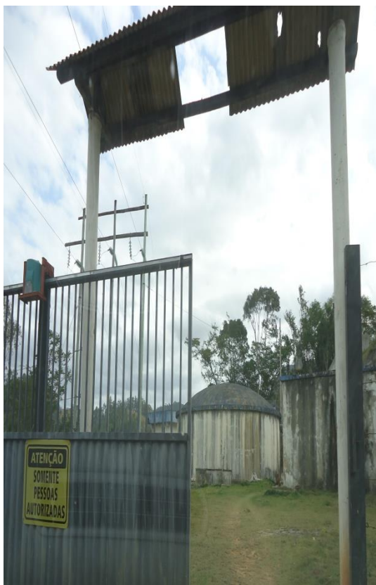
Figura 11 –Entrada da ETA.
