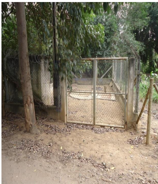
Figura 139 – EEEB do Centro.
