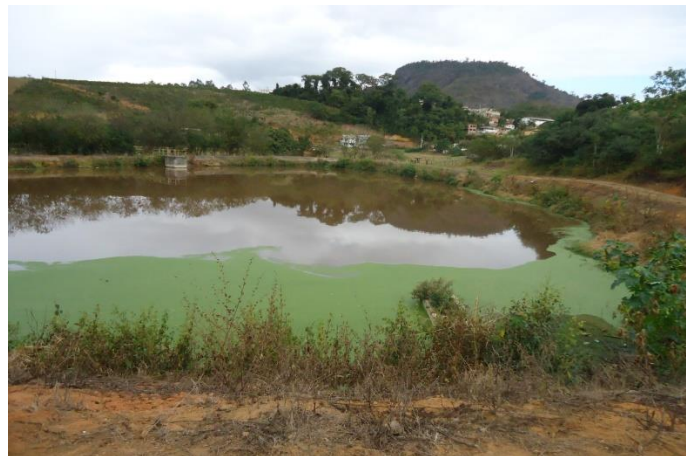
Figura 146 – Acesso ETE Ibiraçu.
