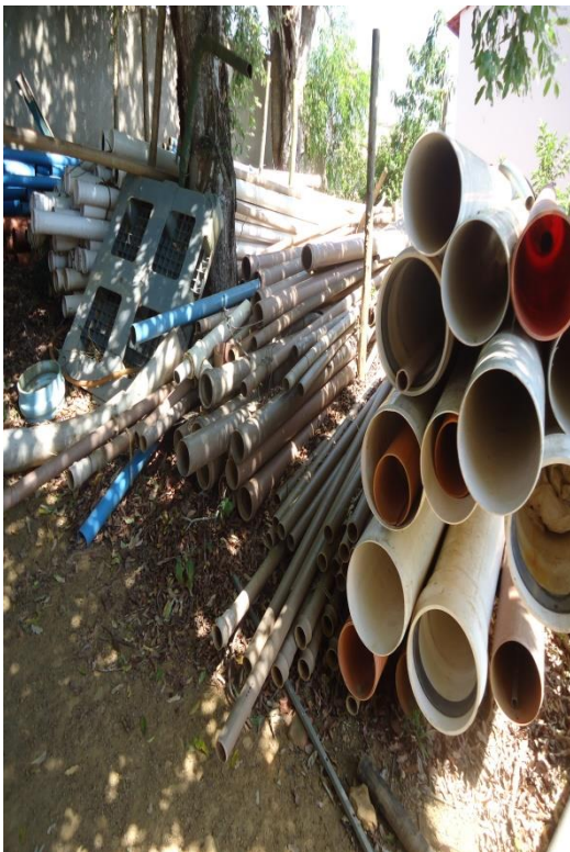
Figura 83 – Almoxarifado de Tubo.
