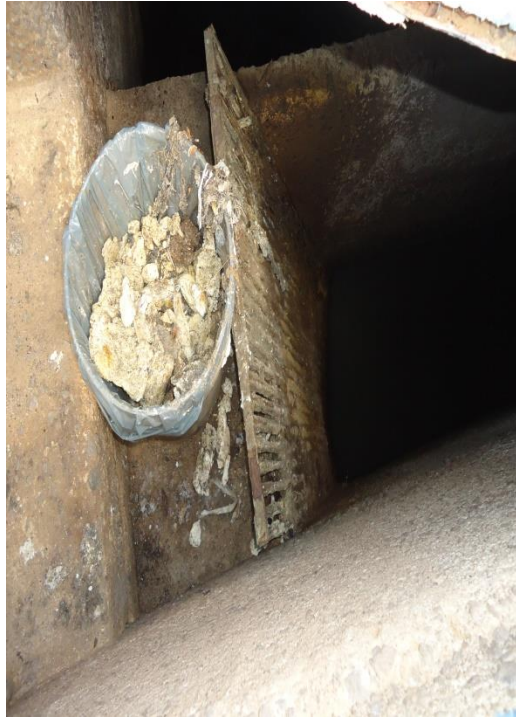
Figura 103- Grade de retenção dos sólidos.
