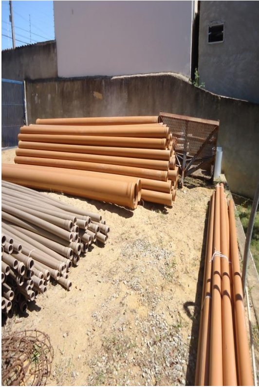
Figura 85 – Tubos exposto ao tempo.
