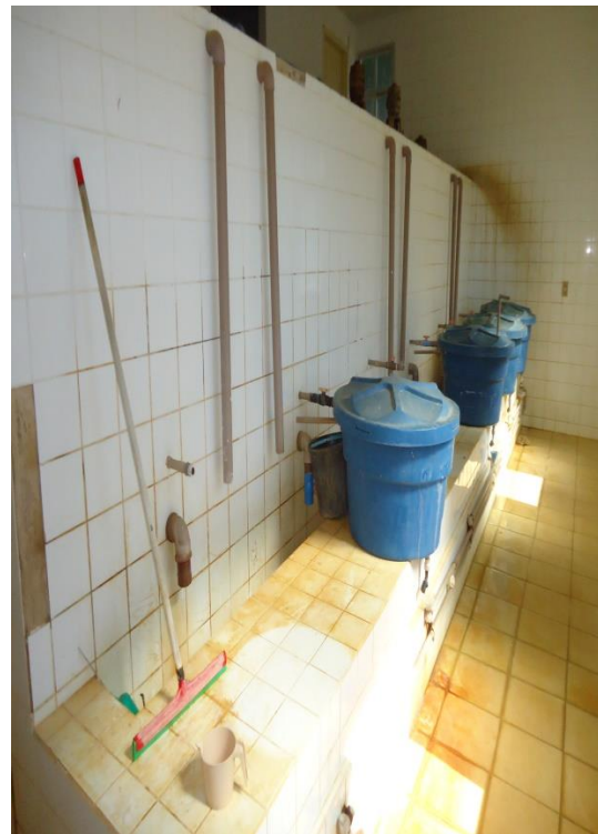
Figura 23 – Dosadores ETA Sede.
