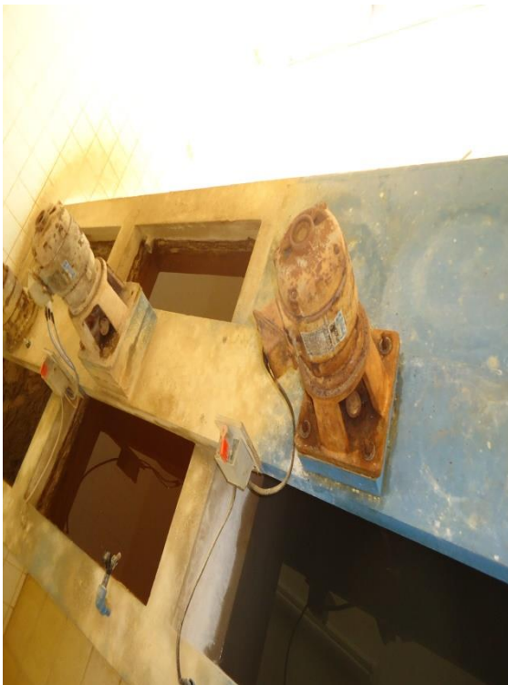
Figura 22 – Tanques de dosagem.
