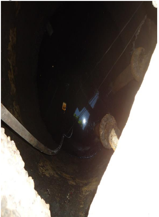
Figura 98- Poço de sucção.
