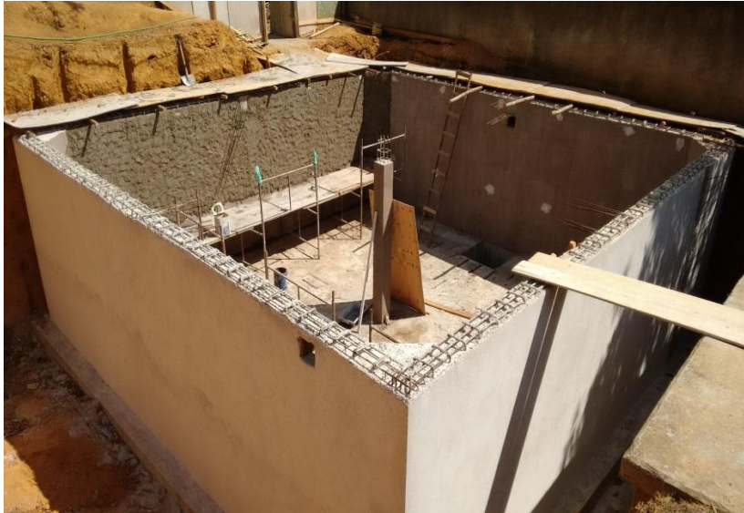
Figura 08 – Construção do Reservatório localizado na Sede.
