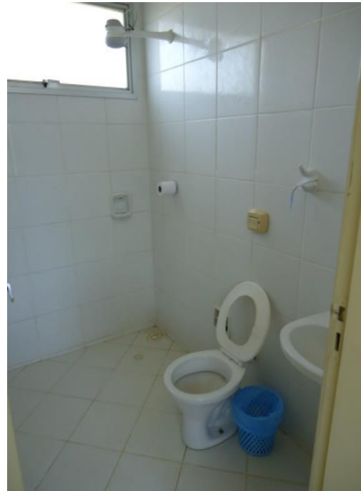
Figura 79 – Banheiro ETA da Sede 2.
