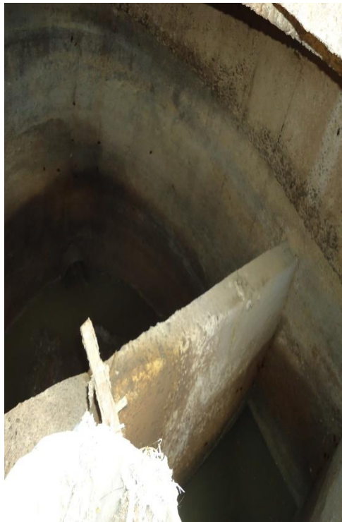
Figura 105 - Caixa desarenadora.
