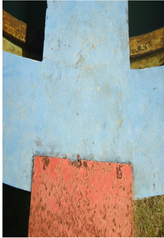
Figura 38- Passarela com excesso de Corrosão.
