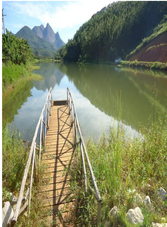
Figura 6 – Excesso de Vegetação.
