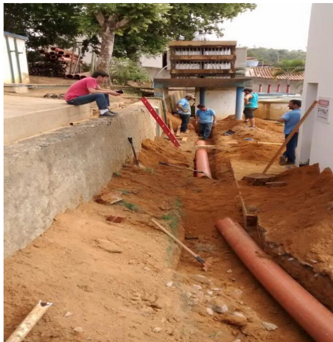
Figura 06 – Construção de duas novas adutoras.
