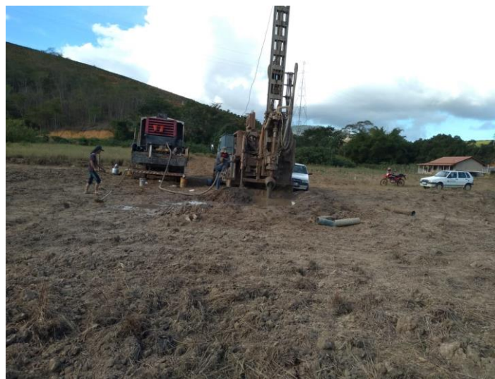
Figura 12- Construção de Poço Artesiano.
