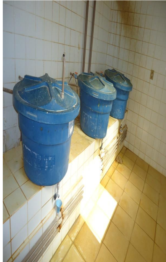
Figura 25 – Dosadores da ETA Sede.
