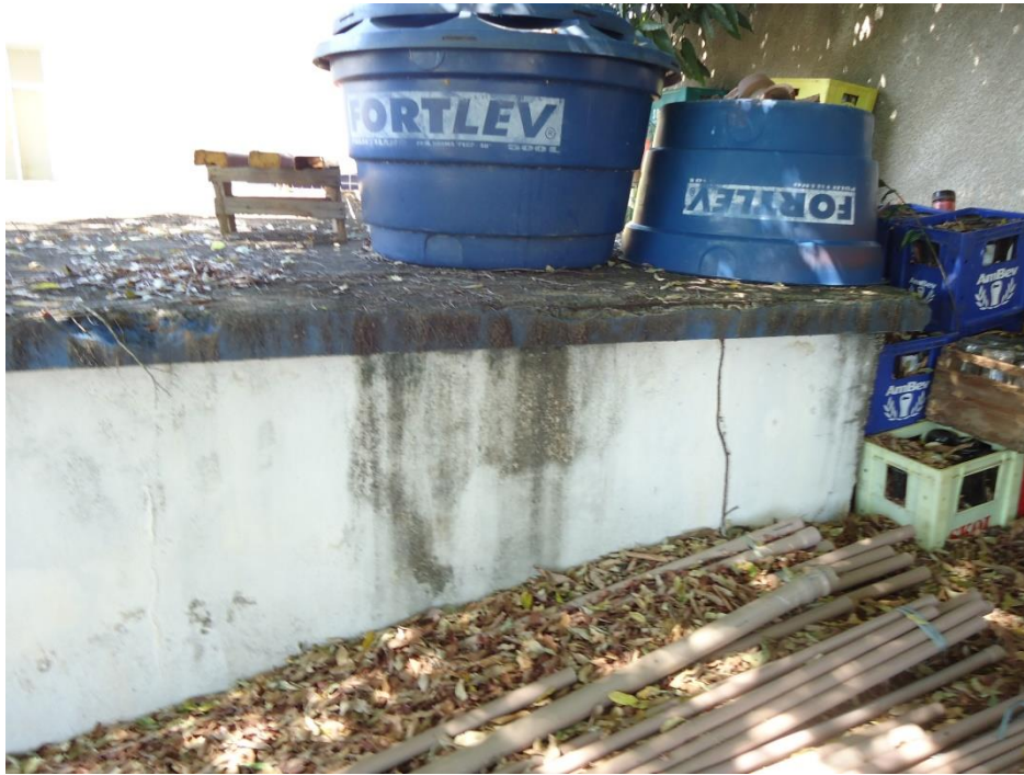
Figura 90– Reservatório 3 há necessidade de manutenção de limpeza.
