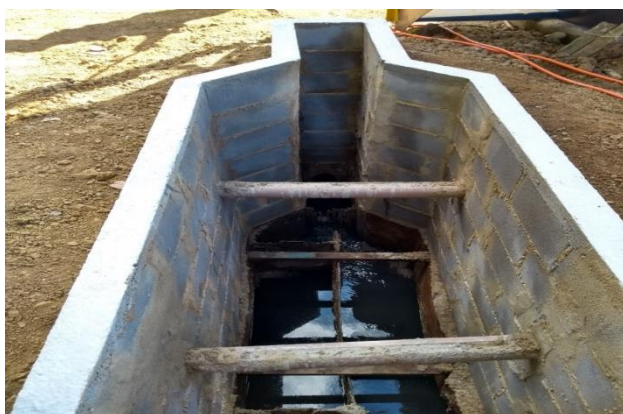
Figura 18 – Construção da Unidade de Pré Tratamento do Efluente na ETE São Marcos.
