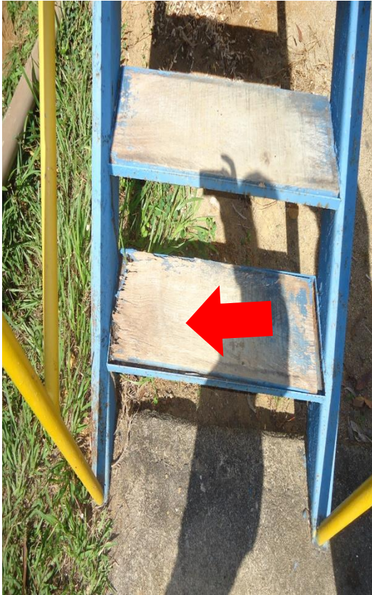
Figura 44 – Escada de Acesso.
