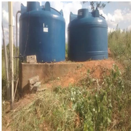
Figura 09 – Reservatórios instalados em Comunidades.
