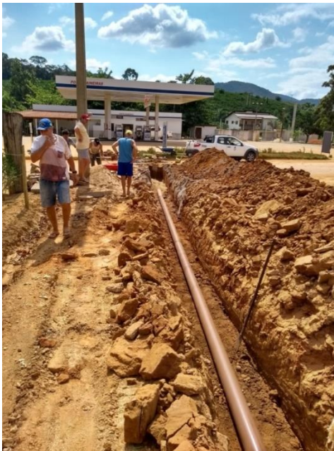
Figura 14 – Rede de esgotamento sanitário.
