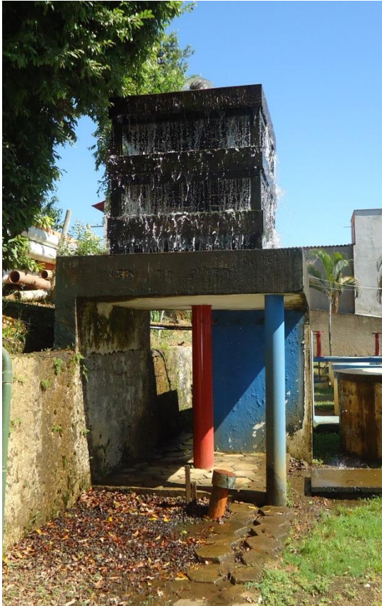
Figura 27 - Chegada da Água Bruta na ETA.
