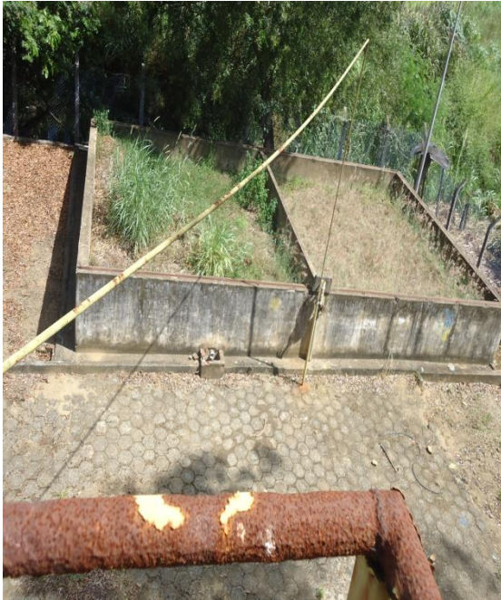
Figura 111 – Leito de secagem.
