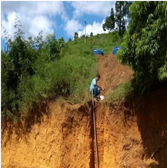
Figura 10 – Construção de Poço Artesiano.
