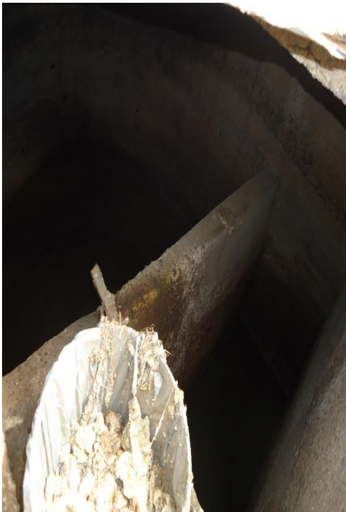
Figura 104- Caixa desoneradora.
