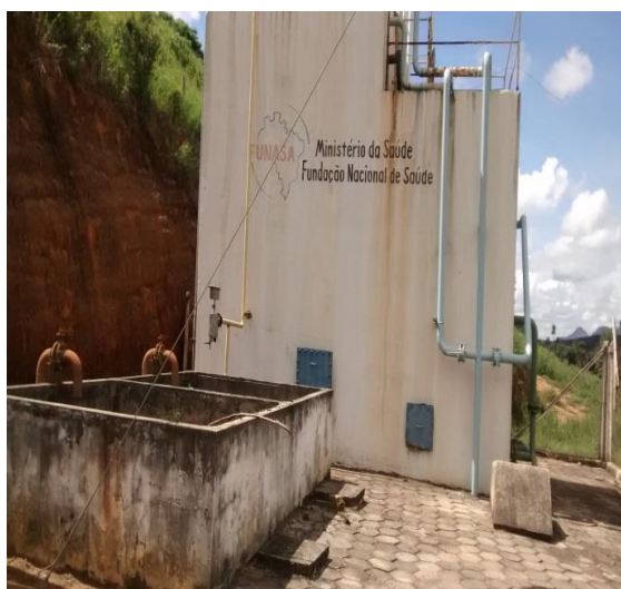
Figura 16- ETE Comunidade São Marcos.
