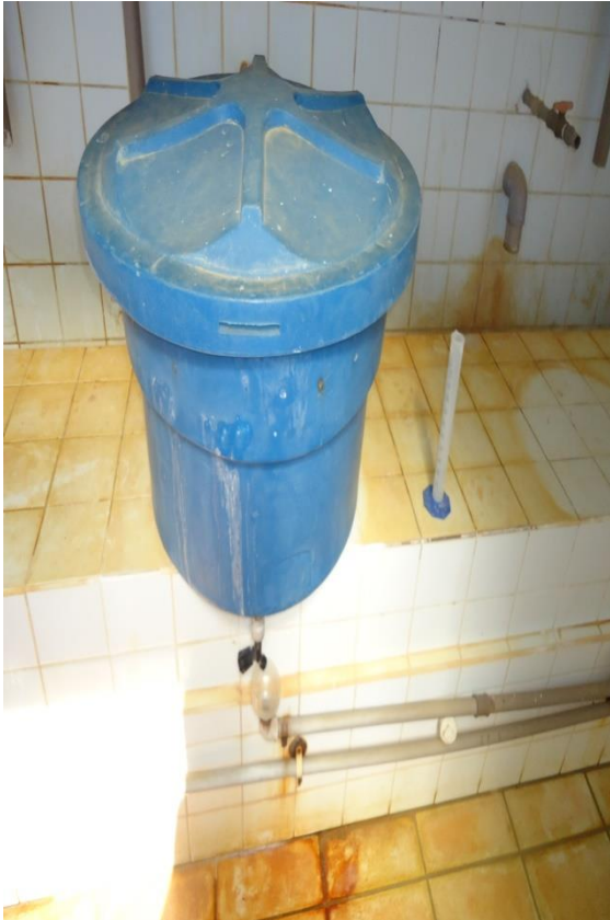
Figura 24 – Dosador ETA Sede.
