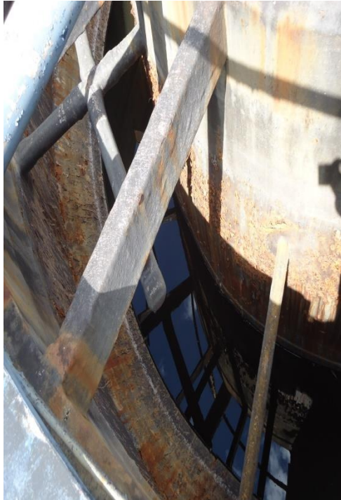
Figura 118 – Excesso de Corrosão.
