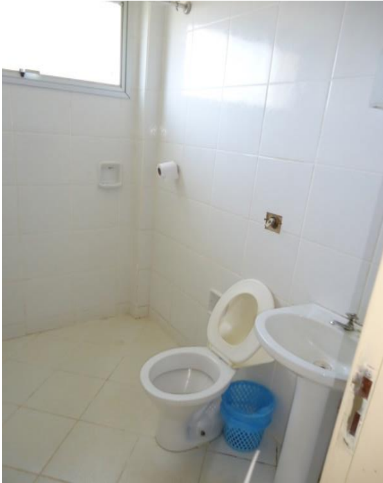
Figura 78 – Banheiro ETA da Sede 1.
