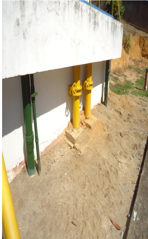
Figura 48- Registro dos filtros sem . vazamento.
