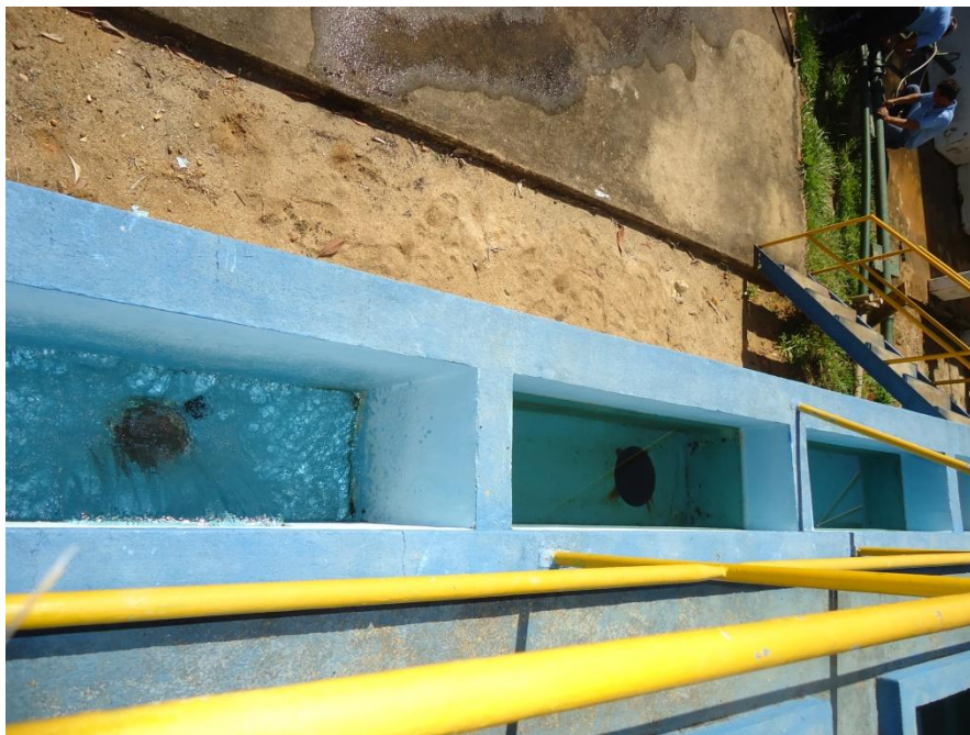
Figura 46 - Estrutura de Passagem da água Tratada para os reservatórios.
