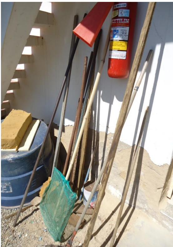
Figura 80 – Armazenamento de ferramentas.
