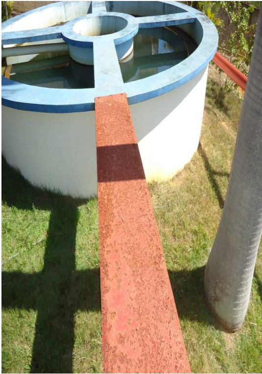
Figura 37 – Passarela de acesso ao Decantador 2.
