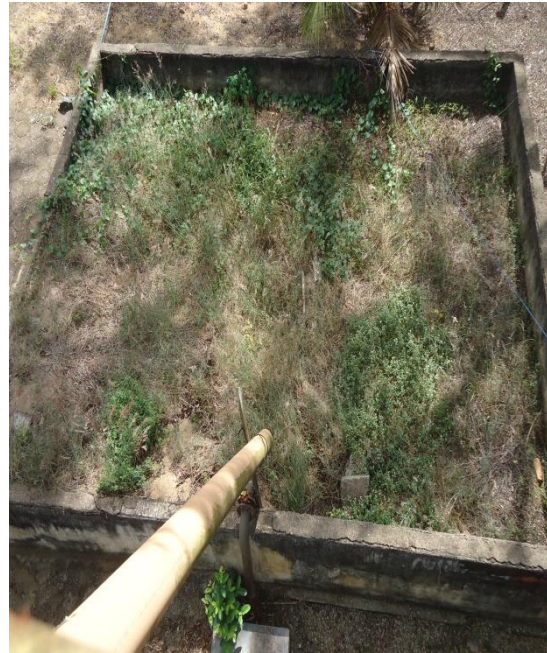
Figura 112 – Leito de Secagem.
