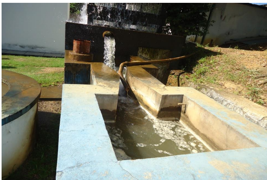
Figura 29 – Calha Parshall.
