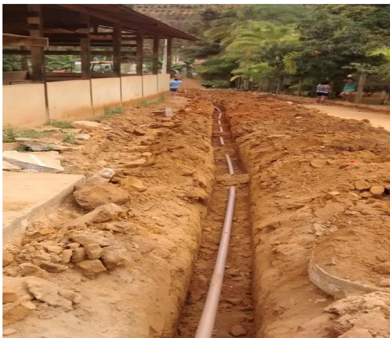
Figura 11 – Construção de Rede de Água
