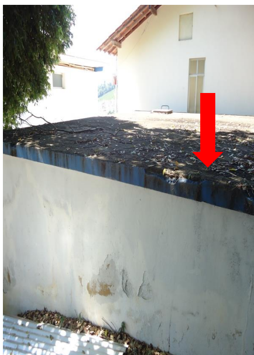
Figura 89- Reservatório 3, ferragem exposta.
