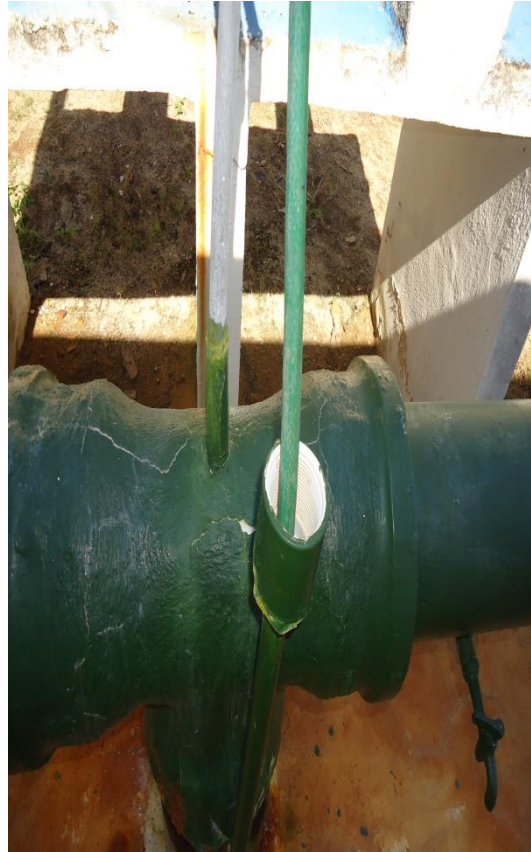
Figura 45 – Dosador na Tubulação dos Reservatórios.
