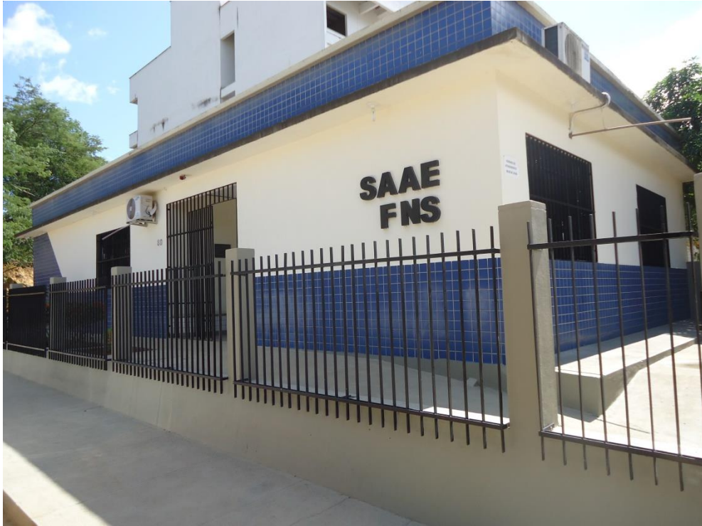
Figura 120 – Escritório de Atendimento SAAE Marilândia.
