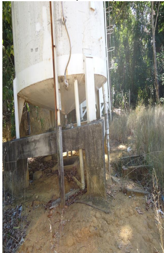
Figura 92 – Estrutura dos reservatórios 4 e 5.
