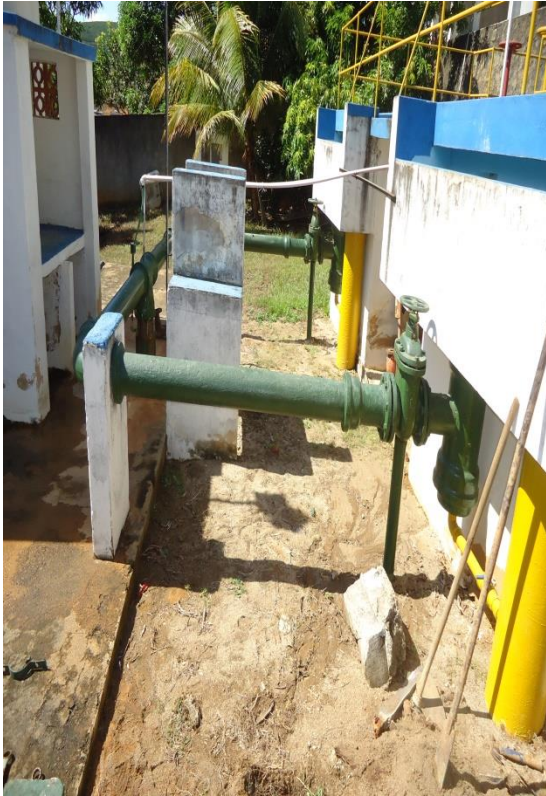
Figura 47 - Registro dos Filtrros.
