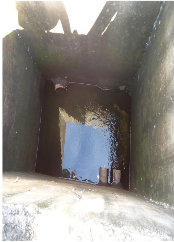
Figura 4 – Estrutura da Barragem.
