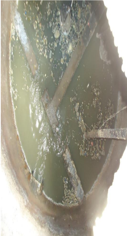
Figura 106- Poço de sucção.
