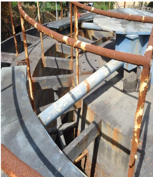
Figura 116- Unidade de Tratamento.
