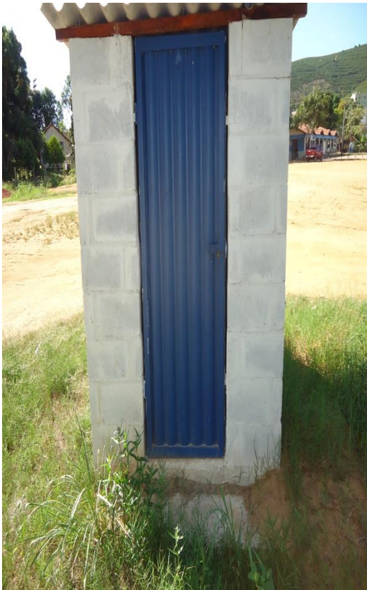
Figura 8 - Poço de Captação Centro 1
