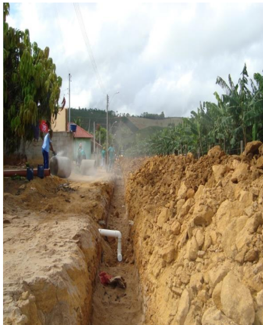
Figura 15 – Construção Rede de de esgotamento sanitário.
