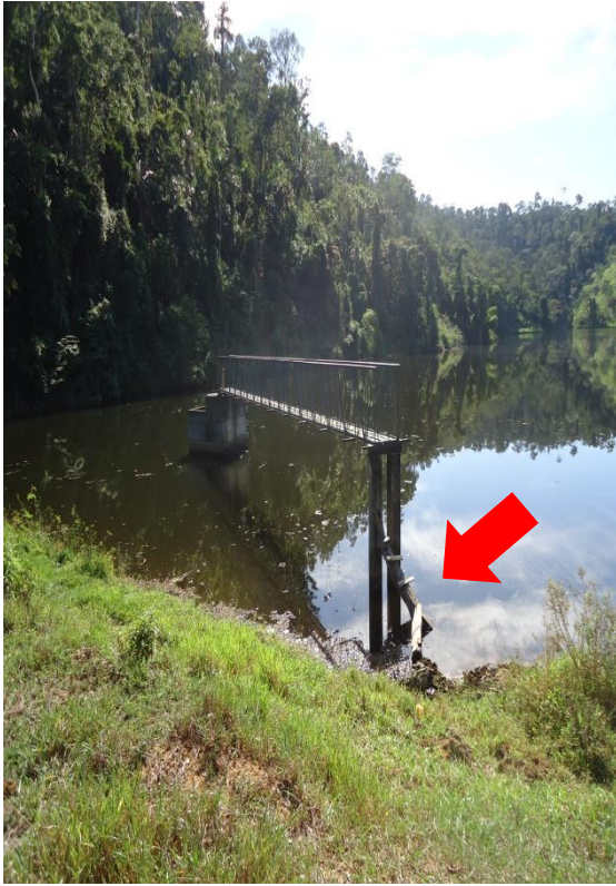
Figura 3 - Falta escada de Acesso.
