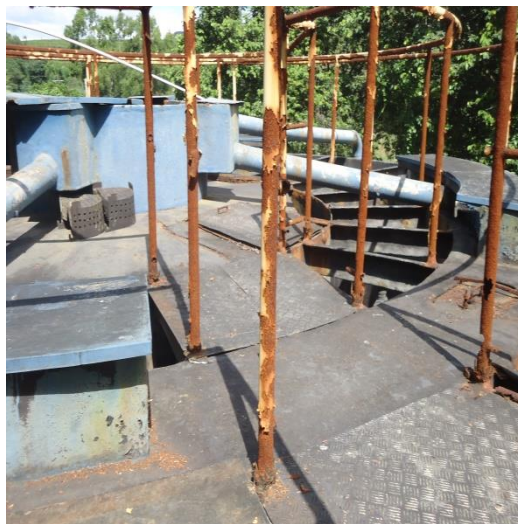
Figura 115 - Unidade de Tratamento.
