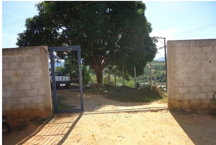
Figura 18 –ETA de Marilândia.
