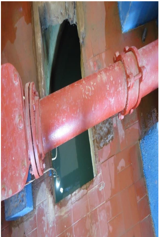
Figura 14 – Captação da EEAB.
