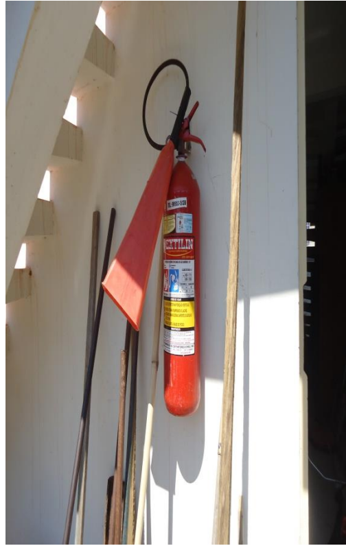
Figura 86 – Extintor de Incêndio.
