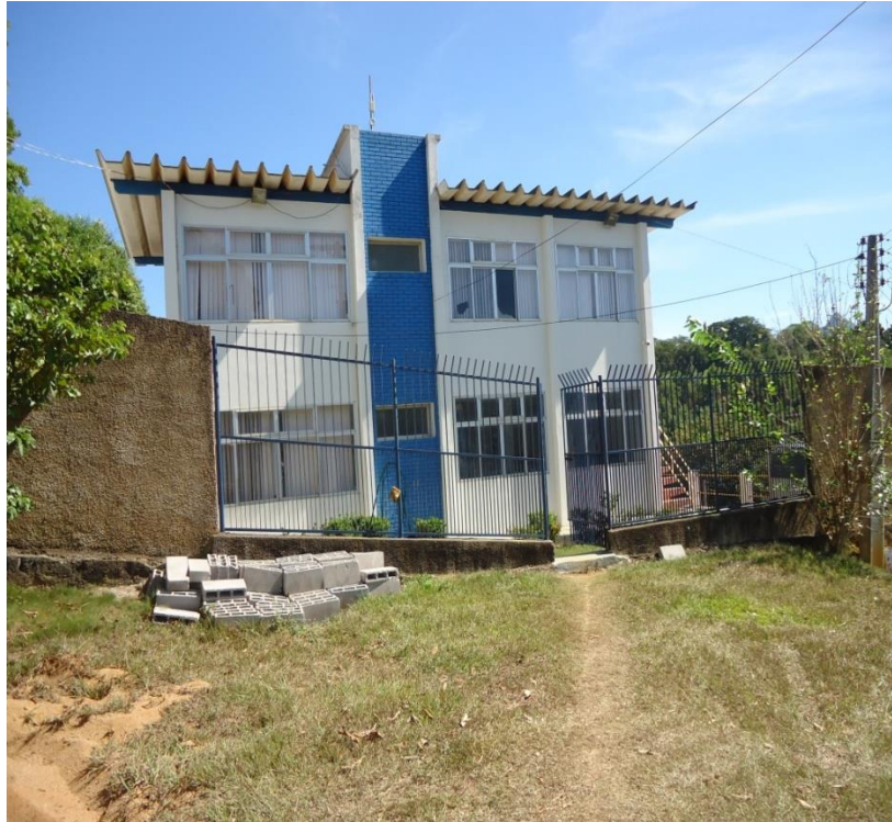
Figura 21 – Entrada da ETA.
