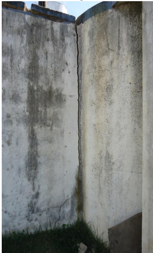
Figura 41 - Fissura entre o filtro e descarga.
