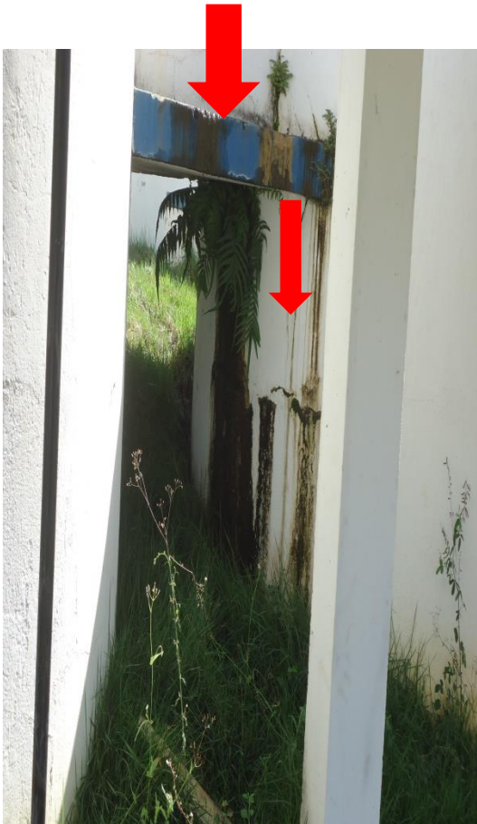
Figura 37 – Fissuras no Decantador 1.
