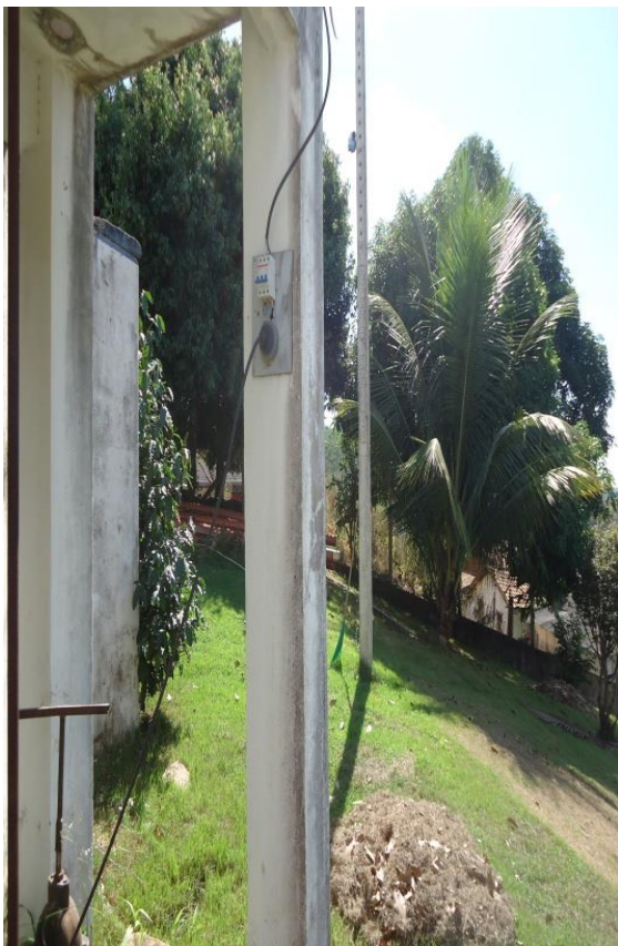
Figura 48 – Fiação exposta na ETA 2.
