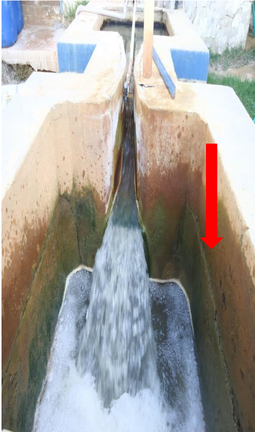
Figura 28 – Calha parshall
