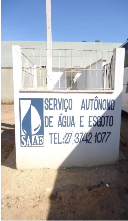
Figura 15– Entrada do Poço artesiano.
