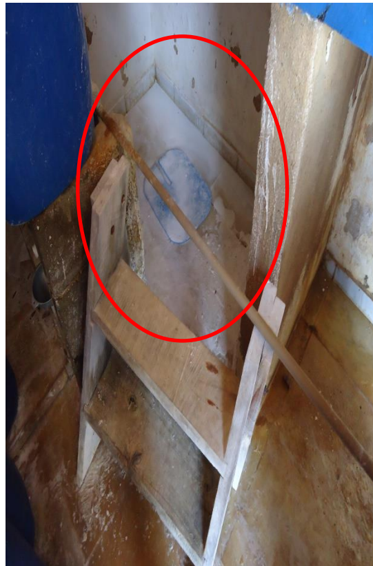
Figura 25 – Excesso de Produto no Chão.
