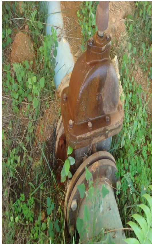
Figura 45 – Tubulação filtros ETA 1 com vazamento.
