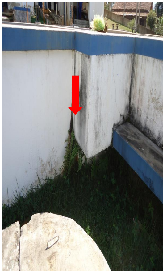
Figura 38 – Fissuras no Decantador 1.
