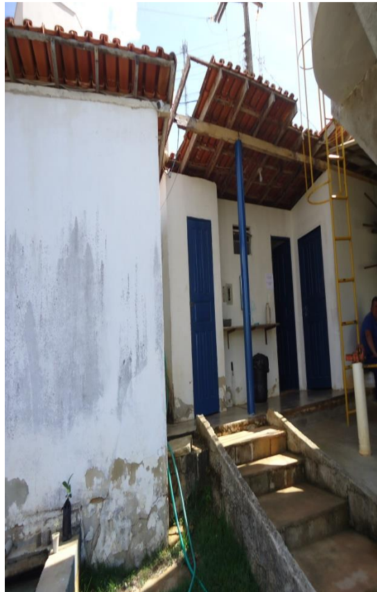
Figura 73 – Área de apoio da ETA São Domingos.
