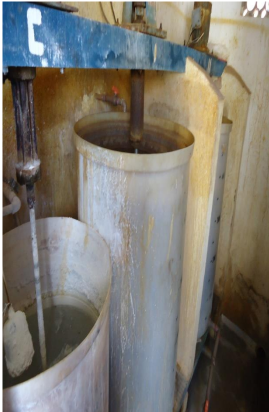
Figura 26 – Tanques de dosagem de Sulfato.
