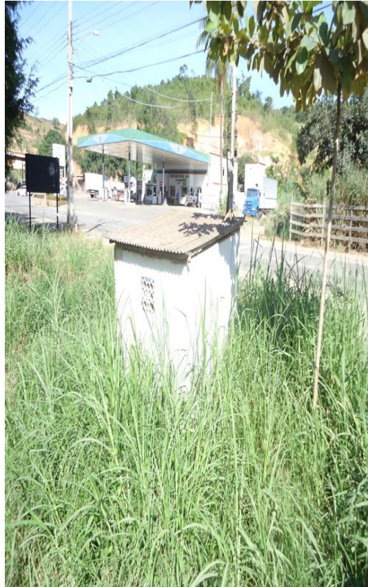
Figura 10 – Acesso a captação.
