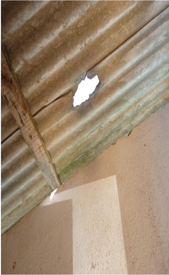
Figura 91 - Telhado da EEAT Bairro Cris.
