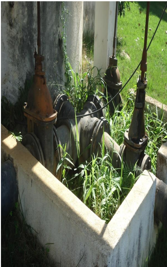
Figura 44– Tubulação filtros ETA 1.
