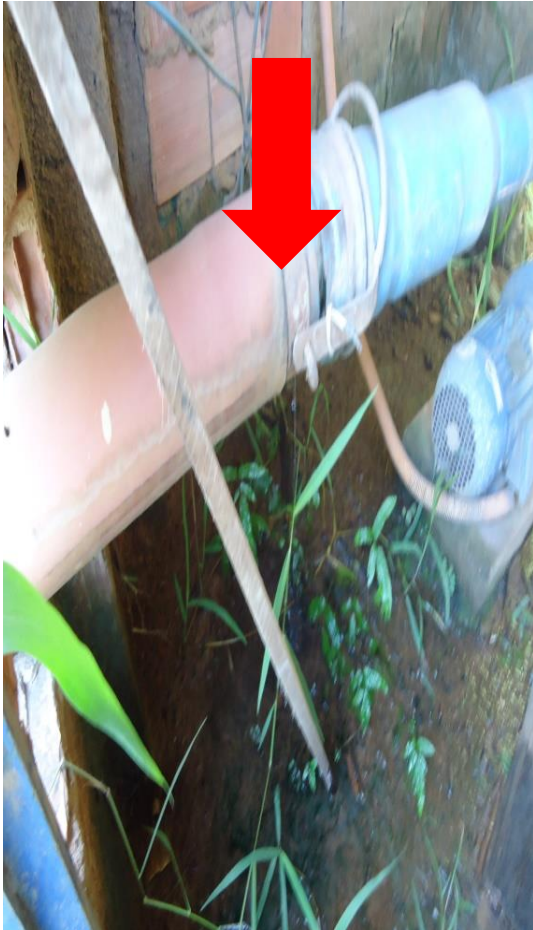
Figura 13 – Vazamento visível na tubulação.
