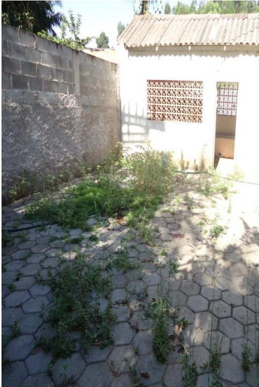
Figura 3 – Excesso de Vegetação na EEAB.
