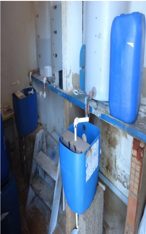
Figura 27 – Dosador flúor, flúor, Cloro.
