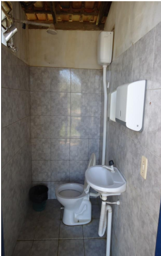
Figura 72 – Banheiro ETA da Sede.
