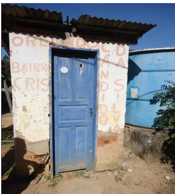
Figura 87 – Casa de bomba EEAT Bairro Cris
