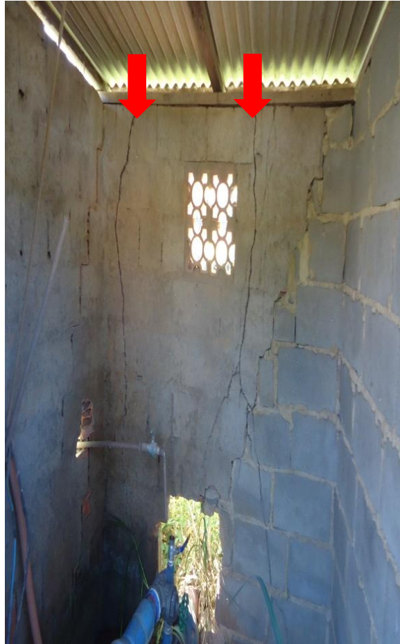
Figura 14 – EEAB com fissuras.
