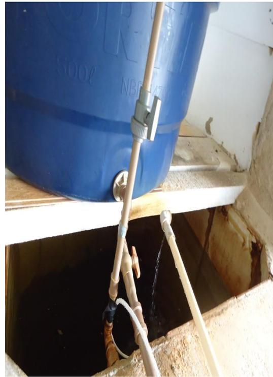
Figura 20 – Tanque nº1 dosagem de cloro.
