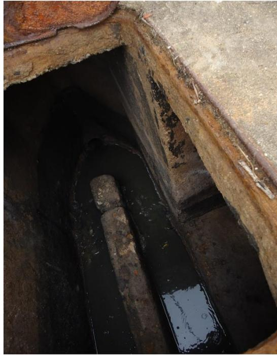
**Figura 220- Caixa desarenadora.**
