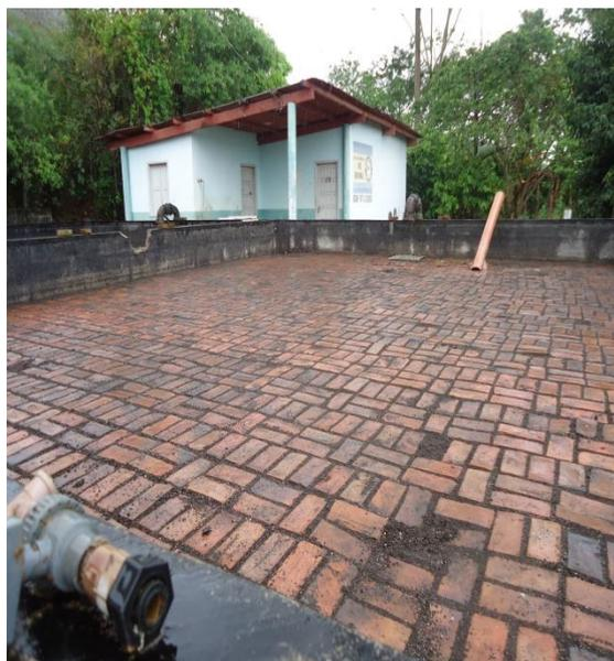
**Figura 208 – Estrutura Leito de Secagem.    Figura 209- Leito de Secagem.**
