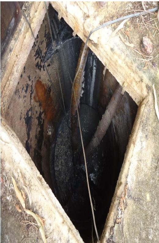
**Figura 221- Poço de Sucção.**
