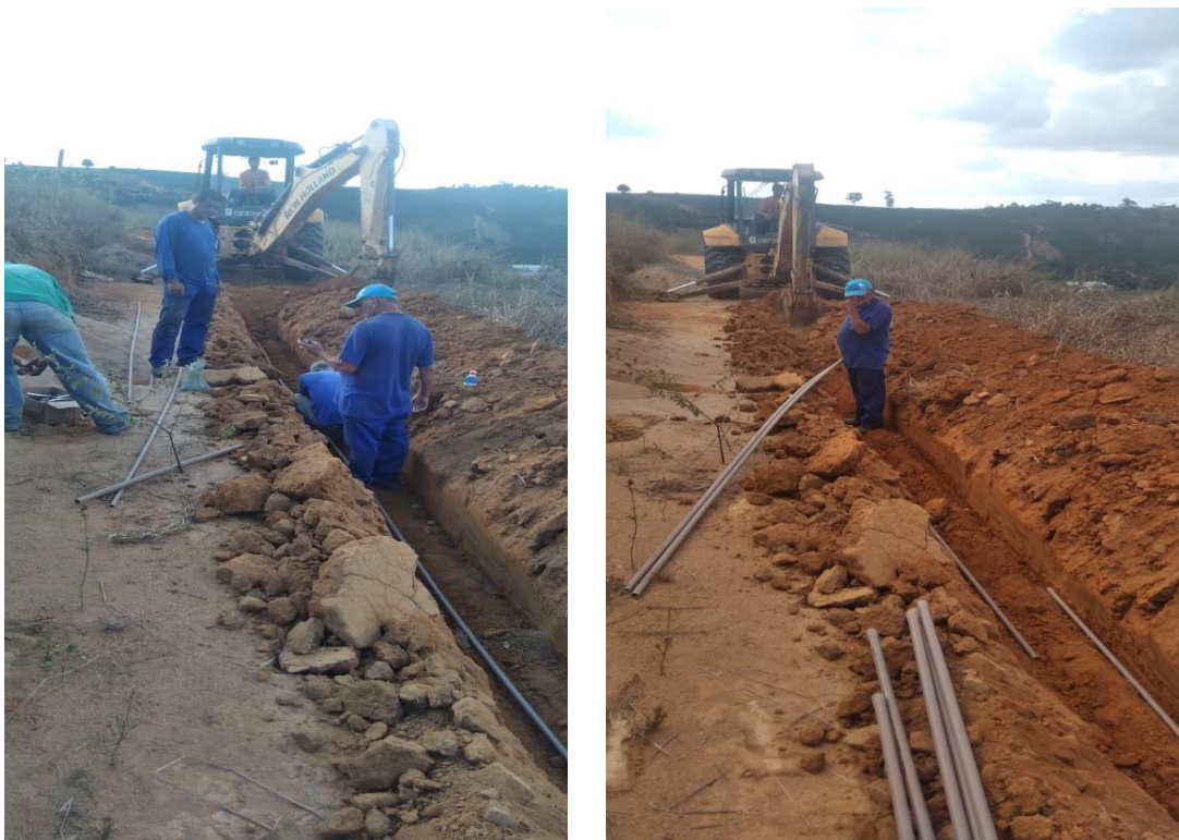
Figura 38 e 39 – Substituição de Rede inadequadas por novas redes;
