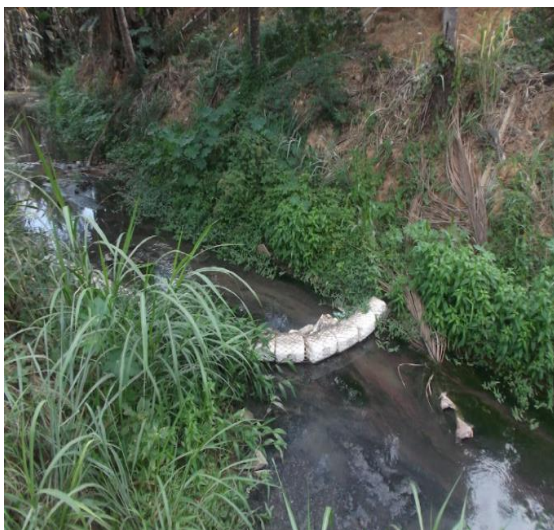
Figura 33 e 34– Barreira de proteção de lixo próximo a captação do Rio São Domingos.
