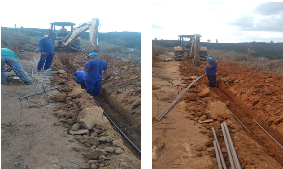
Figura 52 e 53 – Substituição das redes inadequadas por novas redes na Serra da Mula;
