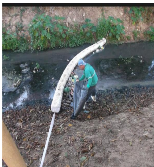
Figura 24 e 25 – Barreira de Proteção , para filtrar lixo do rio.
