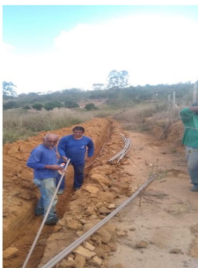
Figura 54– Substituição das redes inadequadas por novas redes na Serra da Mula;
