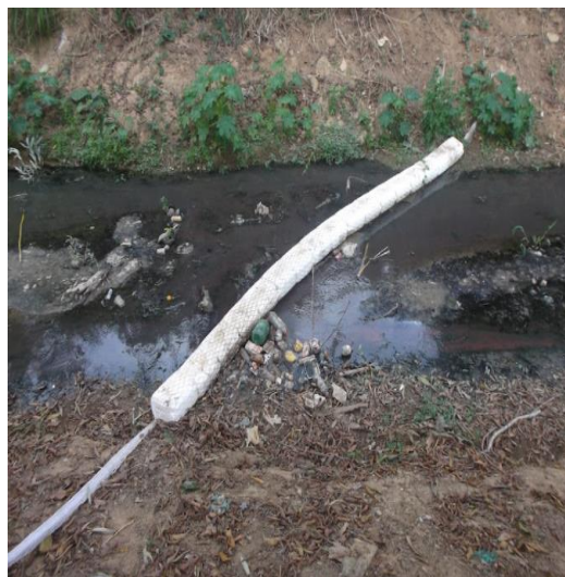
Figura 33 e 34– Barreira de proteção de lixo próximo a captação do Rio São Domingos.
