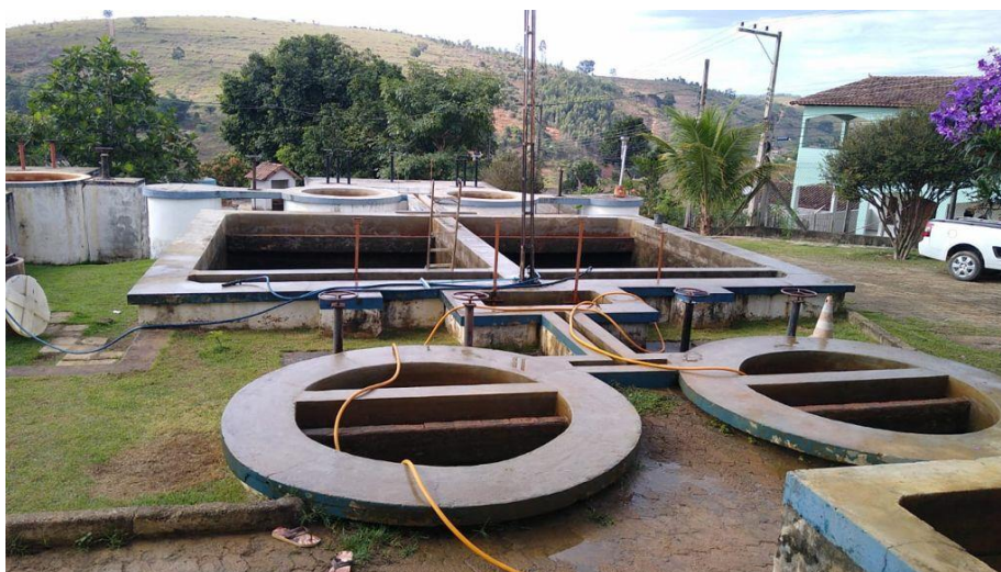
Figura 49 – ETE de São Domingos do norte dando manutenção de Limpeza em toda a estrutura;
