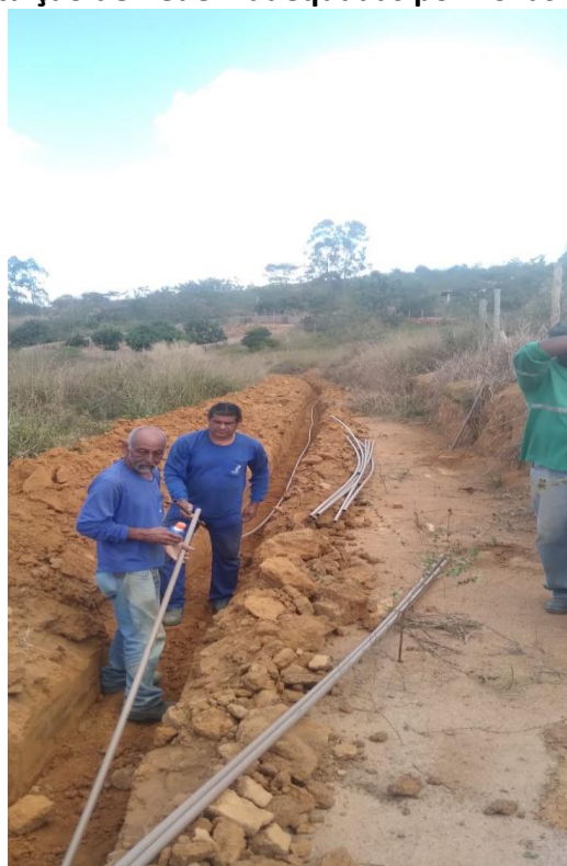
Figura 40 – Substituição de Rede inadequadas por novas redes;
