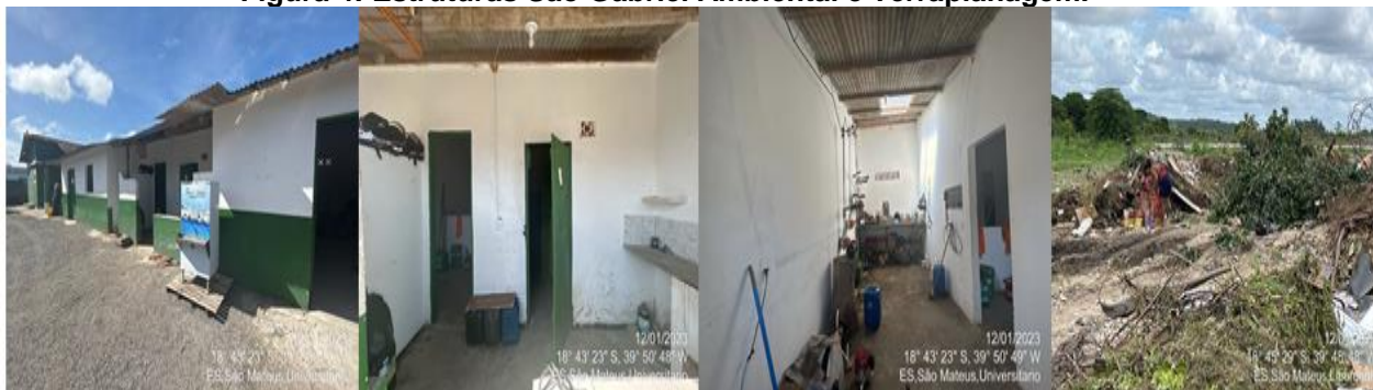
Figura 4: Estruturas São Gabriel Ambiental e Terraplanagem.
