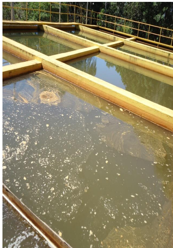
Figura 36 – Decantador ETA 2.
