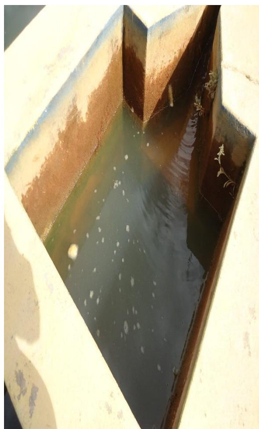
Figura 167 – Calha parshall.
