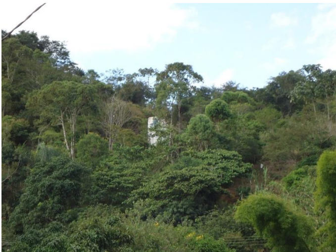
Figura 179.1–Reservatório 2 de aço.
