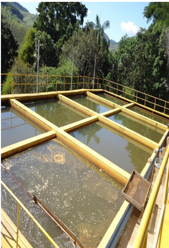
Figura 35 –Decantador ETA 2
