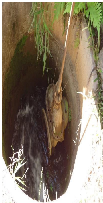
Figura 59, Figura 60, Figura 61 – Descargas dos Filtros.
