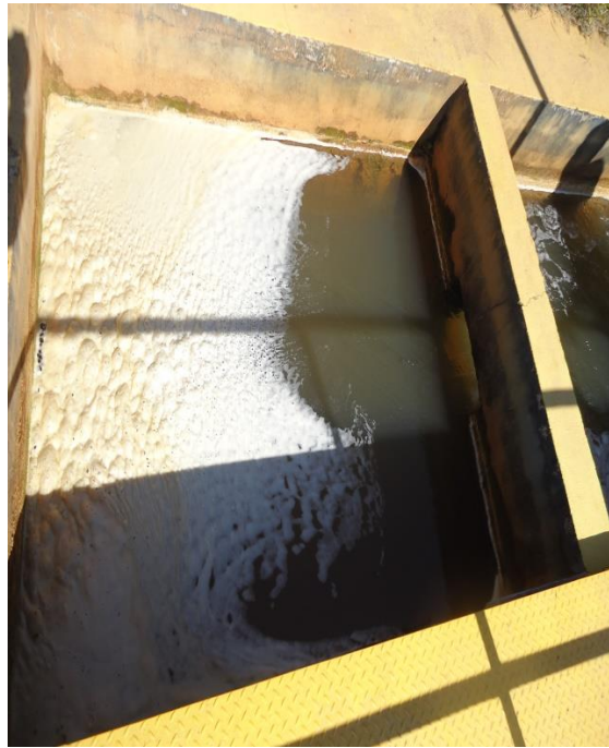
Figura 30 – Floculador ETA 2.
