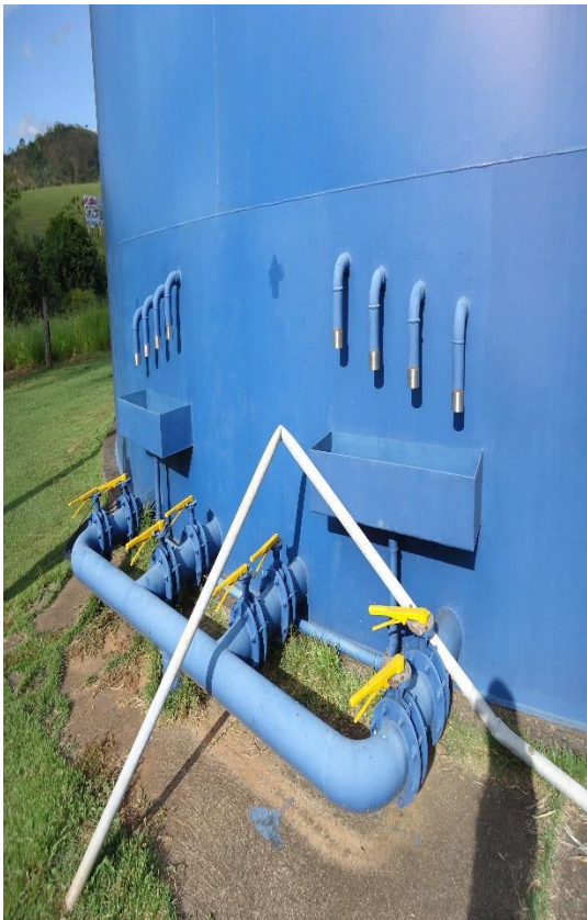
Figura 216 – Tubulações sem corrosão.
