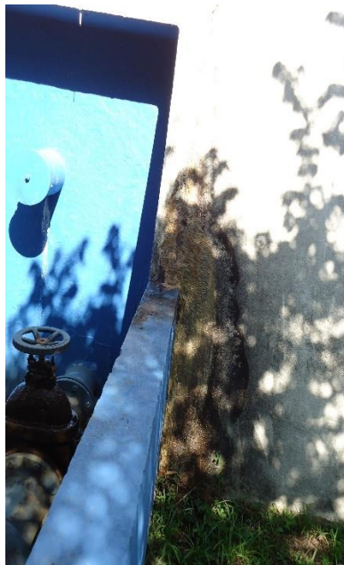
Figura 44 e 45- Fissura no registro 1 .
