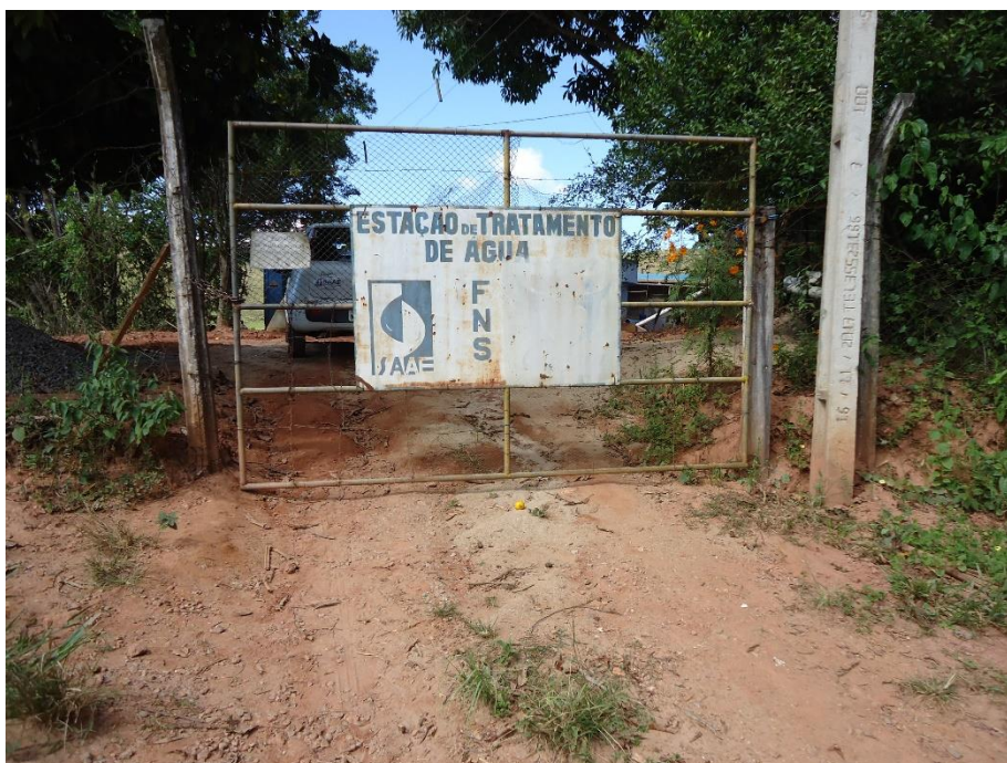
Figura 193 – Entrada da ETA do Distrito São Tiago.
