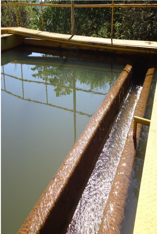
Figura 37 – Decantador ETA 2.
