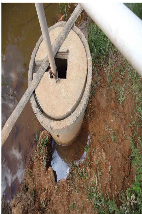
Figura 158 – Poço de Sucção.
