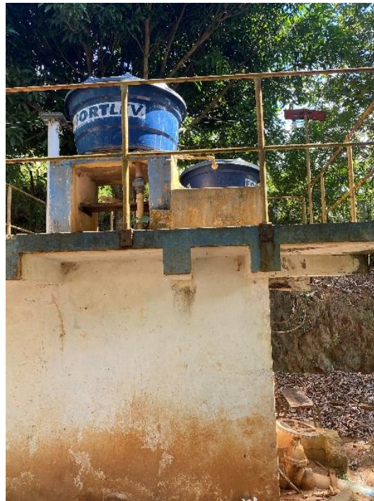
Figura 102 – Estrutura da ETA desativa.
