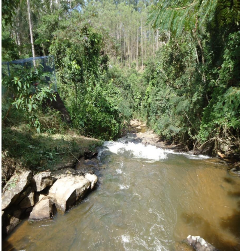
Figura 5 – Captação São Felipe – Município de Guaçuí.
