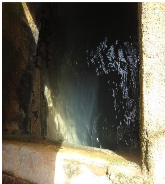
Figura 205 – Interior do Reservatório 1.
