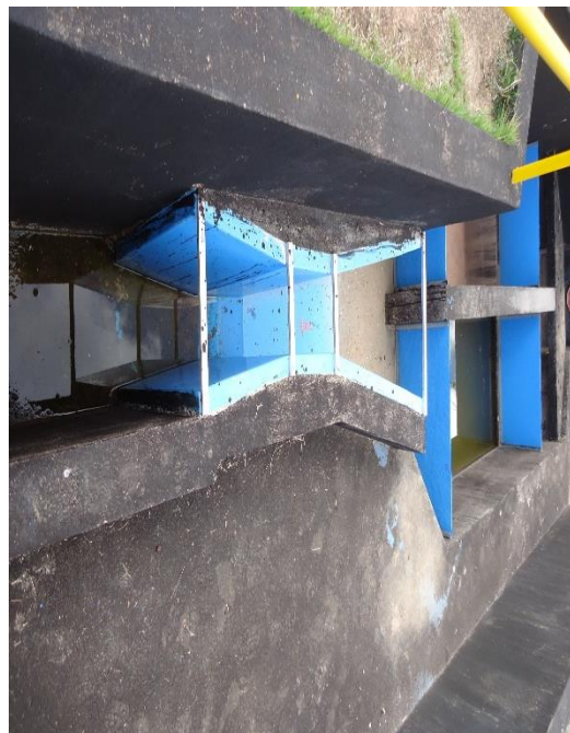
Figura 214 – Calha Pashall.
