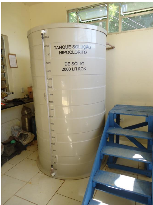
Figura 17 e Figura 18– Tanques de dosagem.
