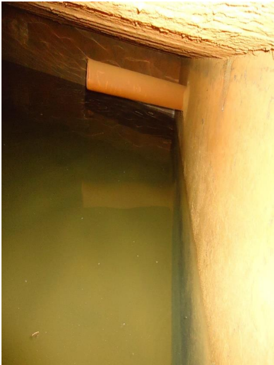
Figura 178 – interior do Reservatório.
