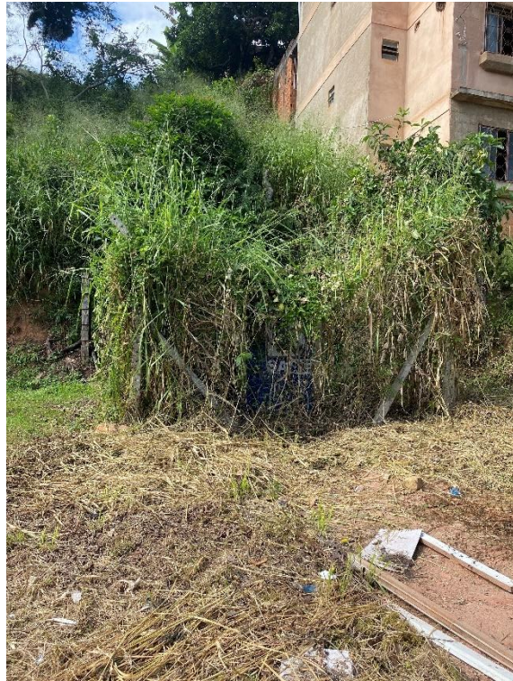
Figura 91 – Casa de bomba EEAT jurema.
