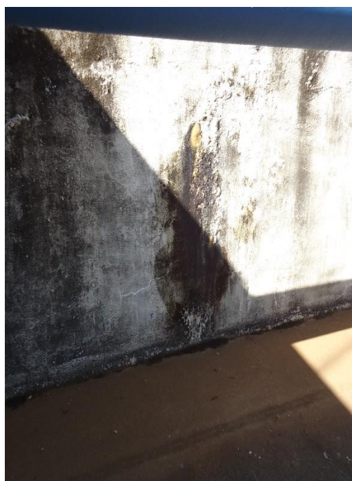
Figura 48 e 49- Fissura na estrutura do decantador próximo aos registro dos filtros 2 e 3.
