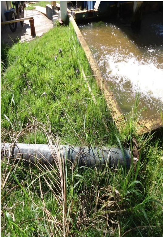
Figura 13– Excesso de Vegetação no pátio da ETA.
