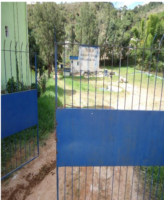
Figura 164 – Entrada da ETA.
