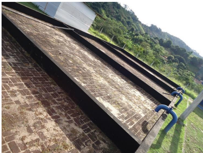
Figura 212- Leito de Secagem
