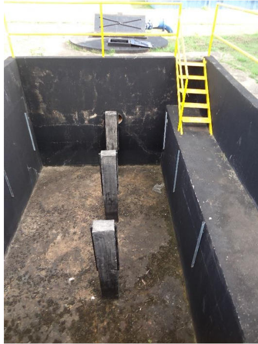
Figura 215 – Estrutura de passagem.
