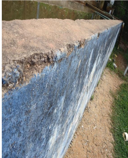
Figura 198 – Unidade de Floculação e decantação.
