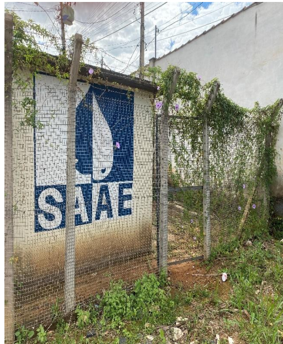
Figura 108 – Casa de bomba EEAT Manoel Monteiro Torre.
