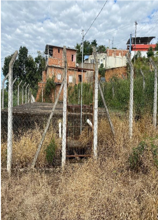
Figura 147 – Reservatório EEAT Moreira.
