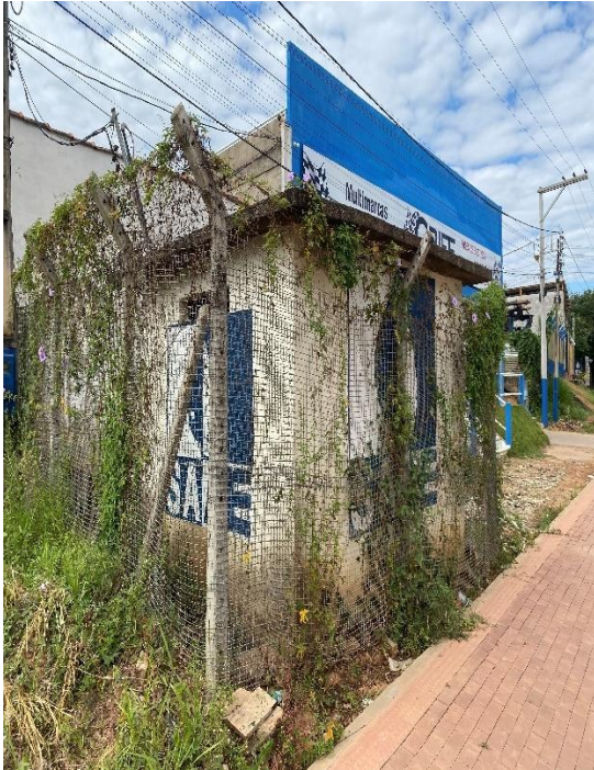
Figura 107 – Casa de bomba EEAT Manoel Monteiro Torre.
