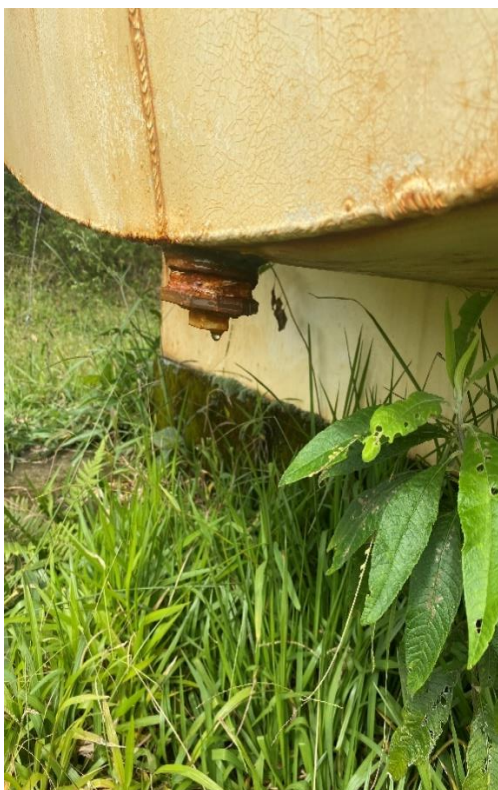
Figura 121 – Vazamento Reservatório 2.
