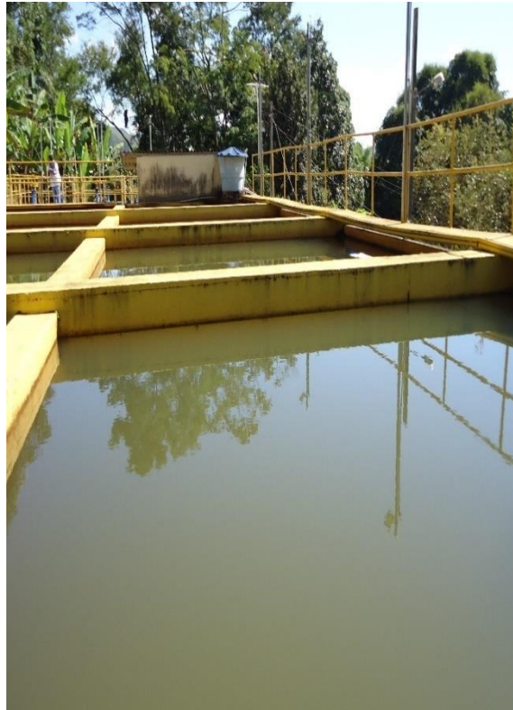
Figura 38 – Decantador ETA 2.
