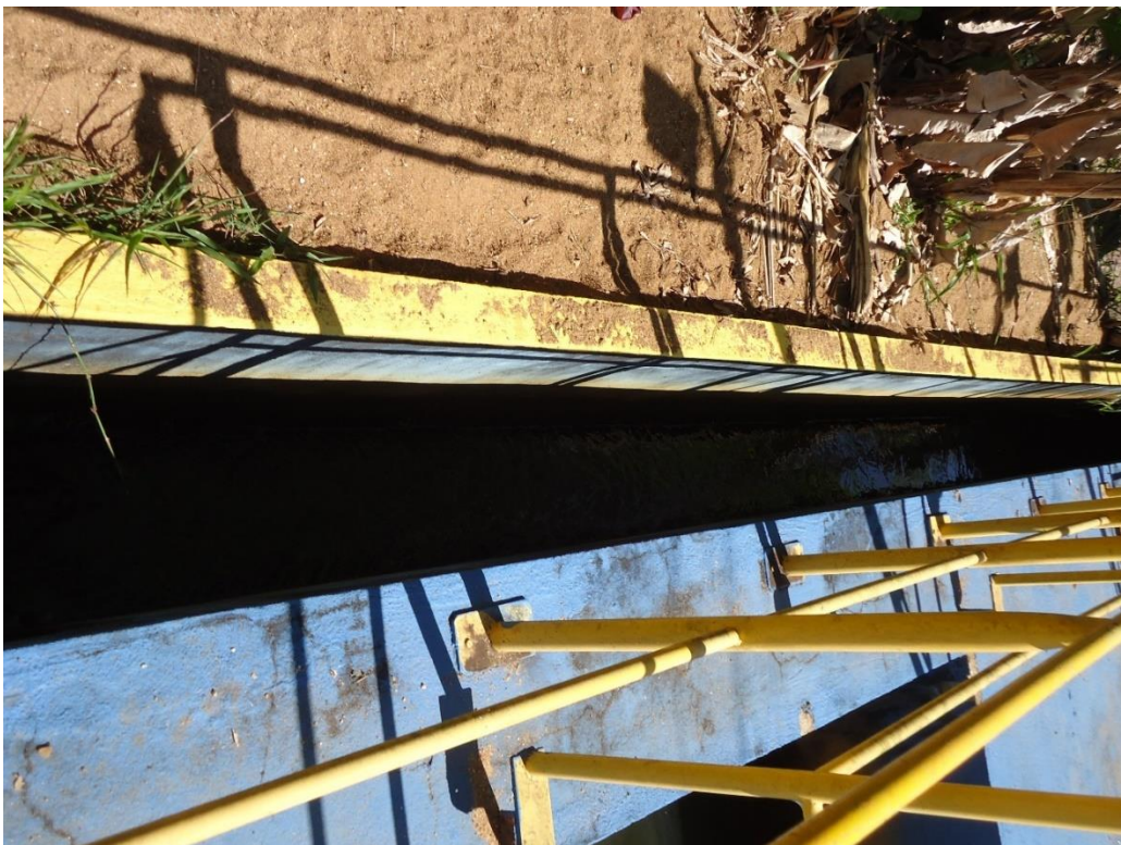
Figura 52 – Estrutura de passagem.
