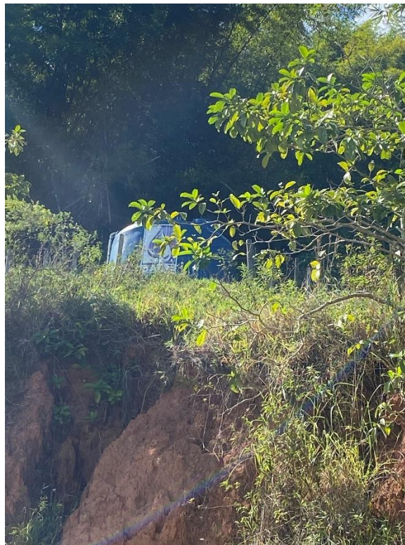
Figura 92 – Acesso ao Reservatório da EEAT Jurema.
