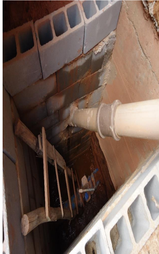
Figura 209 - Registro da ETA.
