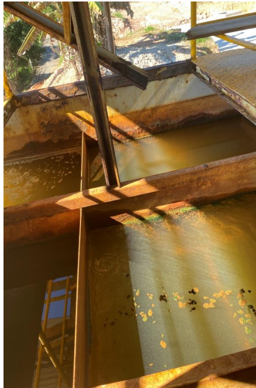
Figura 27 – Flocculador ETA 1.
