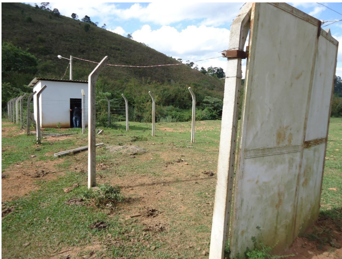
Figura 155 – Captação realizada pela EEAB do Distrito de São Pedro Rates.
