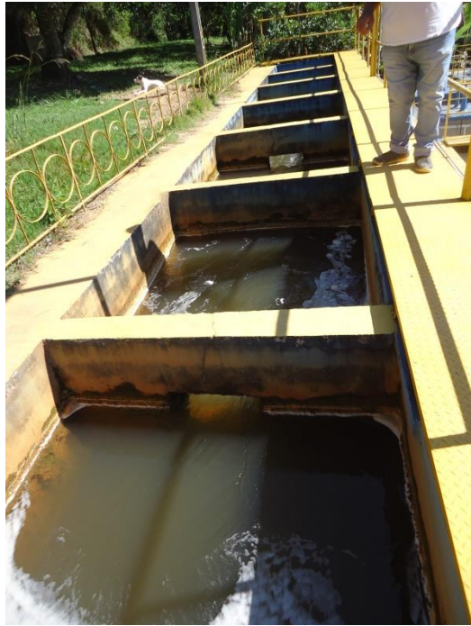
Figura 29 – Floculador ETA 2.
