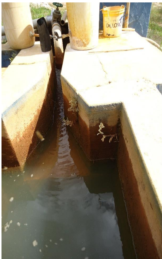
Figura 166 – Entrada da Água Bruta na ETA.
