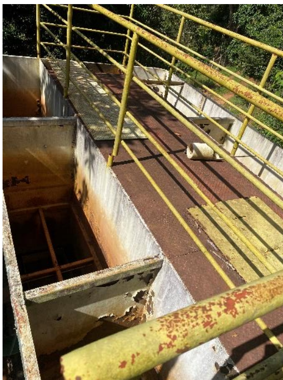
Figura 103 – Estrutura da ETA desativa.
