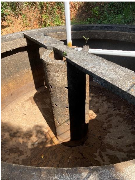
Figura 101 – Estrutura ETA desativa.
