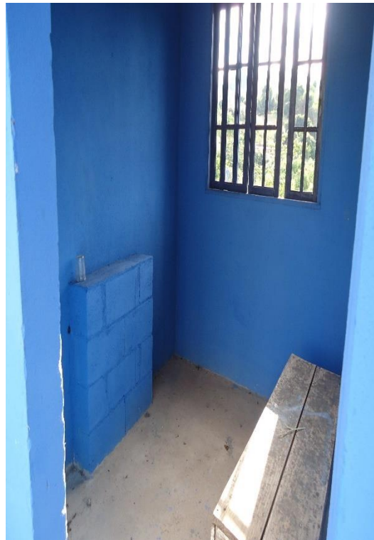
Figura 211- Casa de Apoio ao Colaboradores.
