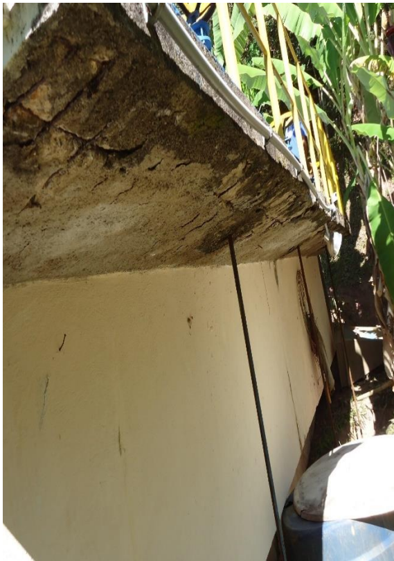
Figura 57 e Figura 58 - Passarela de acesso aos filtros com ferragem exposta.
