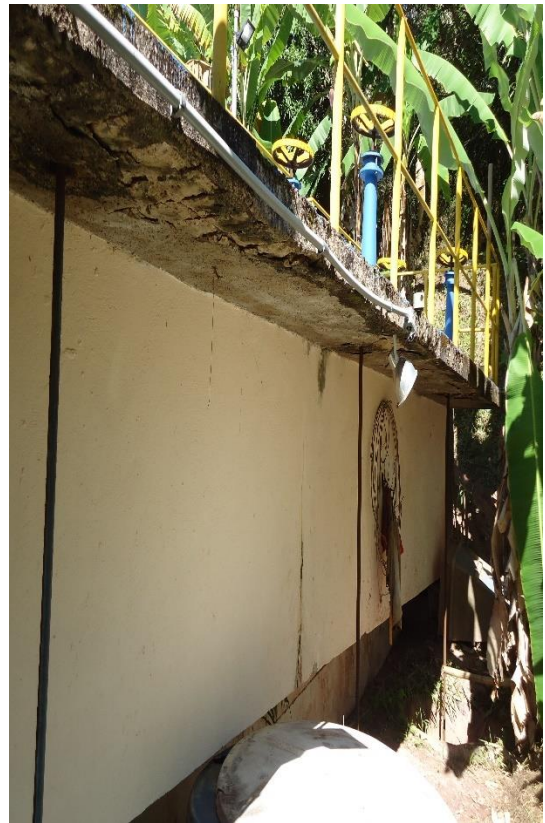
Figura 57 e Figura 58 - Passarela de acesso aos filtros com ferragem exposta.
