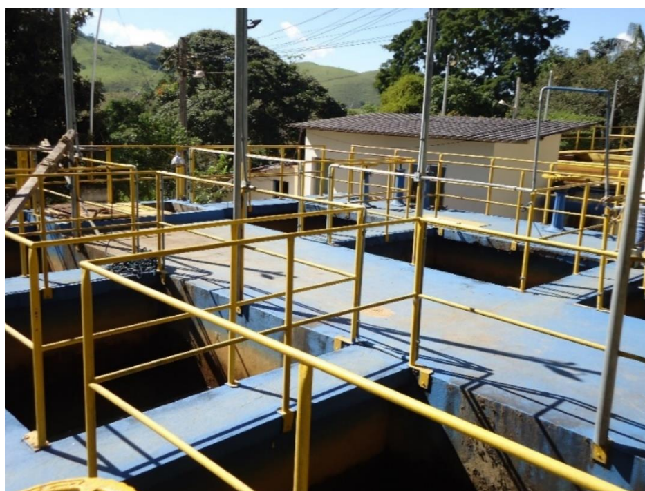
Figura 53 – Filtros descendentes da ETA 2.
