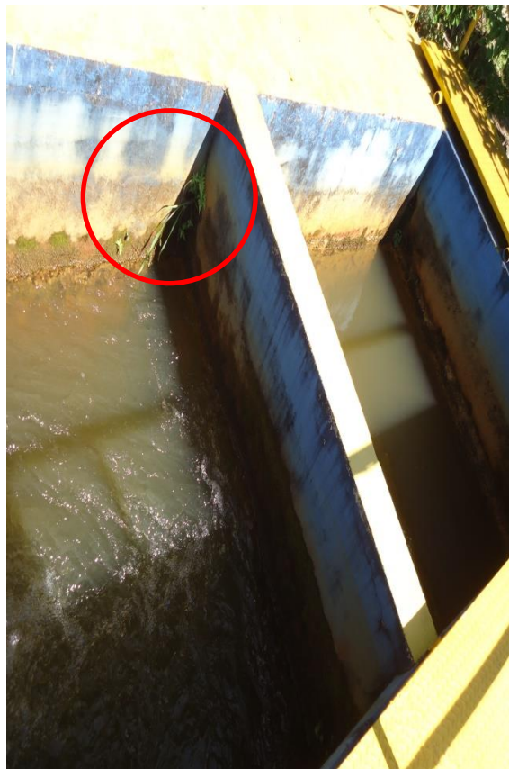
Figura 32 – Vegetação Floculador ETA 2.
