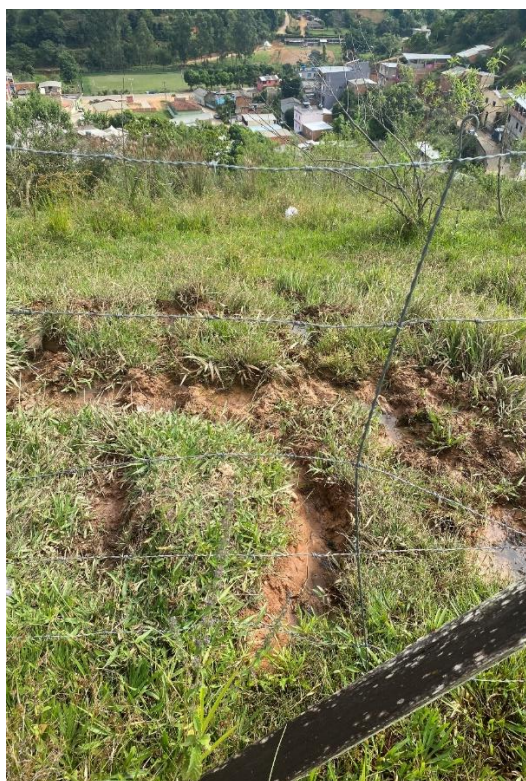
Figura 122 – Vazamento no Reserva 2.
