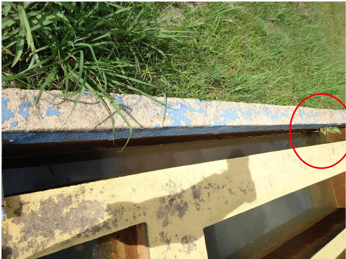
Figura 169 – Passagem do floculador para decantador.
