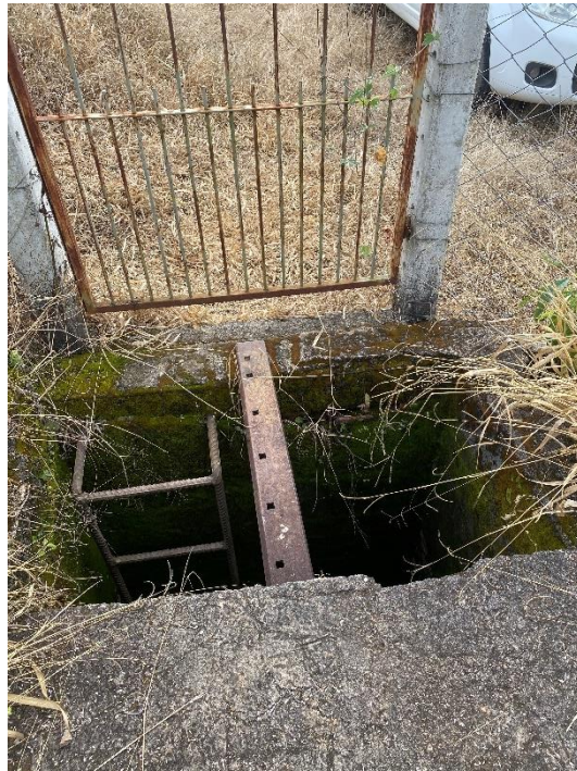
Figura 148 – Entrada do Reservatório EEAT.
