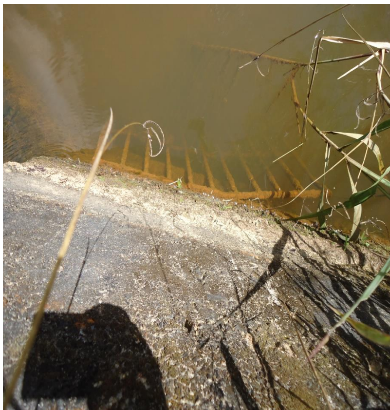
Figura 8 – Crivo na Tubulação da Captação São Felipe.
