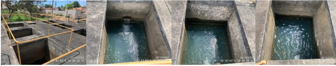
Figura 117 – Estruturas dos Filtros.
