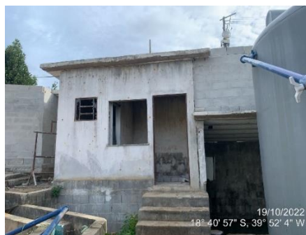
Figura 184 – Edificação de Apoio.
