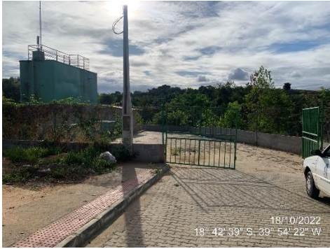
Figura 154 – ETE Residencial Solar
