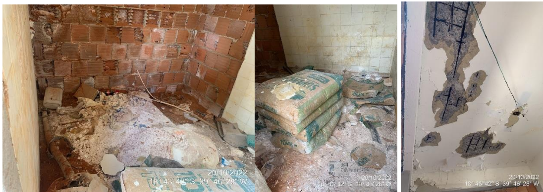
Figura 124 – Armazenamento dos produtos químicos.
