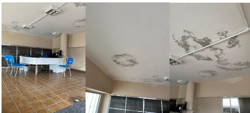
Figura 48– Escritório da Oficina da ETA de São Mateus.
