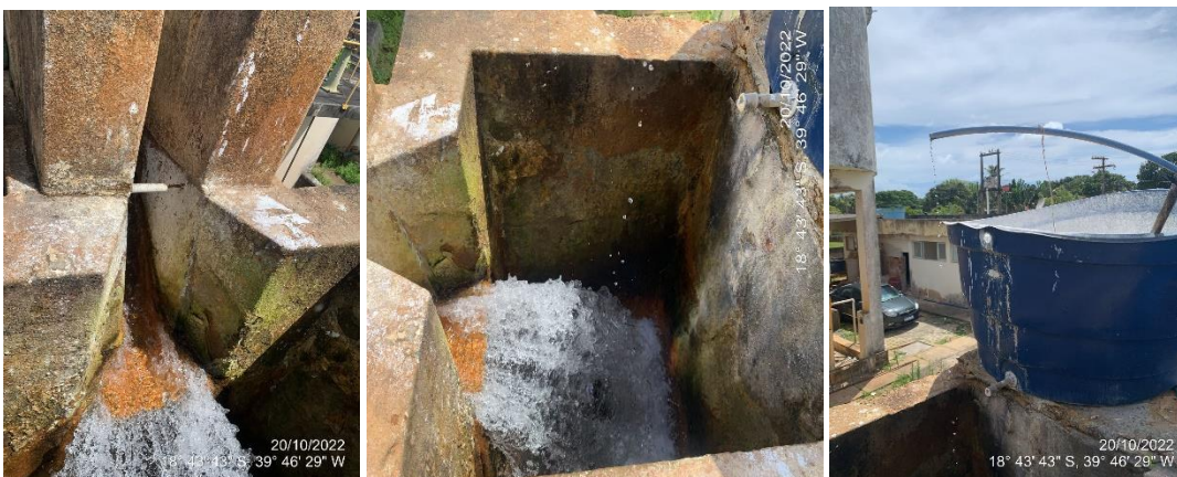
Figura 111 – Calha parshall
