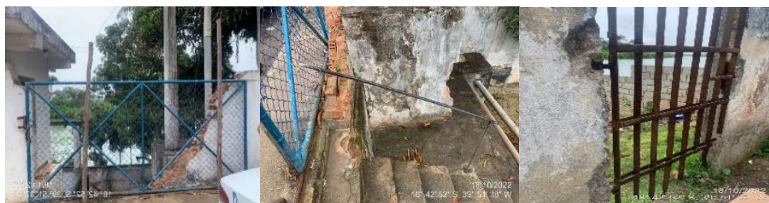
Figura 2 – Acesso a EEAB da Sede de São Mateus.
