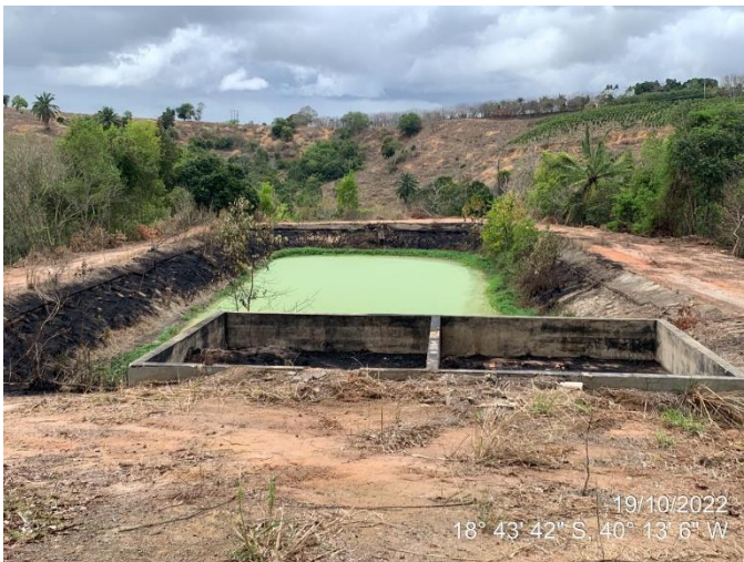
Figura 166 – Estrutura para Leito de Secagem.
