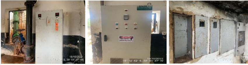
Figura 5 – Painel de controle da EEAB da Sede do município de São Mateus.
