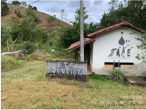
Figura 85 – Entrada da ETA e EEAT de Nova Vista.
