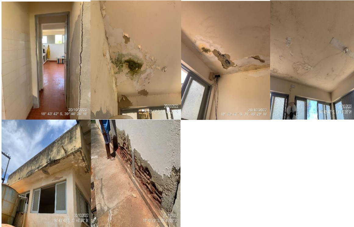
Figura 123 – Laboratório e casa de apoio aos colaboradores
