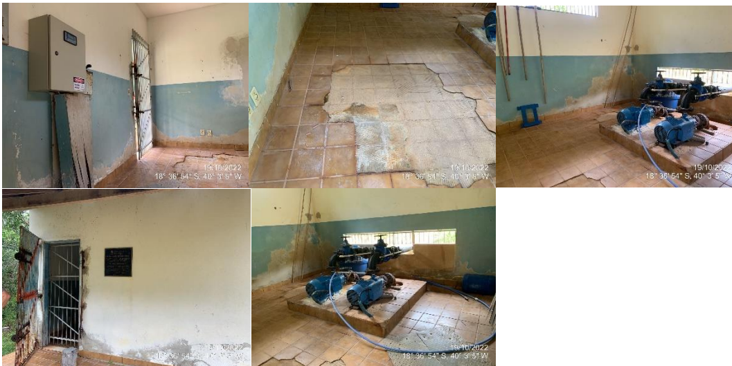
Figura 86 – EEAT de Nova Vista.
