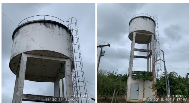
Figura 102 – Reservatório Elevado Nova Lima.
