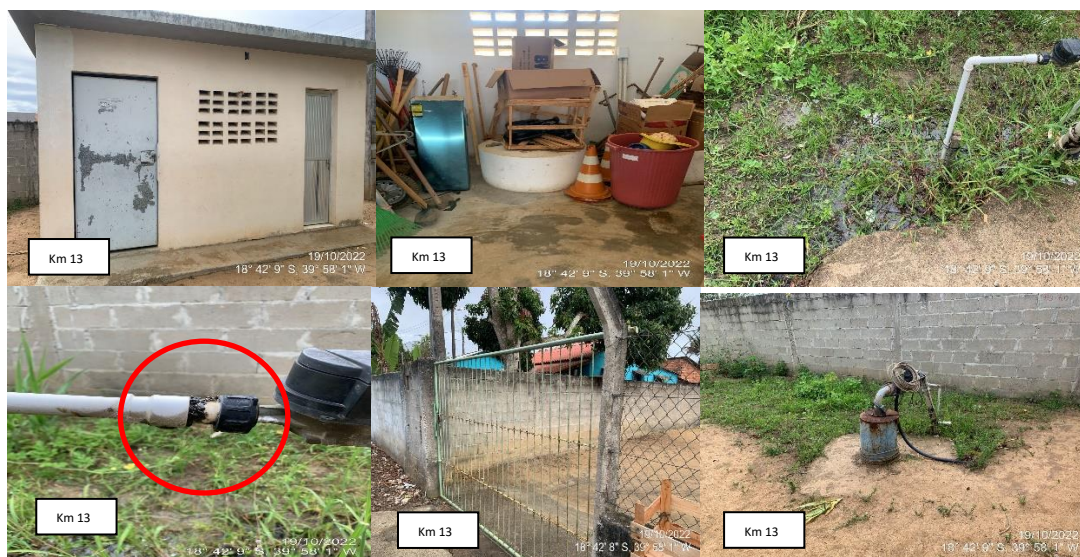
Figura 63 – Poço Nossa Senhora Guadalupe – KM 13.
