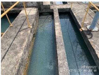
Figura 114 – Estrutura de passagem para decantador.
