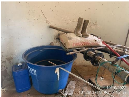
Figura 91 – Dosador sem utilização.
