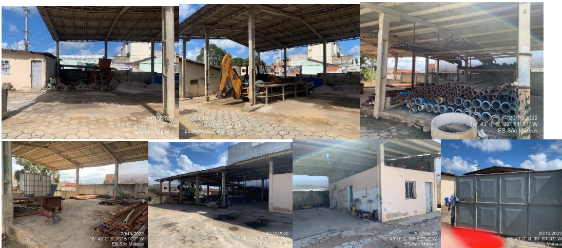
Figura 198 - almoxarifado de tubos.
