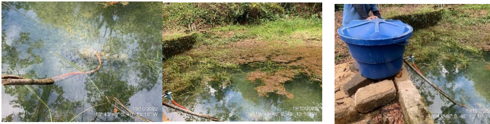
Figura 80 – Captação do KM 41.
