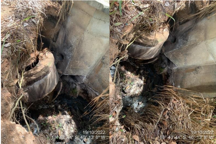
Figura 165 – PV de Chegada do esgoto Bruto.
