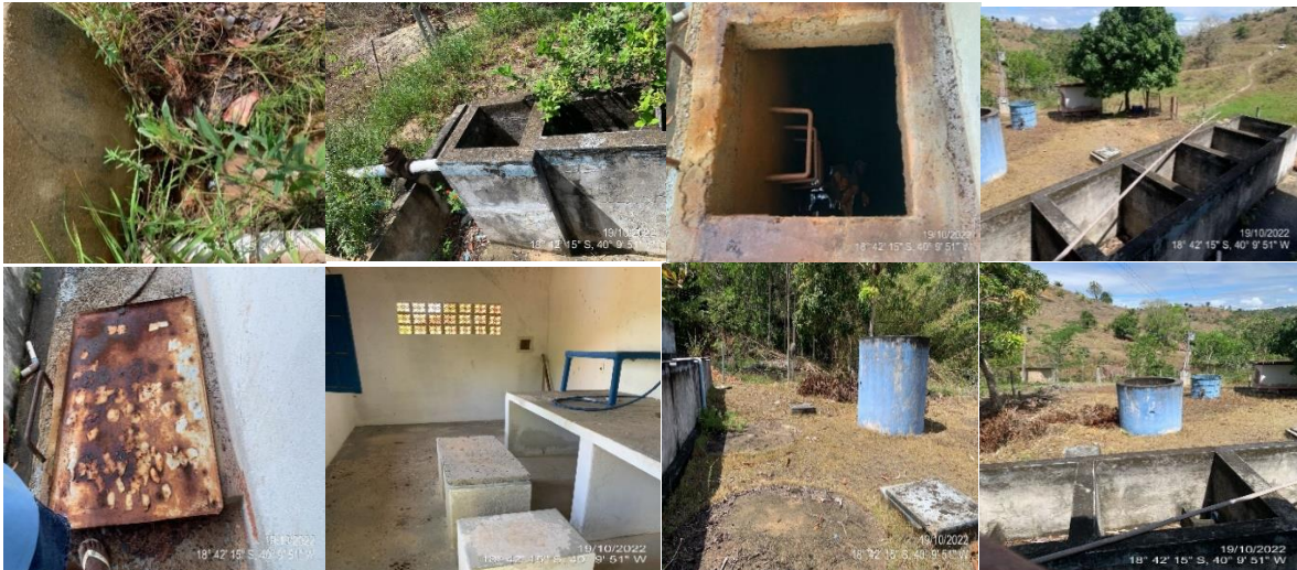
Figura 75 - ETA Desativada ( Chegada da água bruta, floculador, reservatórios).
