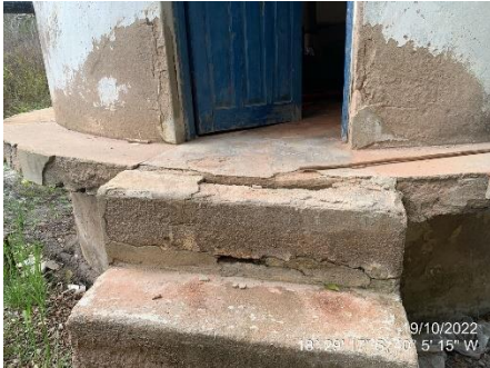
Figura 92 – Escada de Acesso a EEAT.
