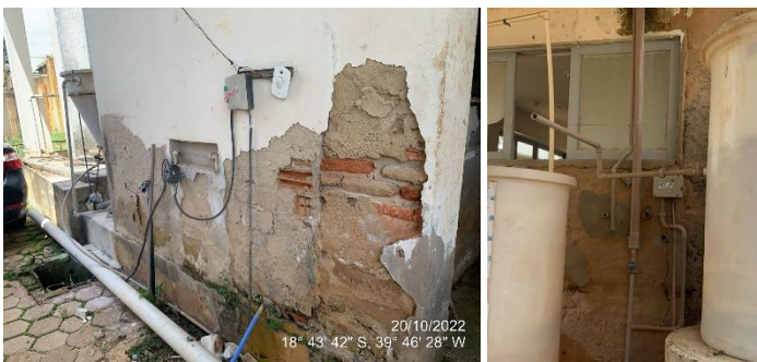
Figura 109 – Painel de Controle do flúor e cloro.
