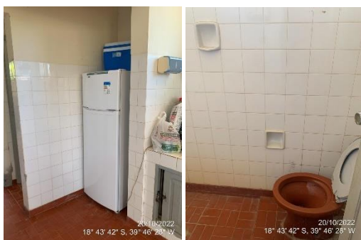
Figura 121 – água potável e banheiro.
