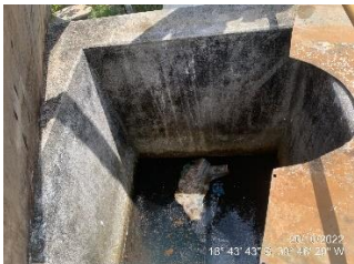
Figura 115 – Tanque de contato com Sacola dentro.
